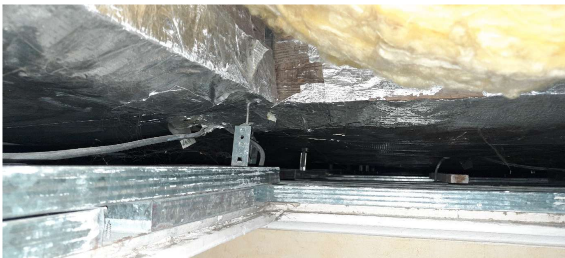
Zavěšený podhled pod střešní konstrukcí
