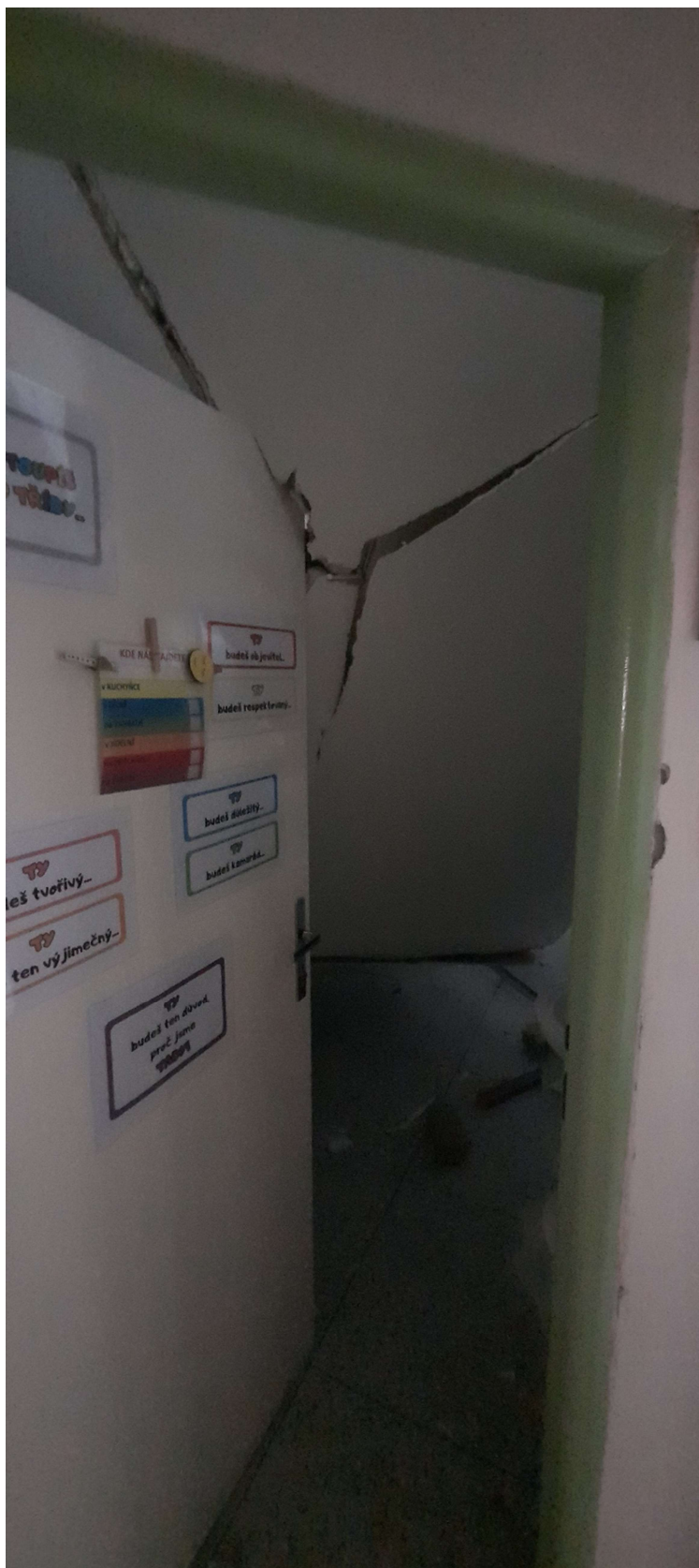
Konstrukce podhledu nad vedlejší učebnou, zřícený pohled je v pozadí a vlevo.
