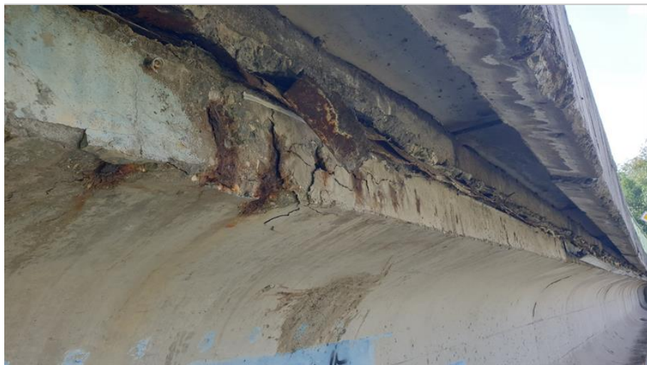
21-Zatékání a rozpad betonu krajního nosníku u OP1.jpg
