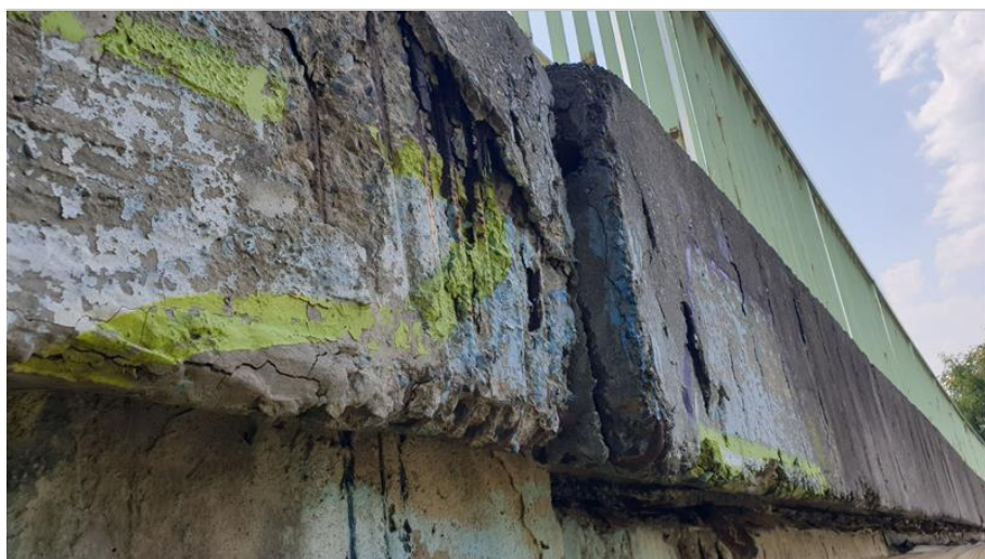
23-Rozpadlá římsa u MZ OP1 koroze výztuže.jpg
