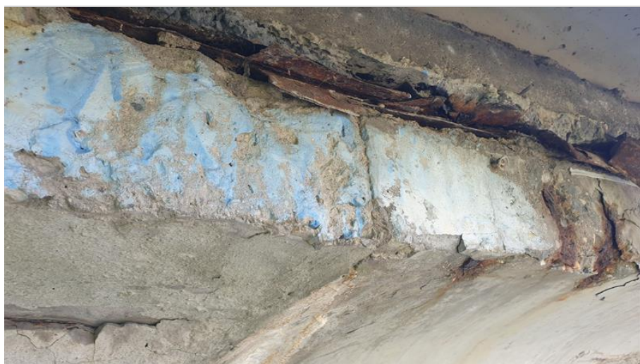
20-Rozpadlý okapový plech na nosníku.jpg
