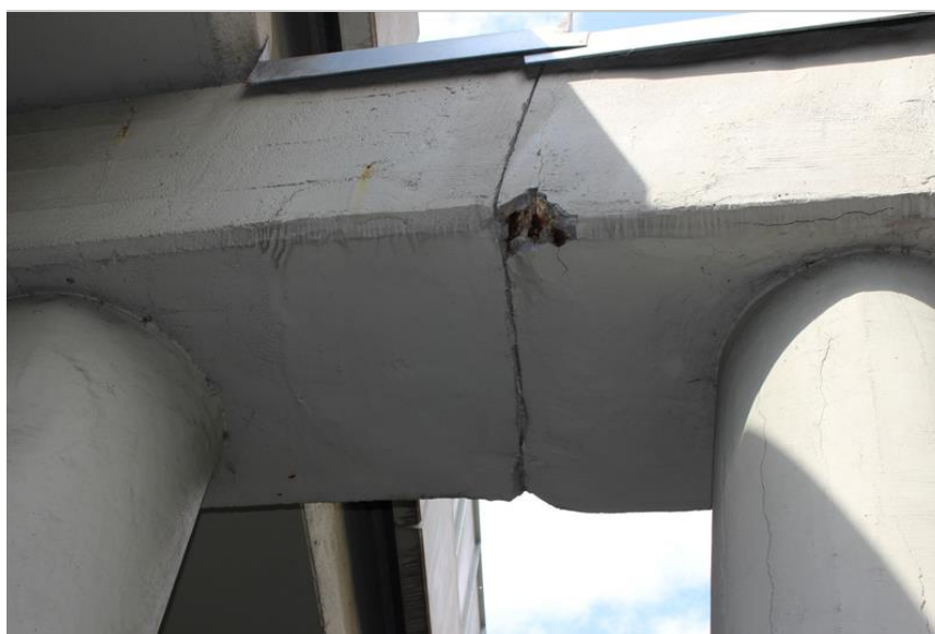
20-detail stativa pilíře P3 vpravo - odprýsknutý roh stativa-obnažená výztuž.JPG
