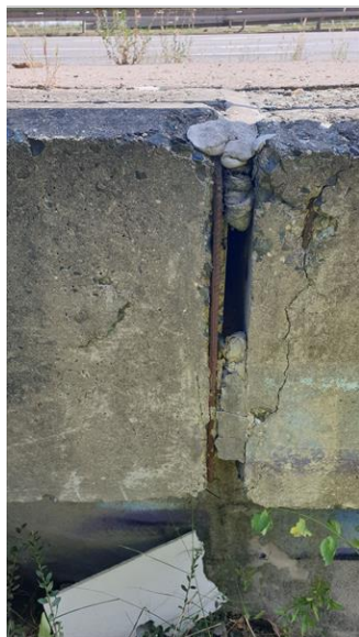
25-Zatěsnění spáry v římsě.jpg
