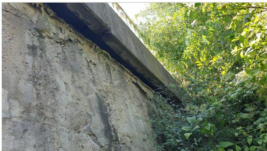
39-Zatékání na spodní stavbu rozpad povrchových vrstev.jpg
