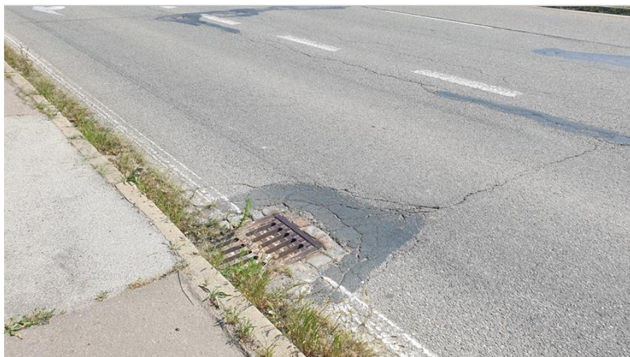
48-Rozpad vozovky u odvodňovače před mostem.jpg
