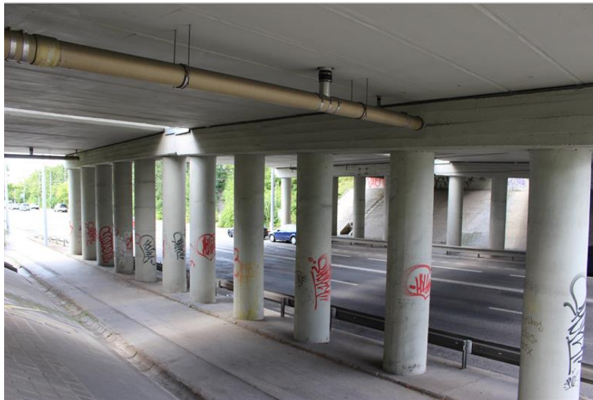
12-pohled na pilíř P3 - podhled NK - svody odvodnění.JPG
