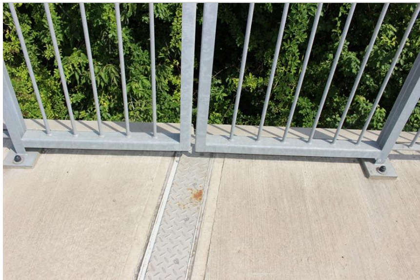
22-krycí plech MZ nad opěrou 1 - počínající koroze.JPG
