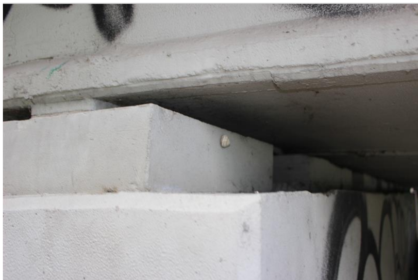
17-uložení krajního nosníku na opěře 4.JPG
