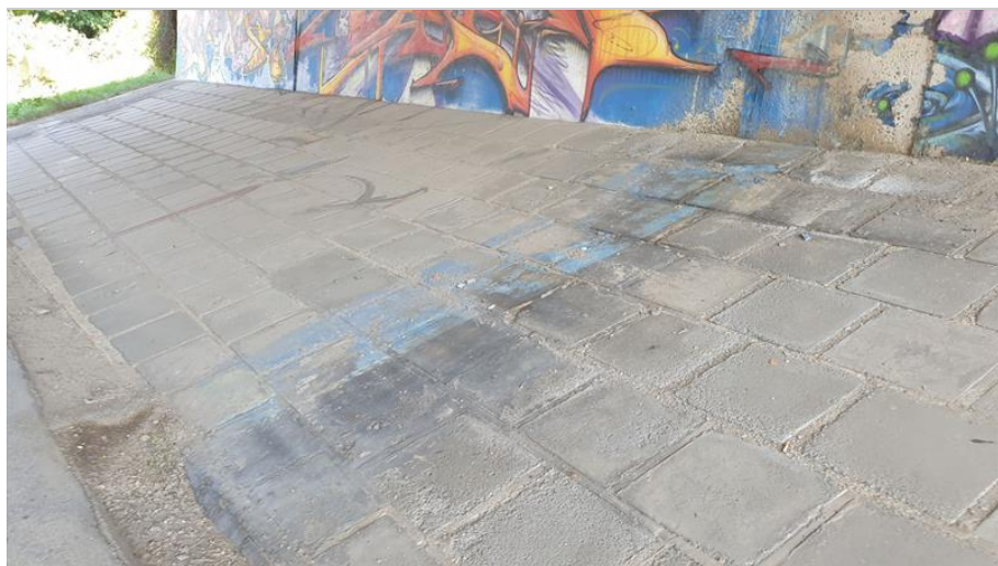
07-Splavení materiálu na odláždění mezi mosty.jpg
