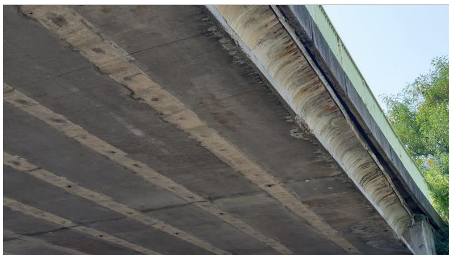
17-Zatékání na krajní nosník NK.jpg
