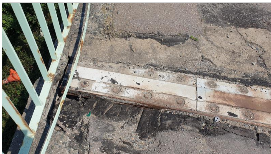
53-MZ v římse rozpad betonu okolo profilů.jpg
