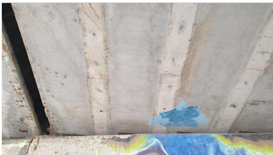
14-Stopy po lehkém zatékání mezi mosty.jpg
