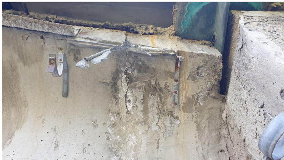
37-Zatékání na konec nosníku u OP2.jpg
