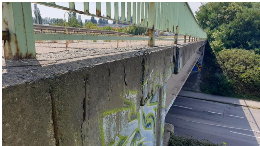
26-Pohled na vnější římsu koroze degradace betonu.jpg
