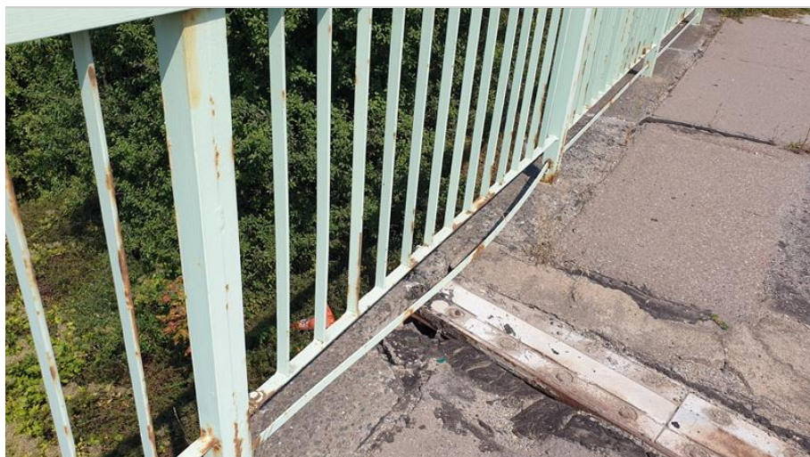
45-Vybočený profil zábradlí.jpg
