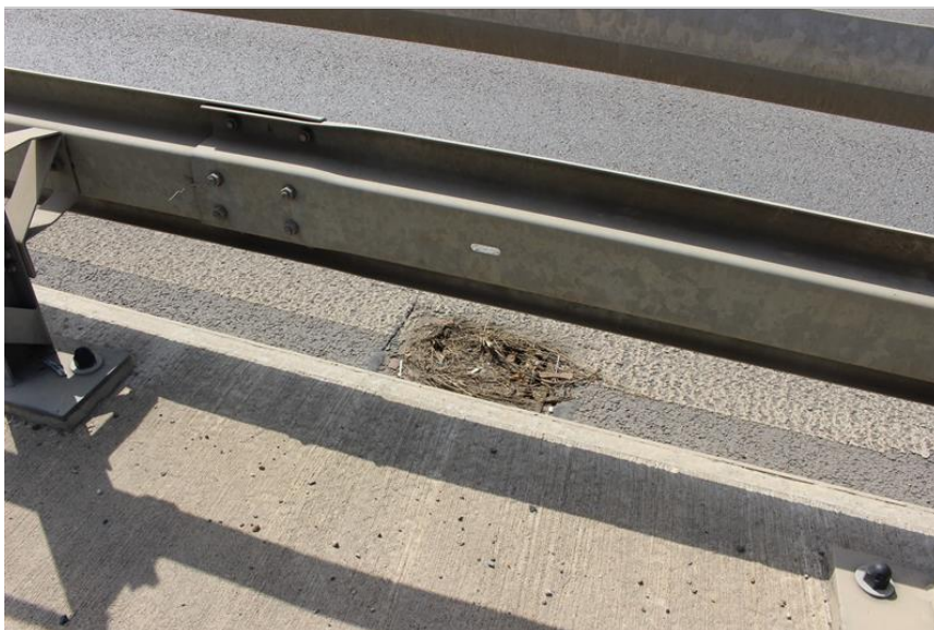
05-detail zaneseného odvodňovače.JPG
