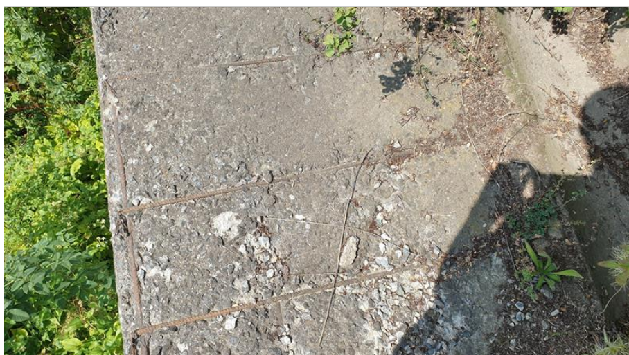
27-Pohled na vnější římsu koroze degradace betonu.jpg
