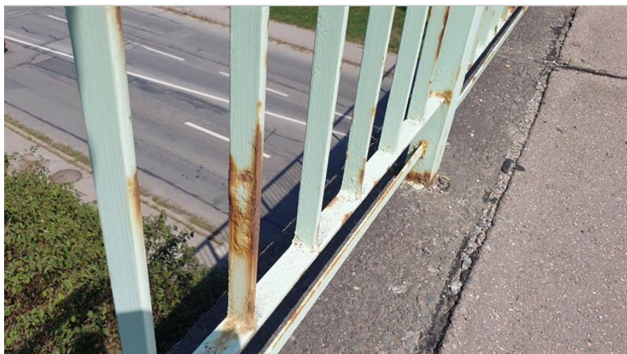
42-Koroze zábradlí.jpg
