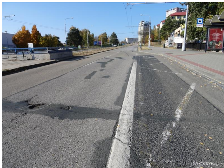
28.JPG Kryt vozovky směr Bystř v pohledu od začátku mostu ve směru jízdy. Příčná trhлина nad Op1 s výtlukem
