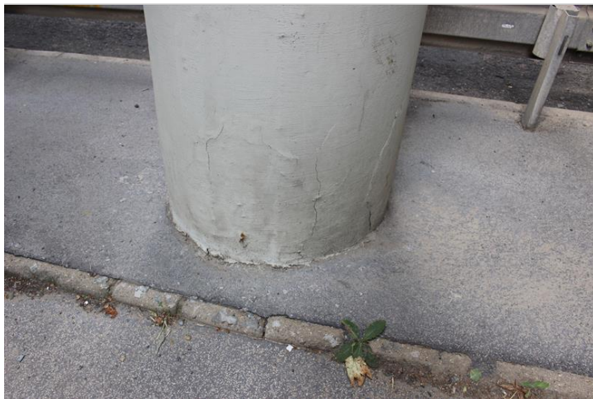
21-svislé trhliny v sanaci sloupu pilíře P3.JPG
