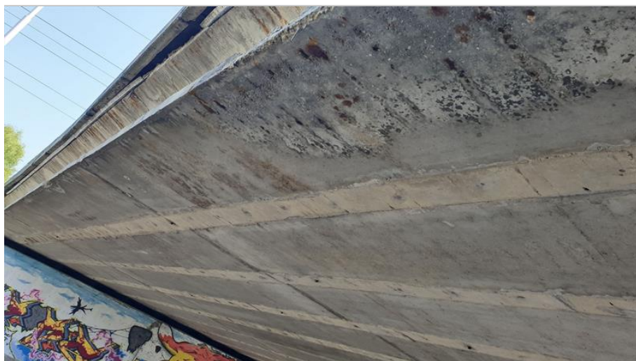
13-Stopy po zatékání na krajní nosník NK.jpg
