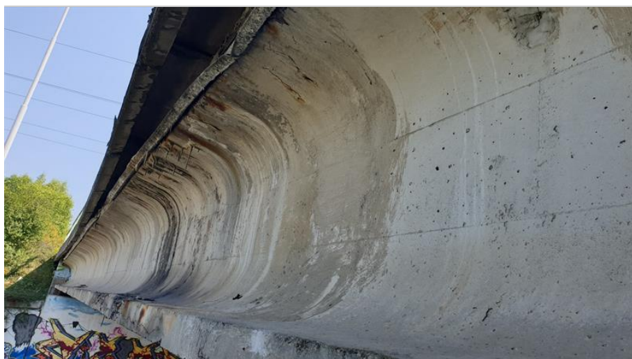
38-Stopy po zatékání na krajní nosník.jpg
