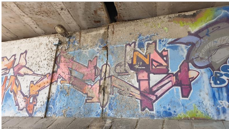
10-Zatékání mezi NK mostů na opěru OP2.jpg
