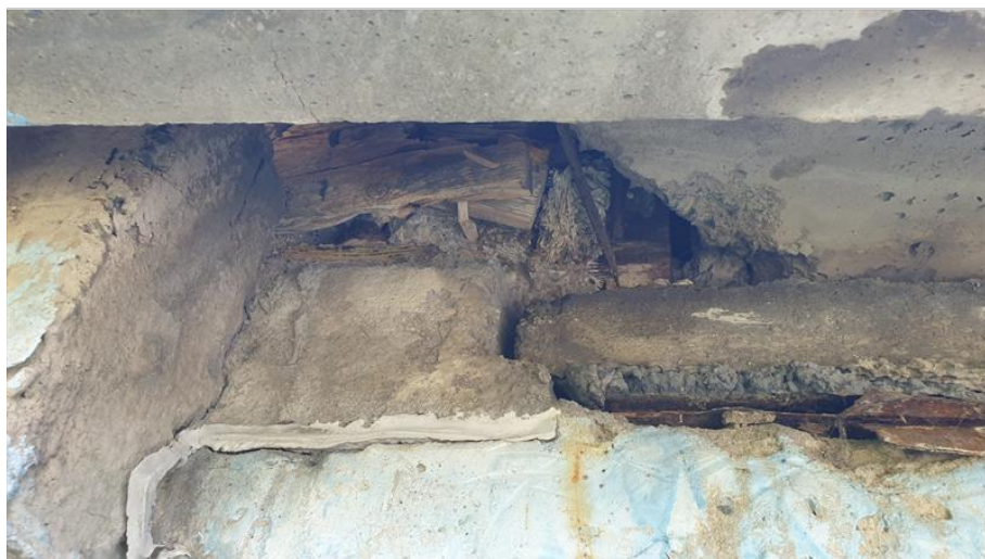
21-Dobetonávka NK u OP1 zbytky bednění zatékání.jpg
