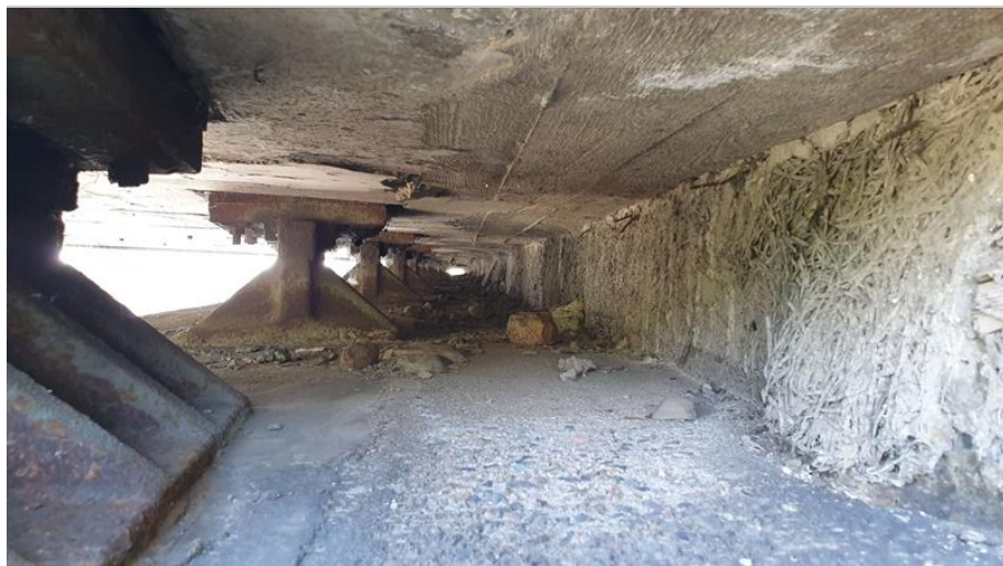
34-Pevná ložiska u OP2 nečistoty na UP.jpg
