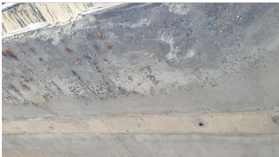
18-Zatékání na krajní nosník- koroze a rozpad betonu.jpg
