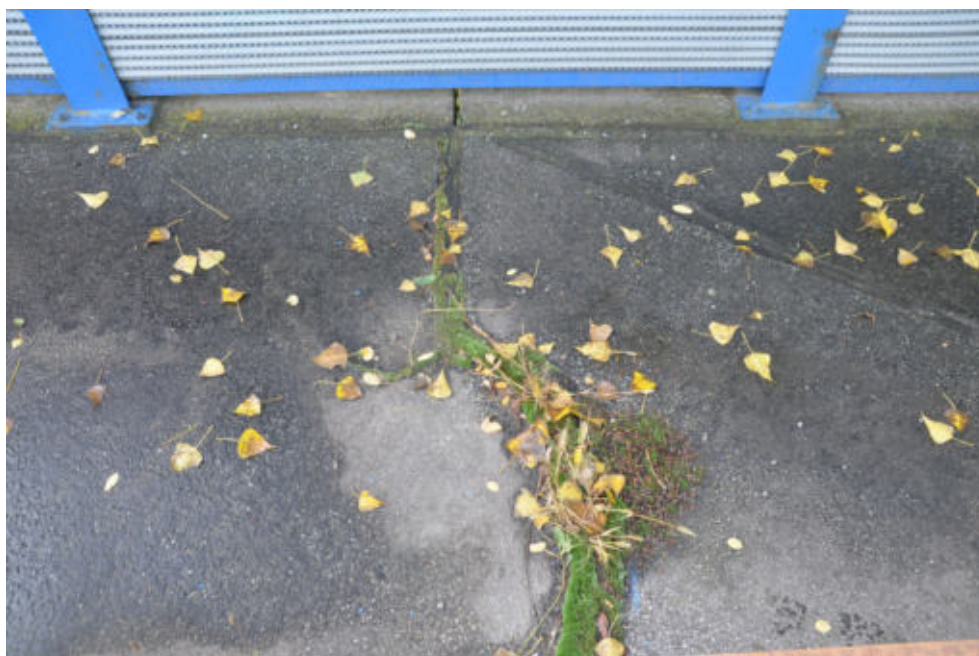
Obr.F78-40 Chodník na pravé straně mostu v místě předpokládaného podpovrchového MZ nad první podpěrrou, znojemskou opěrou. Pohled zleva doprava a dolů,
