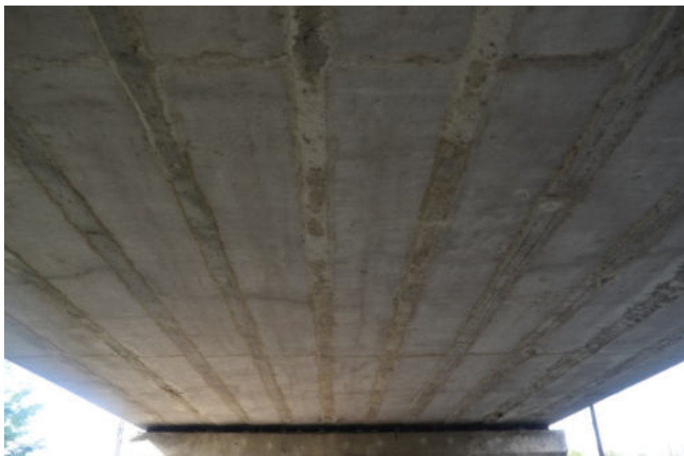
Obr.F78-33 Podhled první poloviny NK třetího pole mostu (zcela vpravo nosník č.1). Pohled od 4. podpěry, brněnské opěry proti směru staničení a vzhůru,
