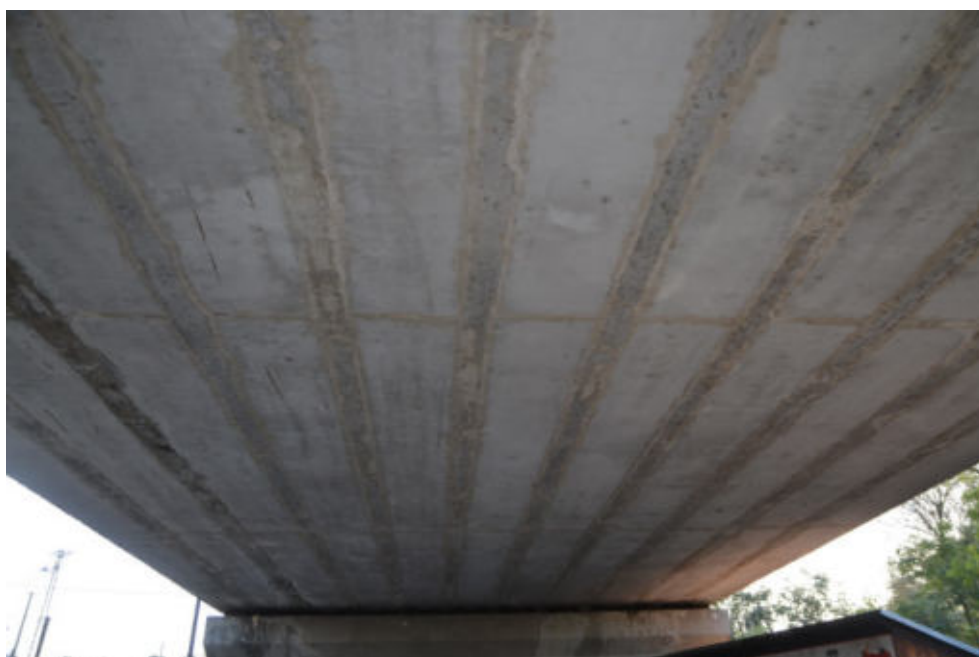
Obr.F78-32 Podhled druhé poloviny NK druhého pole mostu (zcela vlevo nosník č.1). Pohled od 2. mezilehlé podpěry, ve směru staničení a vzhůru,
