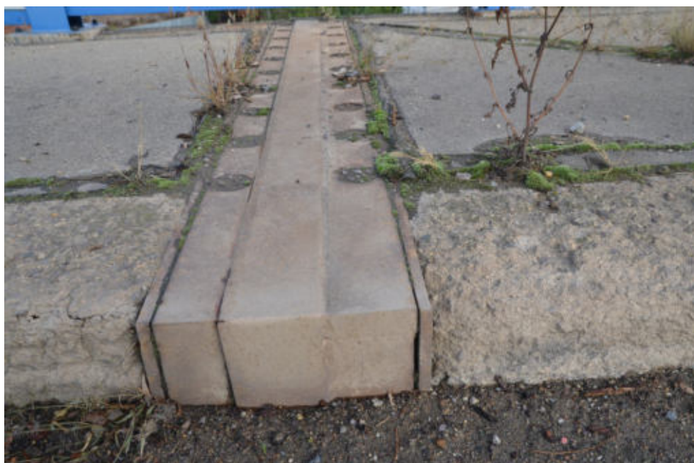
Obr.F78-42 Levý chodník v místě MZ nad druhou mezilehlou podpěrrou. Pohled zprava doleva a dolů,
