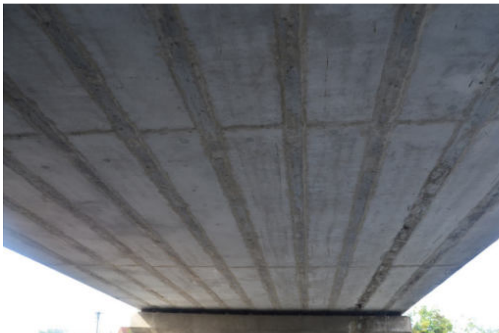
Obr.F78-30 Podhled první poloviny NK druhého pole mostu (zcela vpravo nosník č.1). Pohled od 3. mezilehlé podpěry, proti směru staničení a vzhůru,
