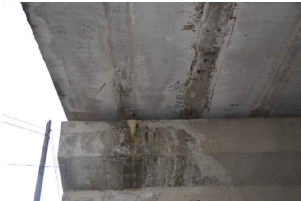
Obr.F78-17 Detail úložného prahu na levé straně třetí, mezilehlé podpěry. Pohled ve směru staničení a vzhůru,
