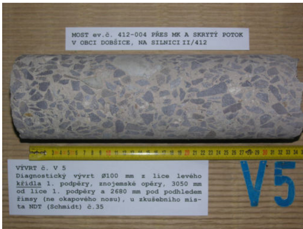
Obr. F78-305 VÝVRT č. V5. Diagnostický vývrt Ø100 mm z líce levého křídla 1. podpěry, znojenské opěry , 3050 mm od líce 1. podpěry a 2680 mm pod podhledem římsy (ne okapového nosu), u zkušebního místa NDT (Schmidt) č.35.
