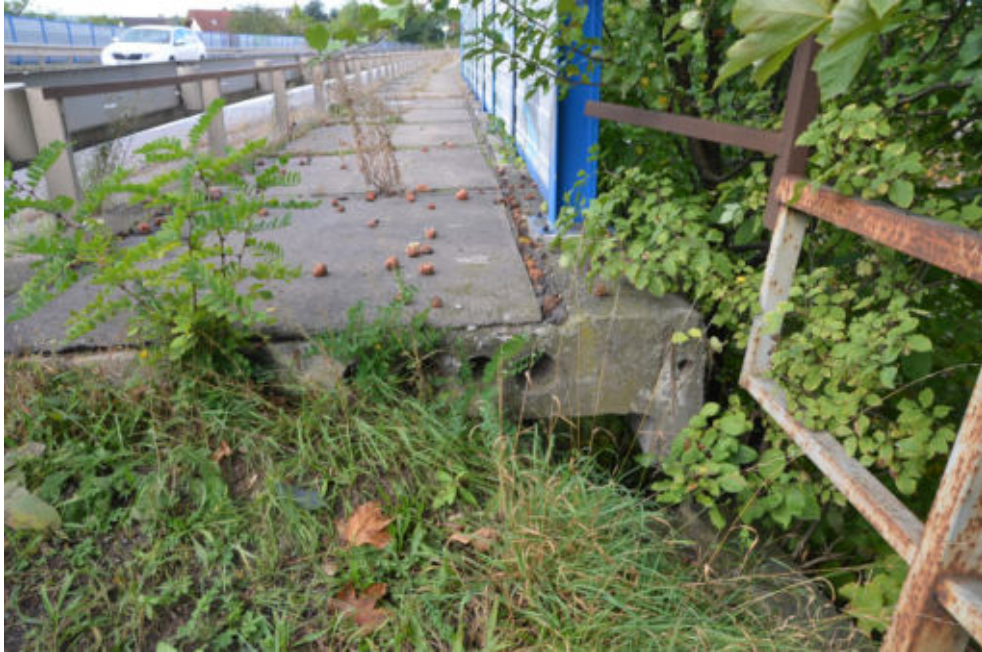
Obr.F78-55 Levostranný okraj vozovky, chodník, římsa a protihlukové zábrany na konci mostu. Pohled proti směru staničení a dolů,
