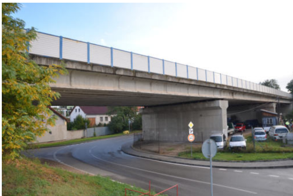
Obr.F78-04 Pravá (povodní) strana mostu. Pohled zprava doleva a ve směru staničení,
