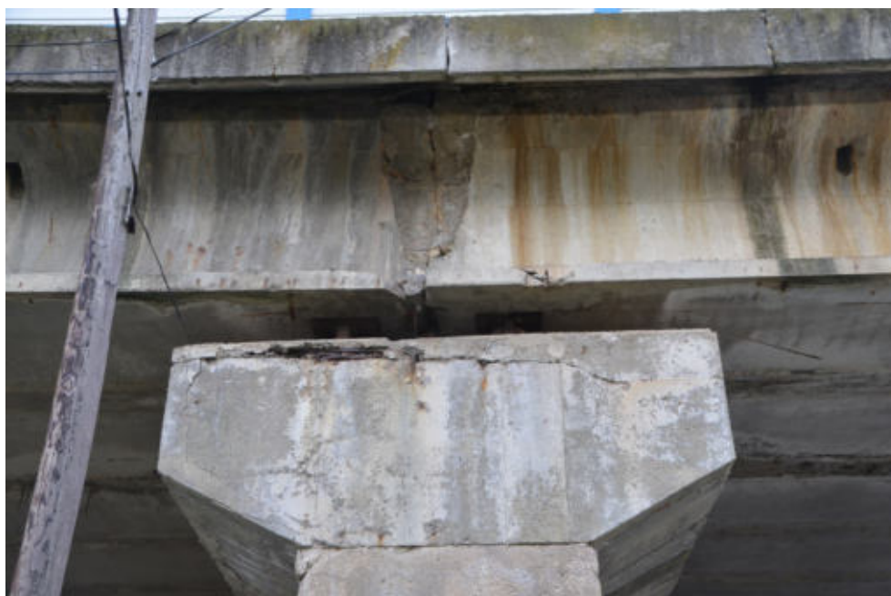
Obr.F78-18 Detail úložného prahu třetí, mezilehlé podpěry (levé čelo). Pohled zleva doprava a vzhůru,
