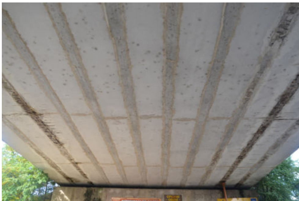
Obr.F78-27 Podhled první poloviny NK prvního pole mostu (zcela vpravo nosník č.1). Pohled od 2. mezilehlé podpěry, proti směru staničení a vzhůru,
