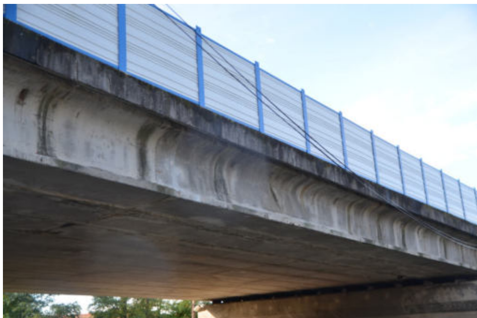
Obr.F78-22 Levá fasáda mostu ve 3.poli. Pohled zleva doprava a proti směru staničení,
