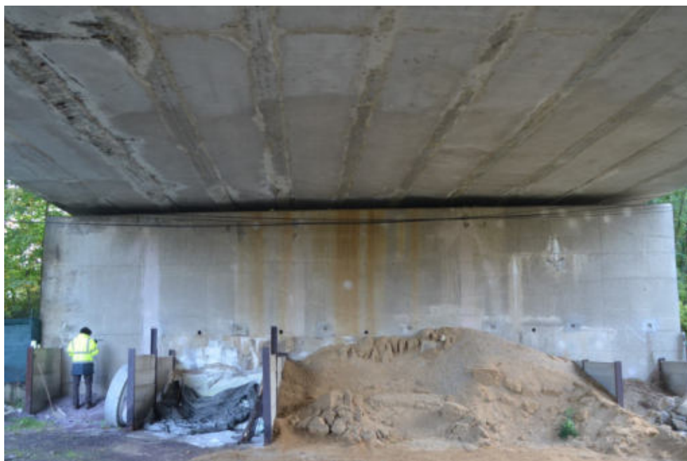
Obr.F78-06 Čtvrtá podpěra, brněnská opěra. Pohled na její líc ve směru staničení,
