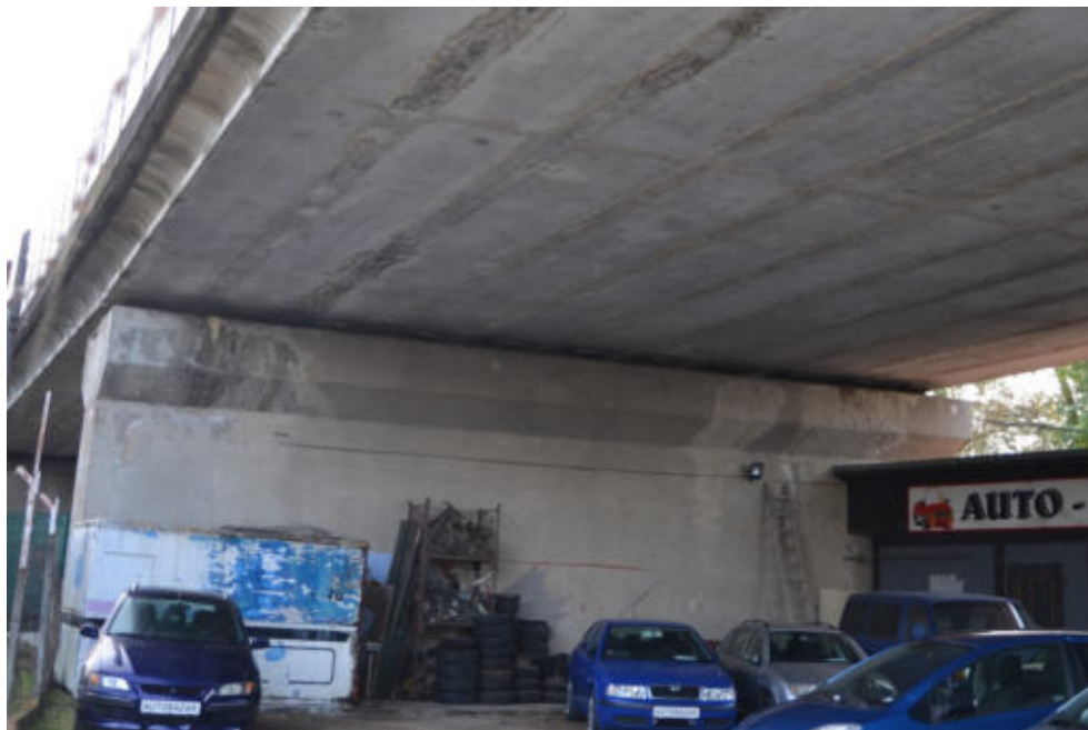
Obr.F78-15 Třetí, mezilehlá podpěra, přední líc. Pohled ve směru staničení a zleva doprava,
