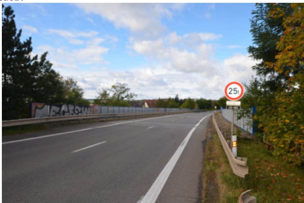
Obr.F78-02 Průhled levým okrajem vozovky na mostě. Pohled proti směru staničení od Brna ke Znojmu,
