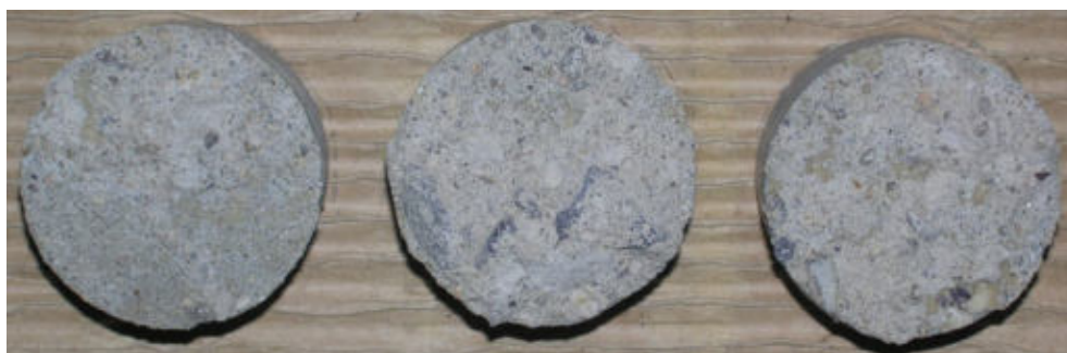
Obr.F78-200 Zkušební terče číslo 62, 84, 142 (zkušební místo 1) po provedení odtrhu.
