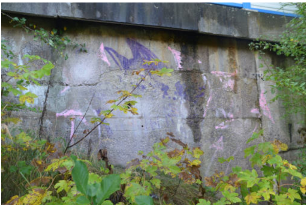
Obr.F78-09 Levé křídlo 4. podpěry, brněnské opěry. Pohled zleva doprava a proti směru staničení,
