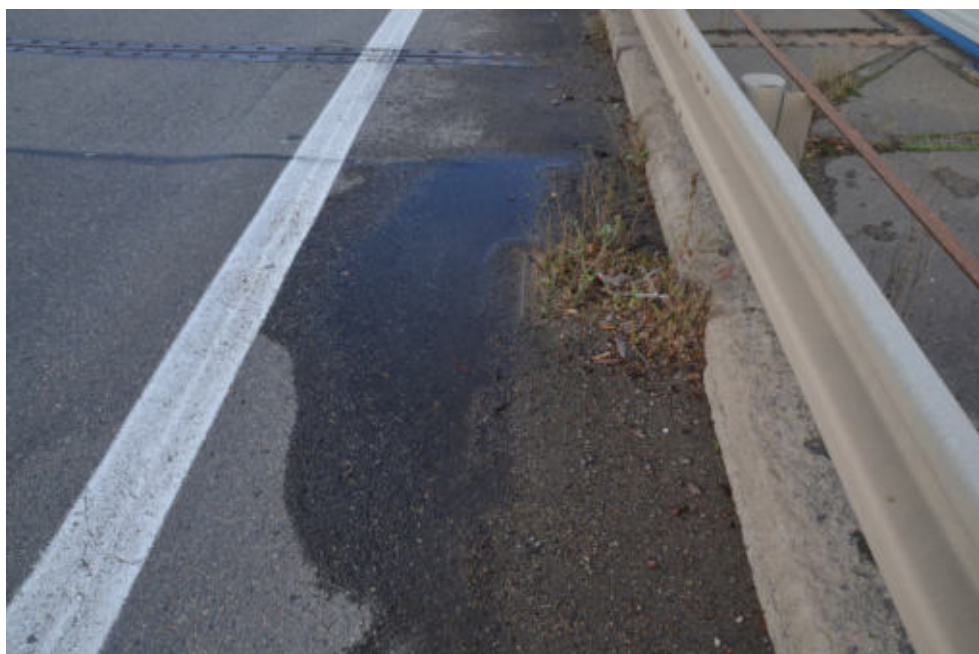
Obr.F78-54 Jeden ze tří odvodňovačů u levého okraje vozovky. Pohled proti směru staničení a dolů,
