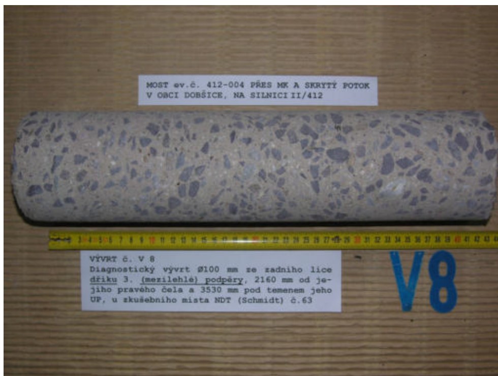
Obr. F78-308 VÝVRT č. V8. Diagnostický vývrt Ø100 mm ze zadního líce dříku 3. (mezilehlé) podpěry , 2160 mm od jejího pravého čela a 3530 mm pod temenem jeho UP, u zkušebního místa NDT (Schmidt) č.63.
