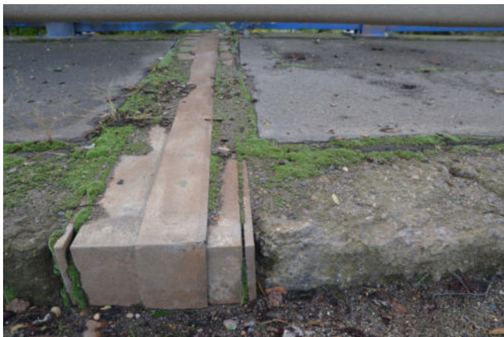
Obr.F78-49 Pravý chodník v místě MZ nad čtvrtou podpěrrou, brněnskou opěrou. Pohled zleva doprava a dolů,
