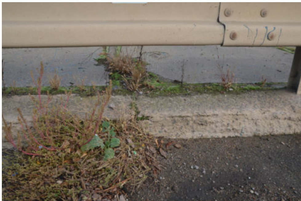
Obr.F78-39 Chodník na levé straně mostu v místě předpokládaného podpovrchového MZ nad první podpěrrou, znojemskou opěrou. Pohled zprava doleva a dolů,
