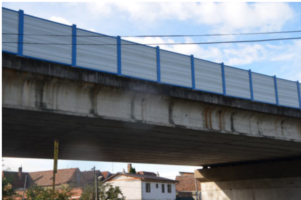
Obr.F78-21 Levá fasáda mostu ve 2.poli. Pohled zleva doprava a proti směru staničení,
