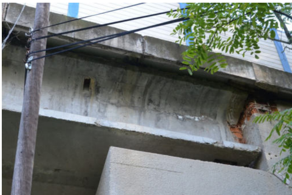
Obr.F78-26 Detail uložení konce nosníku č.11 na čtvrté podpěře, brněnské opěře. Pohled zprava doleva a vzhůru,
