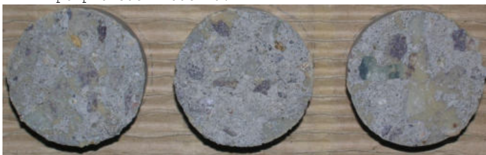
Obr.F78-202 Zkušební terče číslo 18, 56, 92 (zkušební místo 3) po provedení odtrhu.
