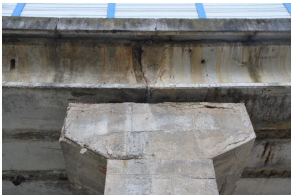
Obr.F78-14 Detail úložného prahu druhé, mezilehlé podpěry (levé čelo). Pohled zleva doprava a vzhůru,
