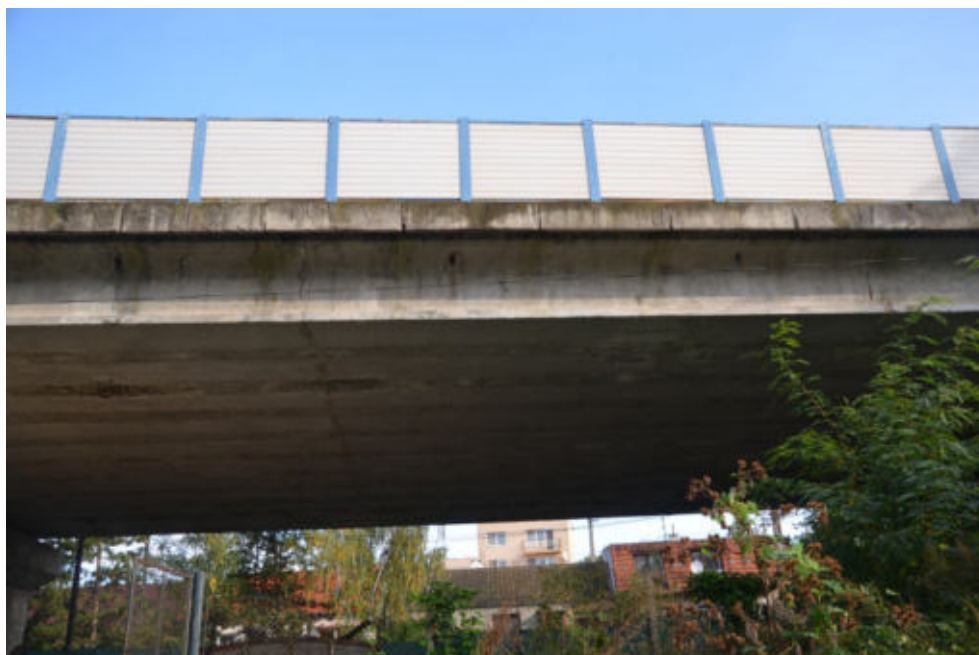
Obr.F78-25 Pravá fasáda mostu ve 3.poli. Pohled zprava doleva a vzhůru,
