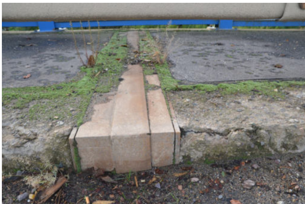
Obr.F78-46 Pravý chodník v místě MZ nad třetí mezilehlou podpěrrou. Pohled zleva doprava a dolů, - okolí MZ znečištěno, místy růst travin, - zanesený těsnicí profil MZ posypovým materiálem a dalšími splaveninami.
