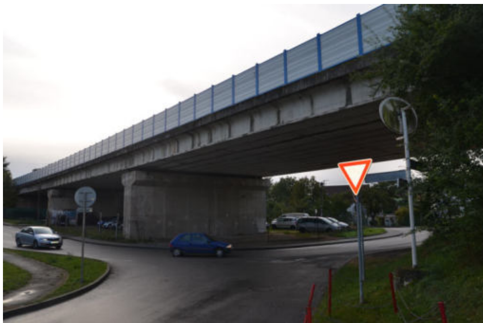
Obr.F78-03 Levá (návodní) strana mostu. Pohled ve směru staničení a zleva doprava,
