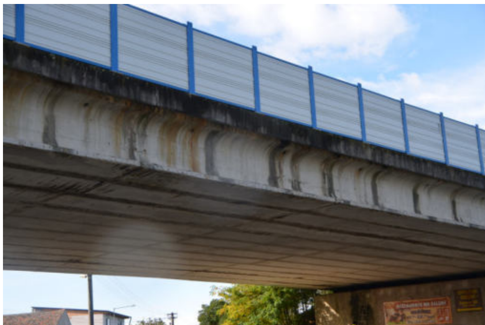
Obr.F78-20 Levá fasáda mostu v 1.poli. Pohled zleva doprava a proti směru staničení,
