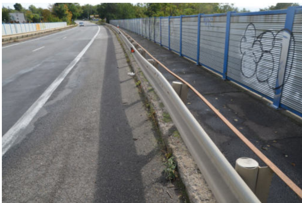
Obr.F78-53 Průhled pravou krajnicí za první podpěrou, znojemskou opěrou. Pohled ve směru staničení a dolů,
