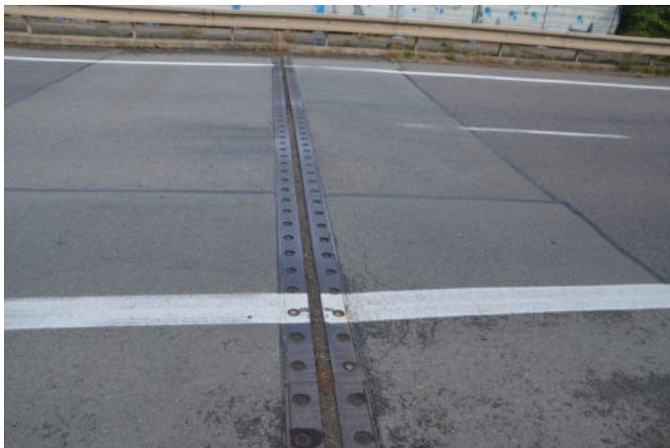
Obr.F78-47 Vozovka v místě MZ nad čtvrtou podpěrrou, brněnskou opěrou. Pohled zprava doleva a dolů,
