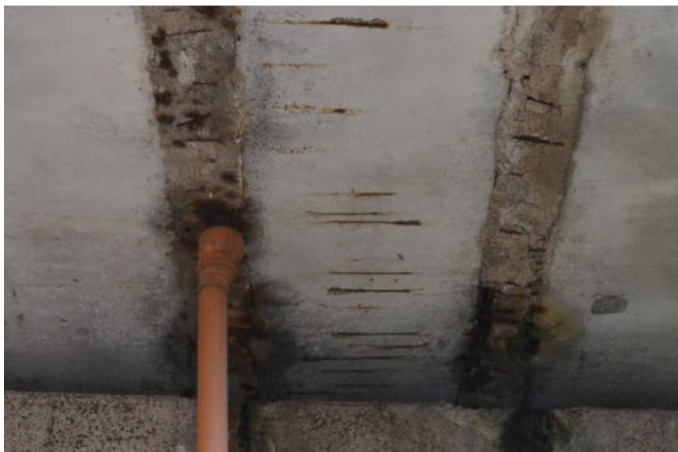
Obr.F78-28 Detail podélné spáry č.1 a č.2 v 1. poli. Pohled proti směru staničení a vzhůru
