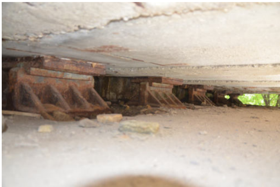
Obr.F78-35 Pevné ložiska č.1 až č.5 na první podpěře, znojemské opěře. Pohled proti směru staničení a zprava doleva,
