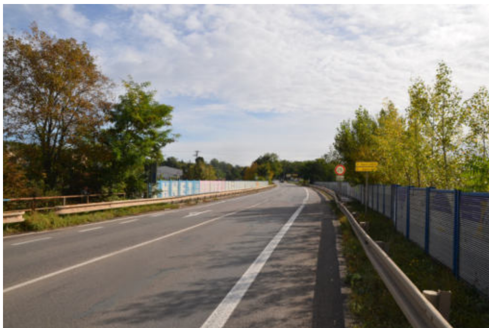
Obr.F78-01 Průhled pravým okrajem vozovky na mostě. Pohled ve směru staničení od Znojma k Brnu,
