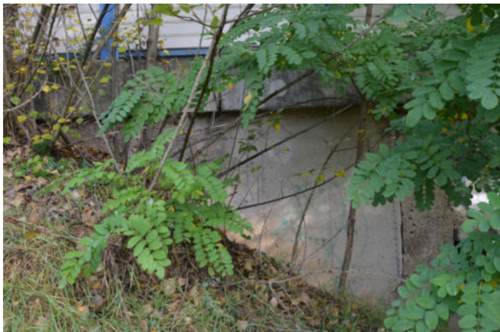
Obr.F78-08 Pravé křídlo 1. podpěry, znojemské opěry. Pohled zprava doleva,
