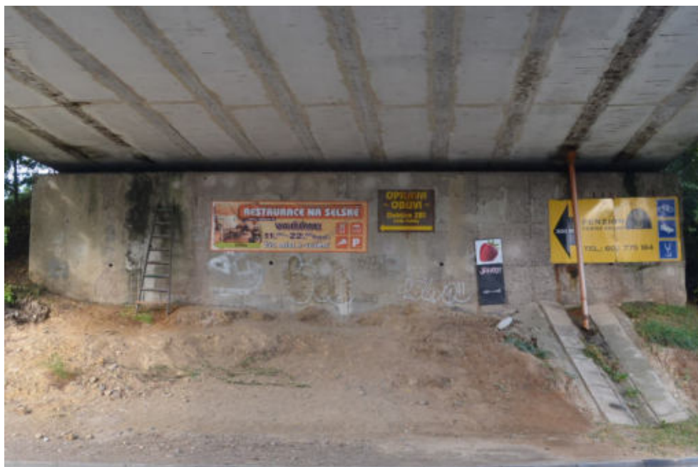
Obr.F78-05 První podpěra, znojemská opěra. Pohled na její líc proti směru staničení,
