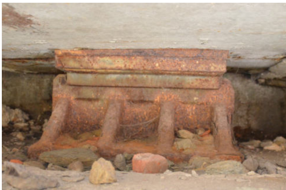
Obr.F78-35 Detail pevného ložiska č.6 na první podpěře, znojemské opěře. Pohled proti směru staničení,
