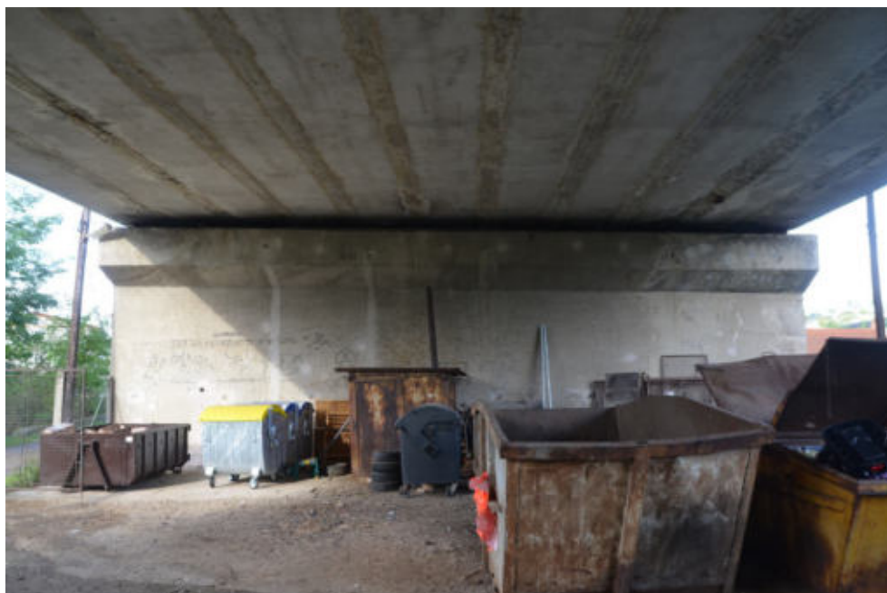
Obr.F78-16 Třetí, mezilehlá podpěra, zadní líc. Pohled proti směru staničení,
