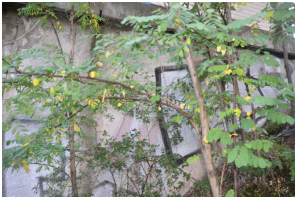
Obr.F78-10 Pravé křídlo 4. podpěry, brněnské opěry. Pohled zprava doleva a ve směru staničení,
