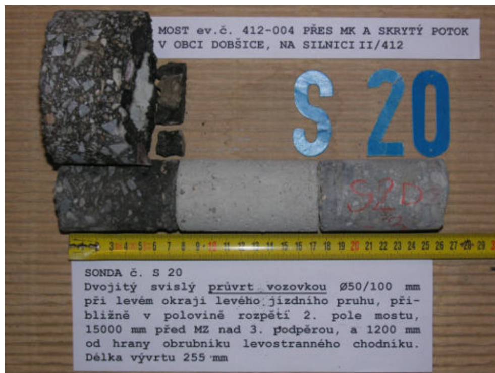
Obr.F78-100 SONDA č. S20. Dvojitý svislý průvrt vozovkou a spádovou vrstvou ø50/100 mm při levém okraji levého jízdního pruhu, přibližně v polovině rozpětí 2. pole mostu, 15000 m před MZ nad 3. podpěrrou a 1200 mm od hrany obrubníku levostranného chodníku. Délka vývrtu 255 mm.
