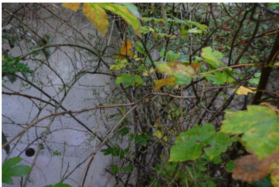
Obr.F78-07 Levé křídlo 1. podpěry, znojemské opěry. Pohled zleva doprava a proti směru staničení,
