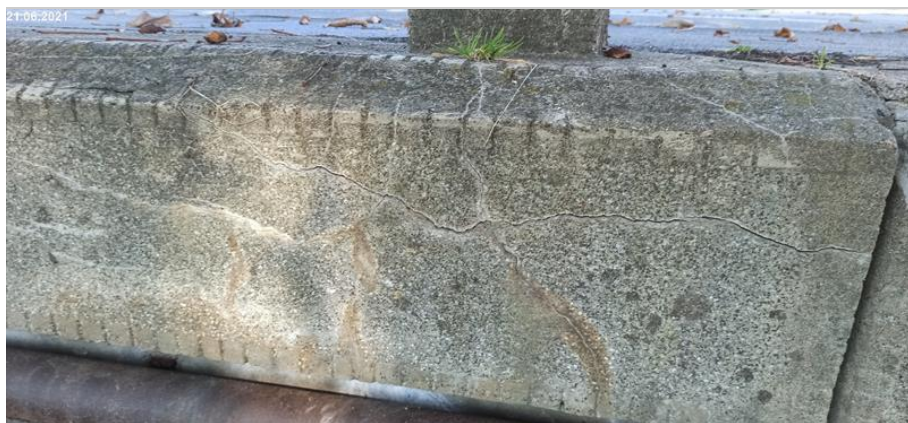
08.Trhliny v římse vlevo.jpg
