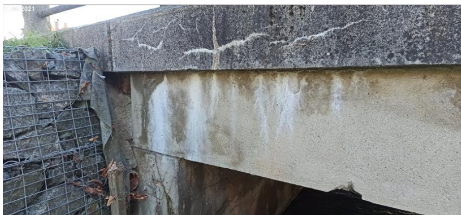
17.Vápenné výluhy na NK vpravo.jpg
