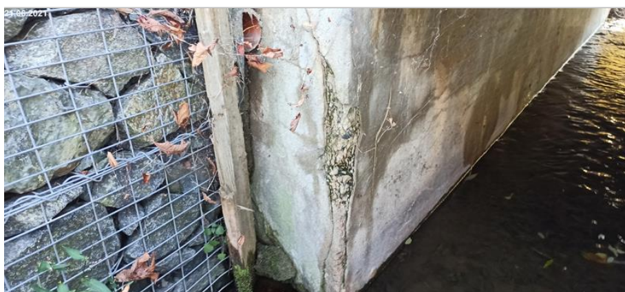
18.Rozpad povrchu OP2 vlevo.jpg
