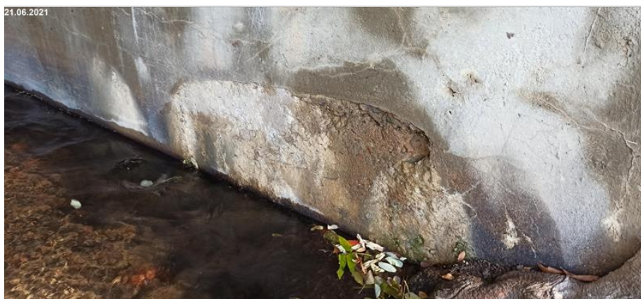
11.Navlhle zdivo odpadávající omítka na OP1.jpg
