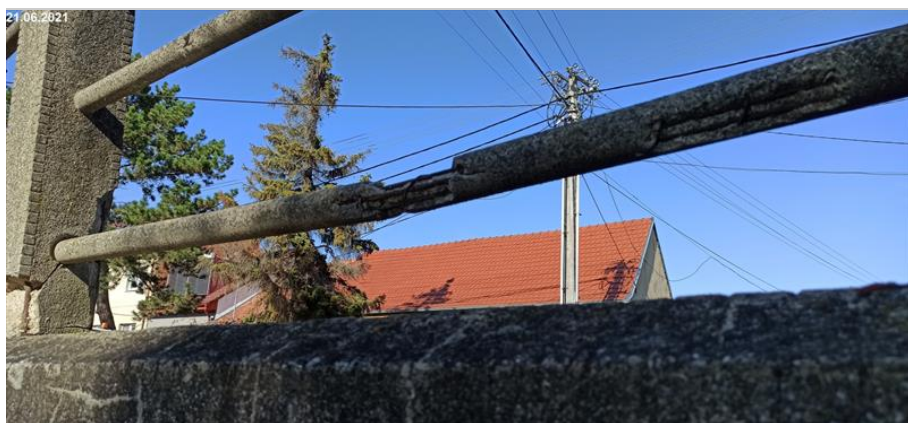
09.Rozpad záchytného zařízení na mostě.jpg
