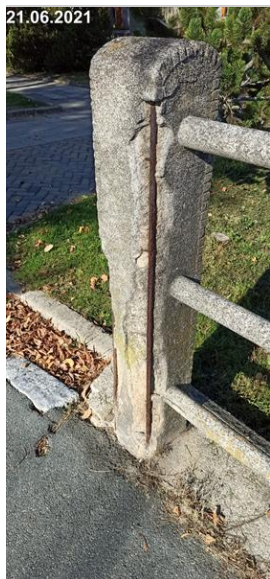
19.Rozpad sloupku záchytného zařízení.jpg
