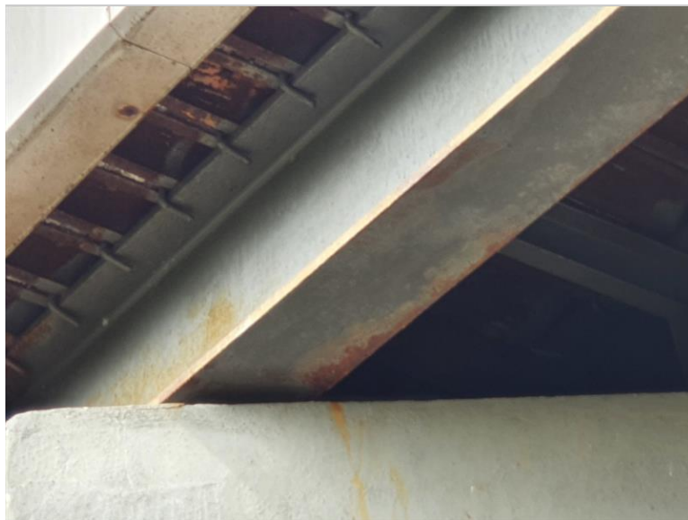
Koroze nosníku NK i profilů mostovky
