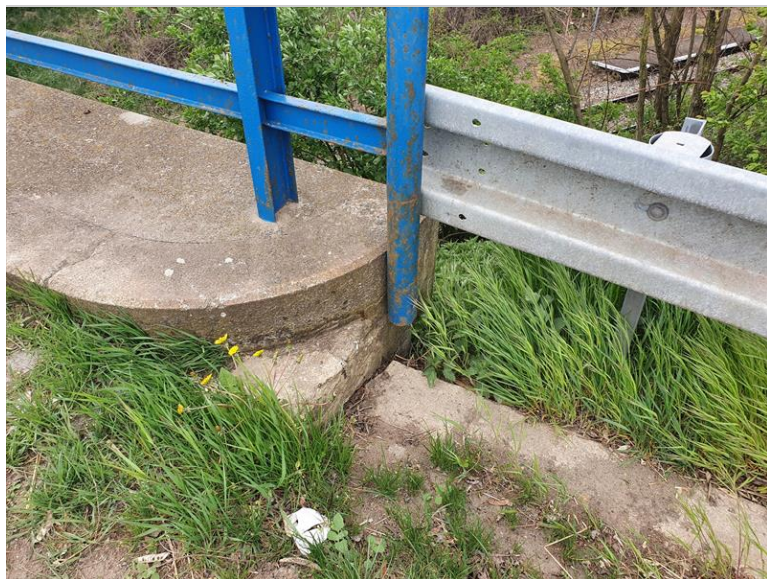
Přechod svodidla a zábradlí na mostě
