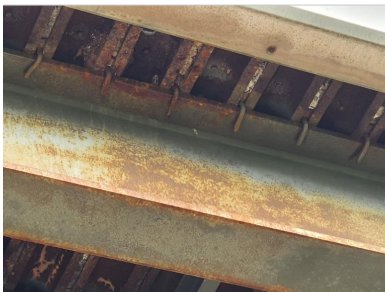
Koroze nosniku NK i profilů mostovky
