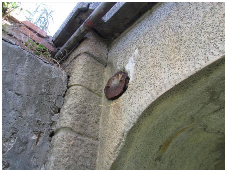
Koroze poklopu stálého zařízení
