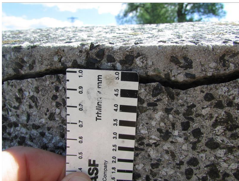
Trhliny v zábradlí
