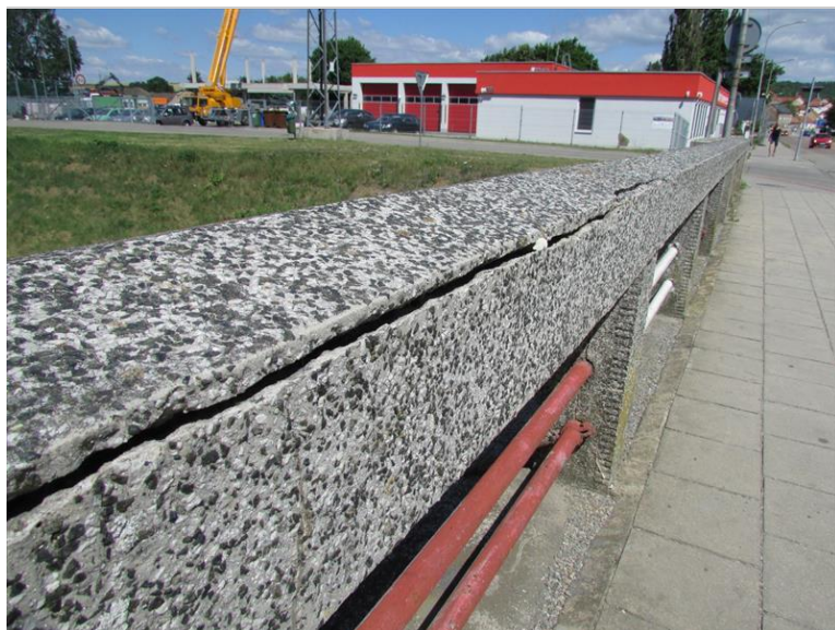
Trhliny v zábradlí
