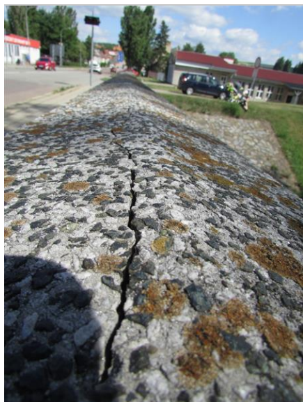
Trhliny v zábradlí
