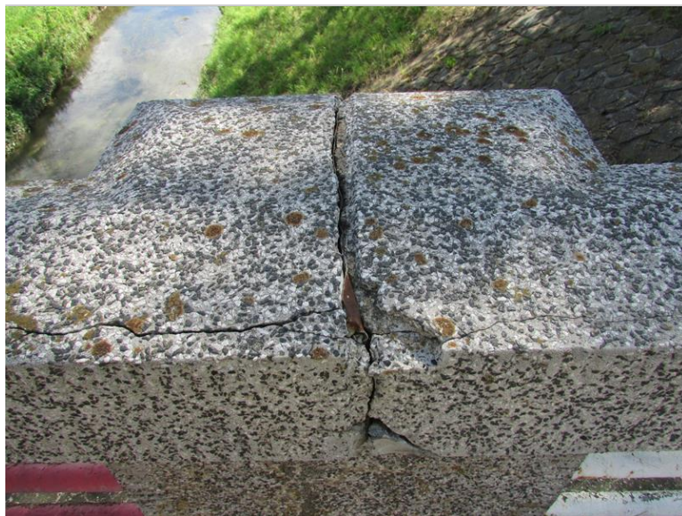
Trhliny v zábradlí
