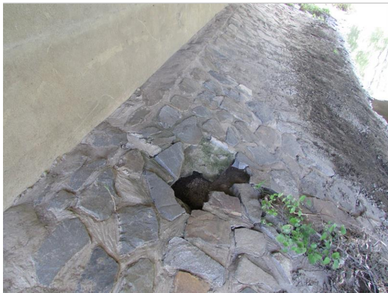
Rozpad v odláždění svahu pod mostem u OP2
