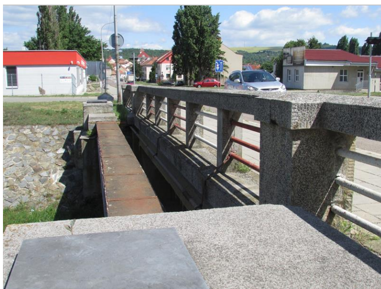
Samostatná konstrukce pro IS na levé straně mostu
