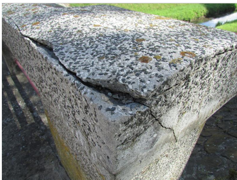
Trhliny v zábradlí
