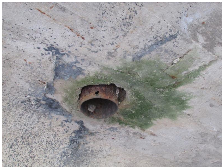
Koroze svislého svodu odvodnění
