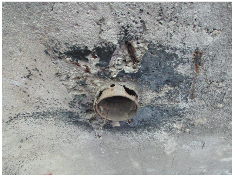
Degradace betonu na pohledu NK vlivem vlhkosti
