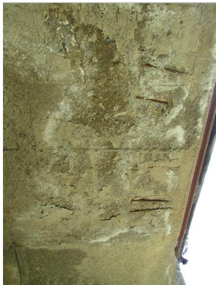
Degradace betonu na pohledu NK vlivem vlhkosti
