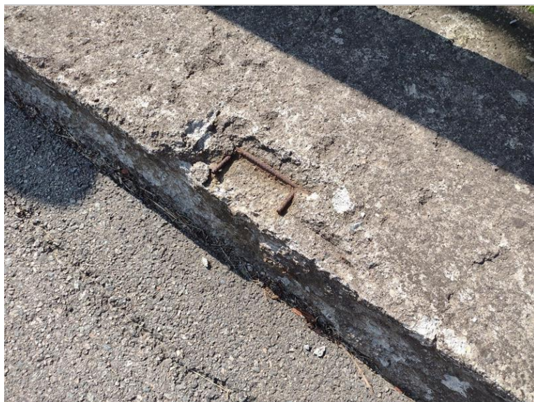
Pravá římsa a pozůstatek sloupku zábradlí
