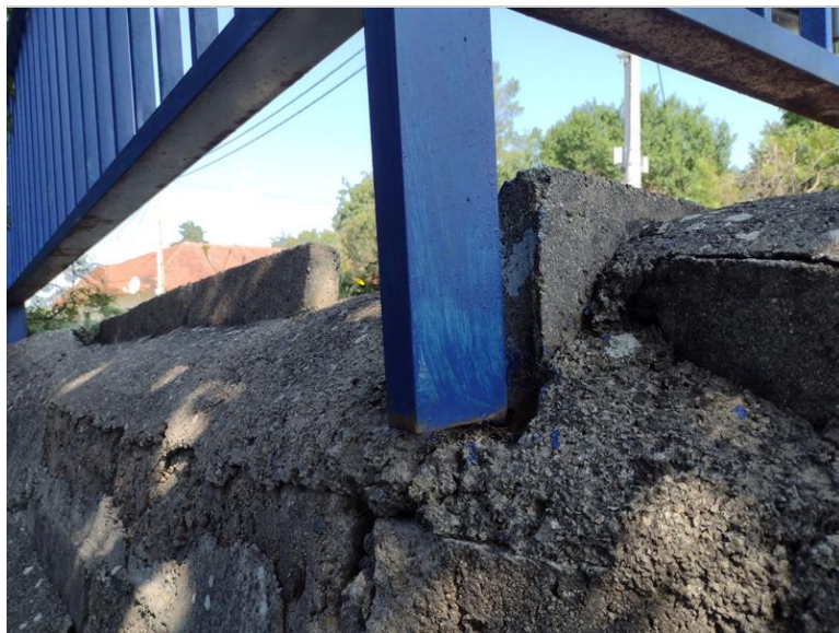
Volný sloupek zábradlí na pravé straně před mostem
