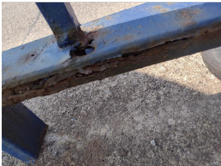
Koroze zábradlí
