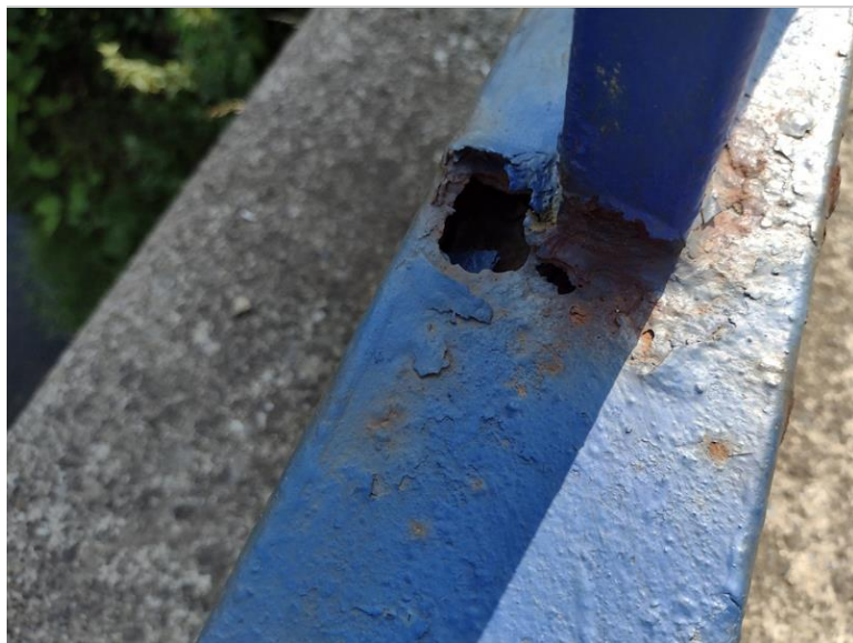
Koroze zábradlí
