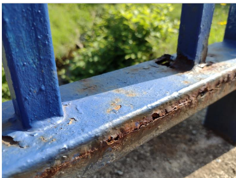
Koroze zábradlí
