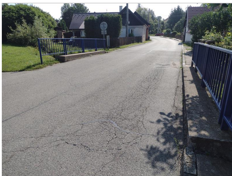
Vozovka na mostě - s trhlinami
