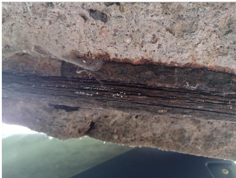
Odpadnutý beton krajního trámu - silná koroze zabetonovaného válcovaného profilu
