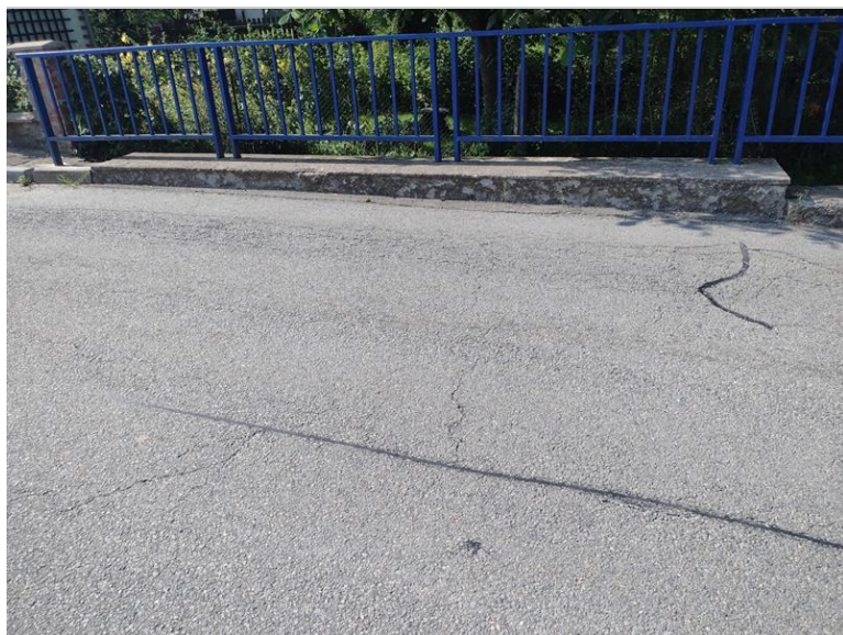
Trhliny ve vozovce
