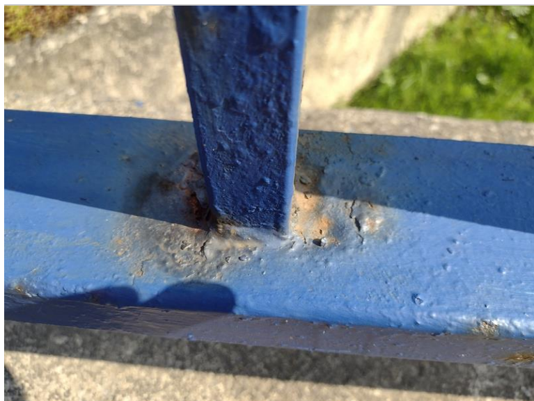
Koroze zábradlí
