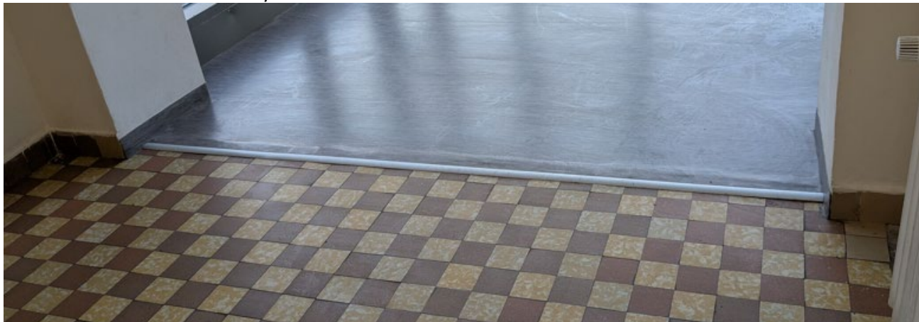
Návaznost místnosti C340 na výtahovou věž
