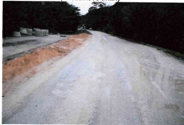
Hlubková koroze, vysprávký
