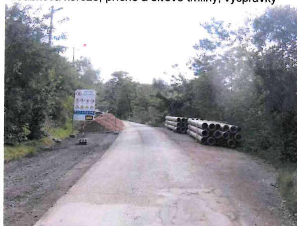
Hloubková koroze, mozaikové trhliny, vysprávky
