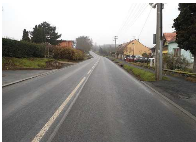
Stav po opravě
