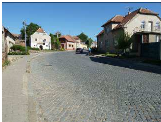
Stav před rekonstrukcí
