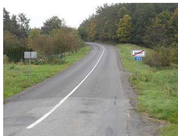
Stav po opravě
