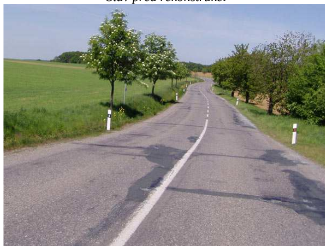
Stav před rekonstrukcí
