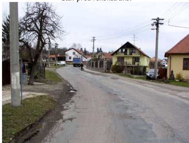
Stav před rekonstrukcí
