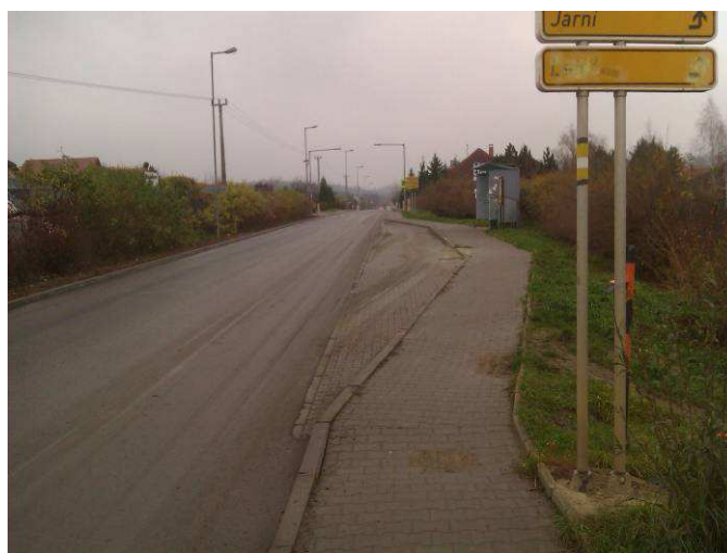
Stav po opravě
