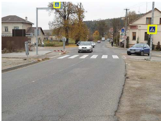
Stav před opravou
