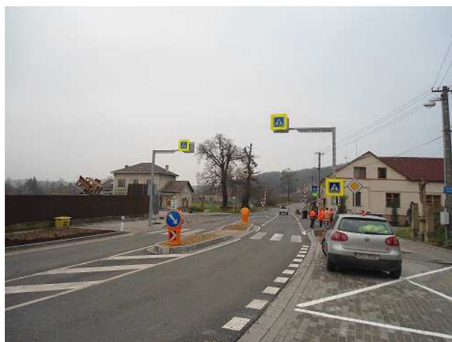
Stav po opravě
