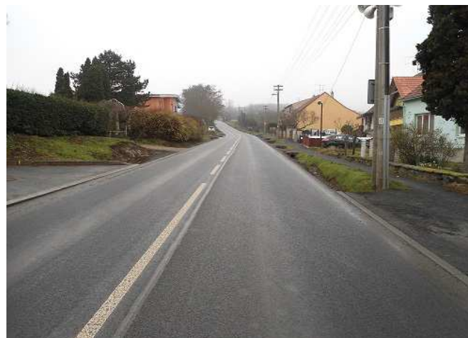
Stav po opravě
