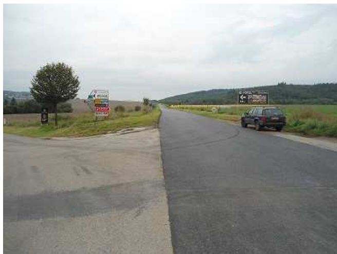
Stav po opravě
