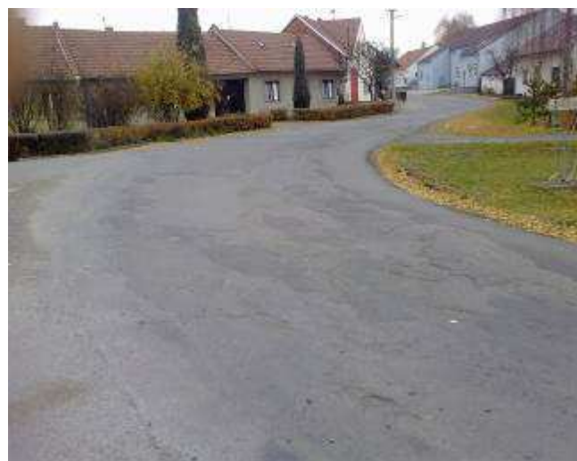
Stav před rekonstrukcí
