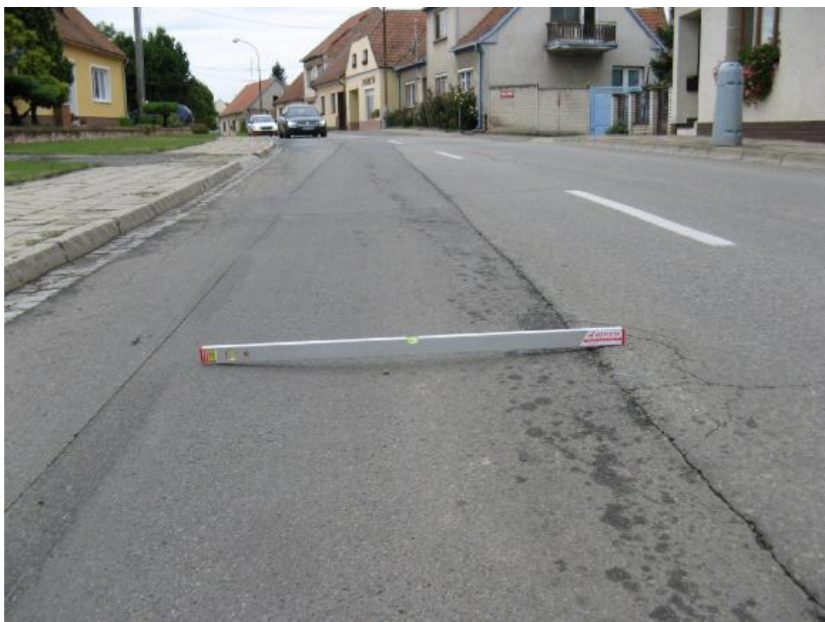
F10, km 0,240+ Zapravená rýha s deformacemi.
