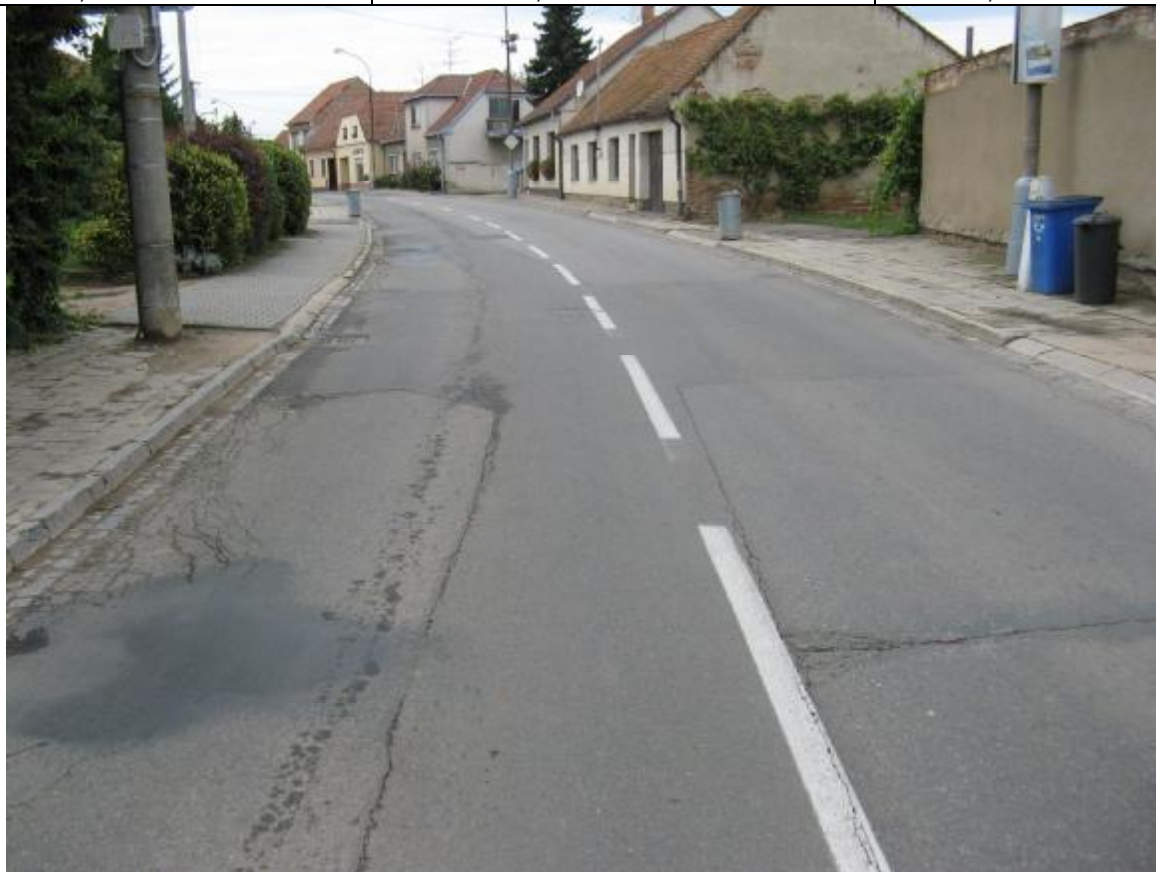
F09, km 0,210+ Zapravená rýha s deformacemi, vlevo síťové trhliny.
