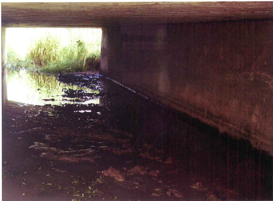
859-05 I. opěra. Pohled diagonálně po vodě a proti směru staničení, - opěry jsou masivní betonové monolitické omítané cem. omítkou.
