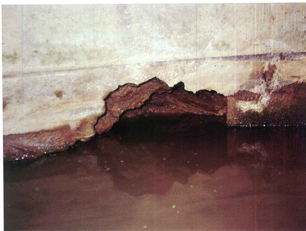
859-08 I. opěra. Pohled diagonálně proti směru staničení, - porucha na úrovni hladiny vody místního potoka, - vpravo ukončení levého monolitického dílu I.opěry.
