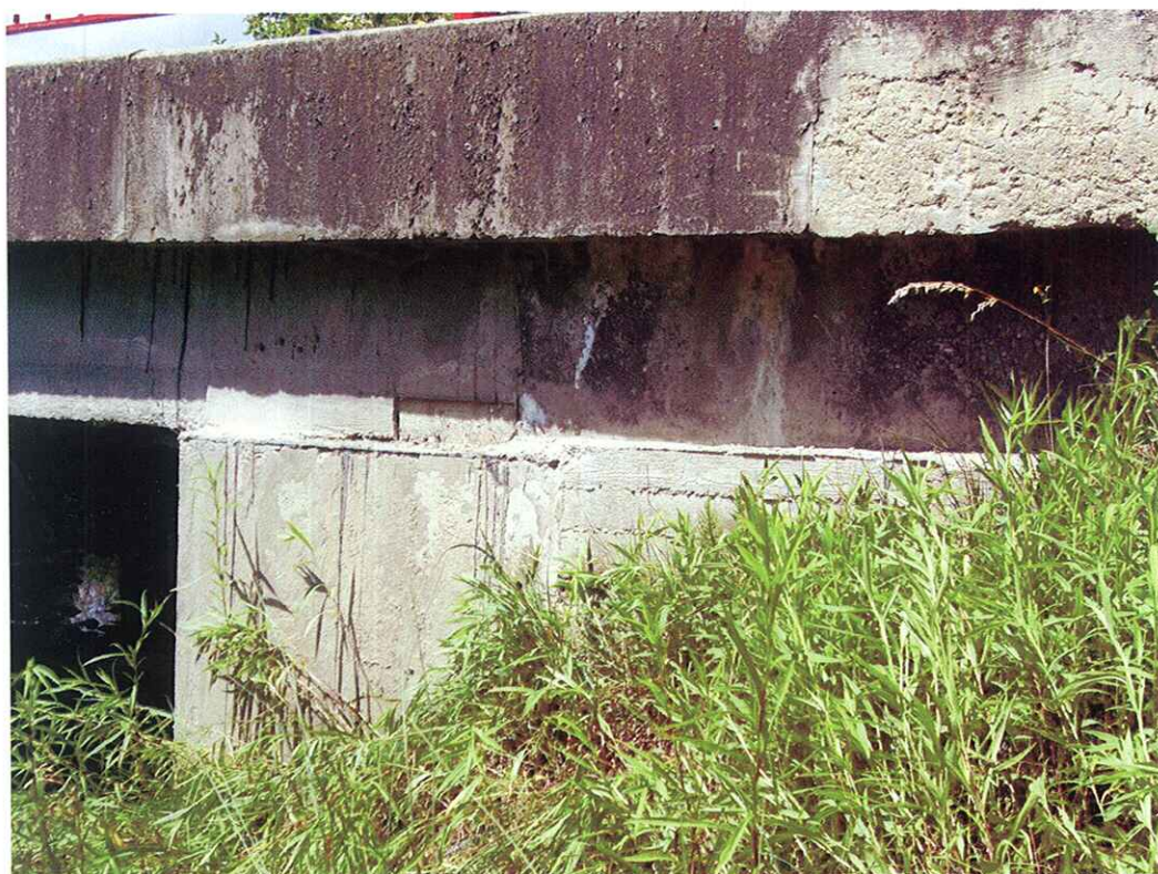
859-12 Pravé křídlo II. opěry. Pohled diagonálně proti směru staničení a proti vodě, - křídlo je krátké, rovnoběžné, neomítané, - dno koryta je pokryto naplavenou hlinou a zarostlé hustou vegetací, - inkrustace pod segmenty spárami mezi římsovkami a v okolí nepřiznané dilatační spáry mezi NK a závěrnou zdí.
