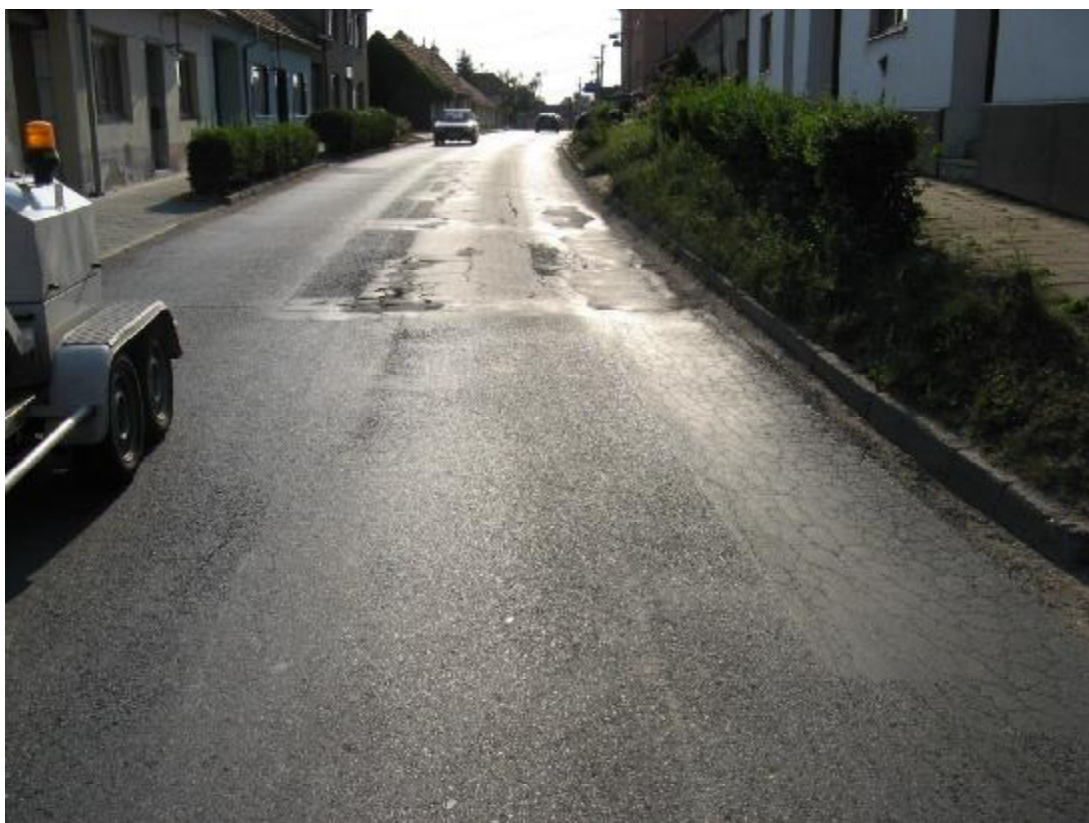
F28, km 24,000- Mozaikové trhliny, podél levého okraje jsou síťové trhliny a vysprávkky.
