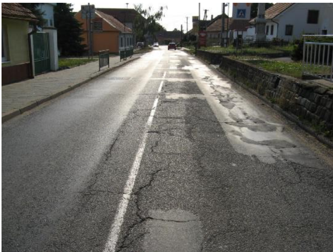
F25, km 23,900- Mozaikové trhliny, podél levého okraje jsou síťové trhliny a vysprávkky.
