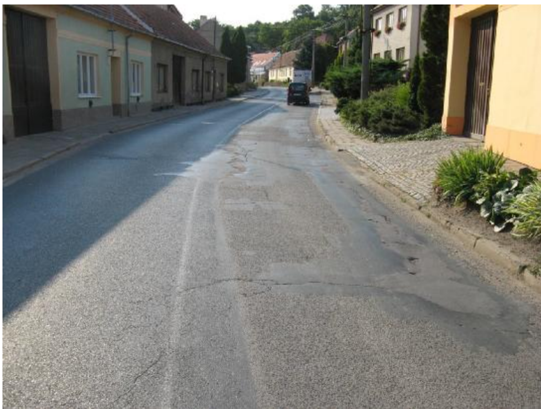
F33, km 24,300- Nepravidelné rozvětvené trhliny, podél levého okraje jsou síťové trhliny a vysprávký.
