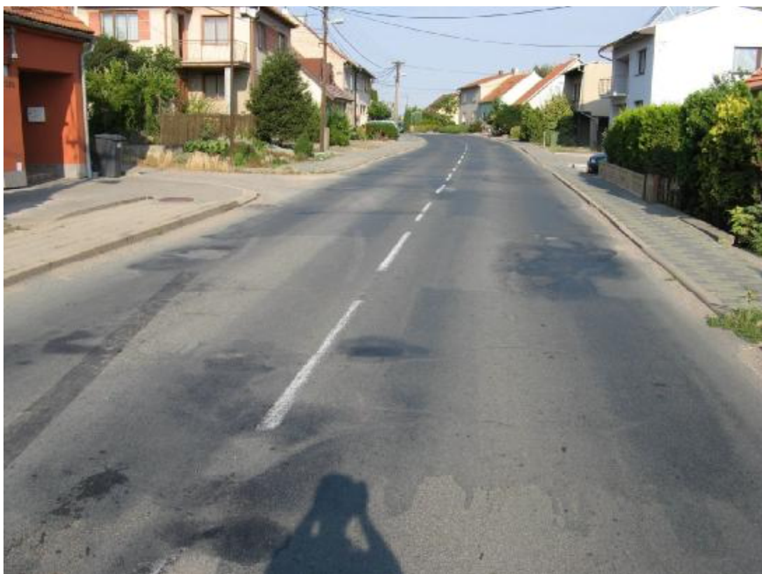
F39, km 24,610+ Nepravidelné a příčné rozvětvené trhliny.
