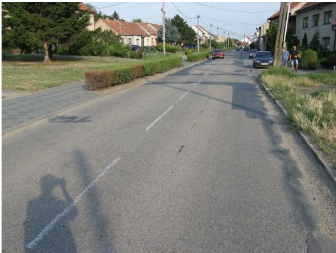
F06, km 22,910+ Příčné trhliny, vysprávký podél okrajů vozovky.
