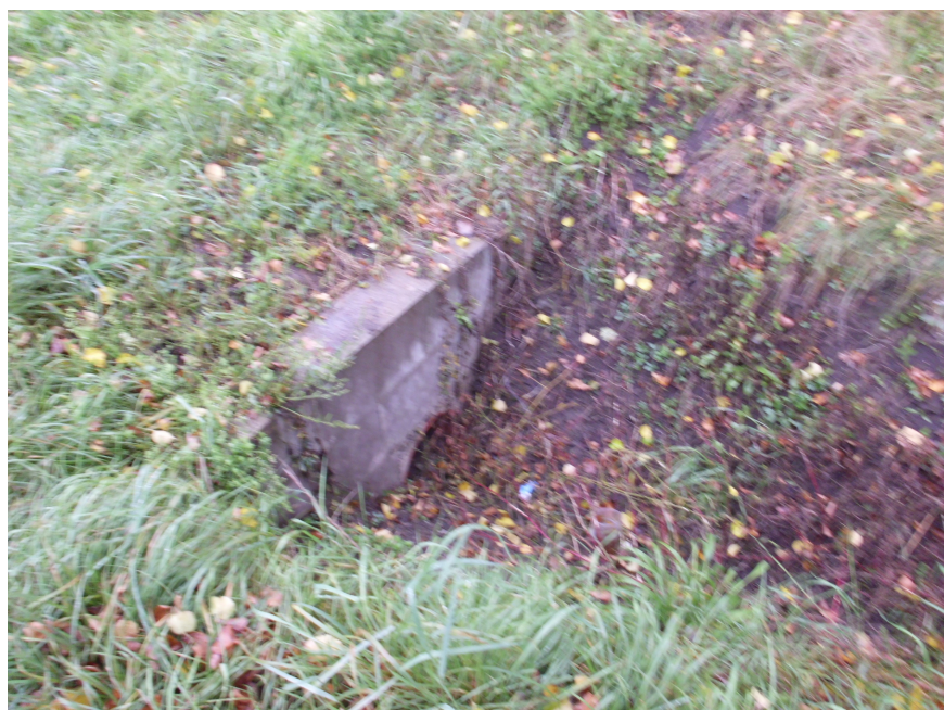
Foto č.22 - Pohled na zanesený vtok propustku vlevo ve směru staničení, směrem k Vážanům (km 0,88500).
