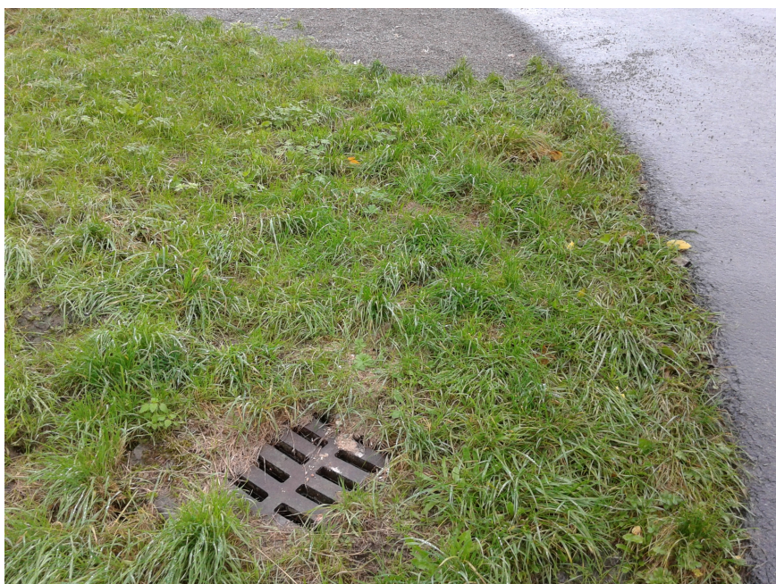
Foto č.32 - Pohled na výtok propustku pod silnicí II/374 v podobě kanalizační šachty vpravo ve směru staničení, směrem k Vážanům.
