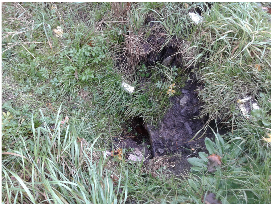
Foto č.29 - Pohled na zanesený vtok propustku pod silnicí II/374 vlevo ve směru staničení, směrem k Vážanům (km 1,94000).
