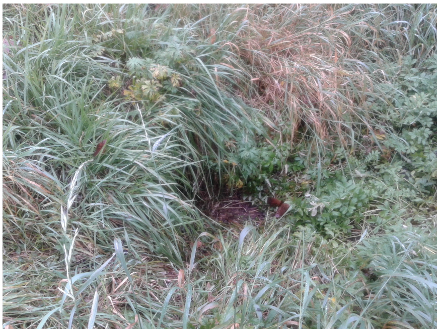
Foto č.31 - Pohled na zanesený vtok propustku pod silnicí II/374 vpravo ve směru staničení, směrem k Vážanům (km 1,94000).
