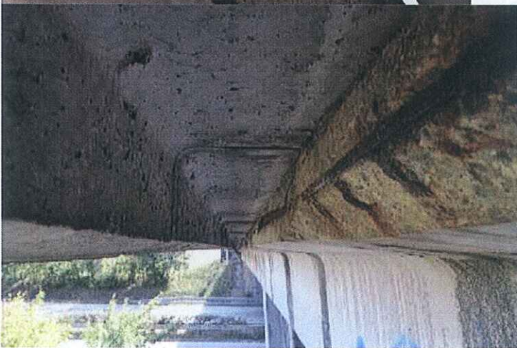
Detail NK a římsy na levé straně pole 1.
