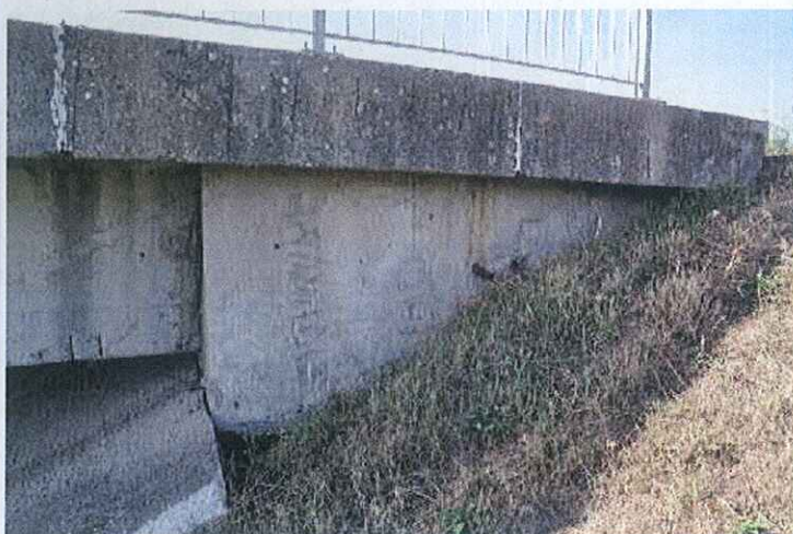
Pohled na pravé křídlo OP4.
