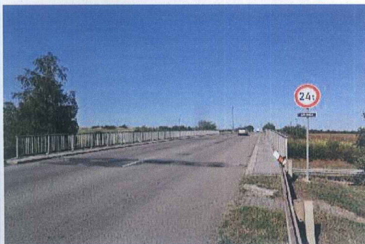
Pohled proti směru staničení.
