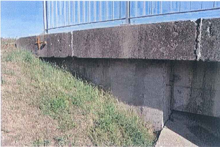
Pohled na pravé křídlo OP1.
