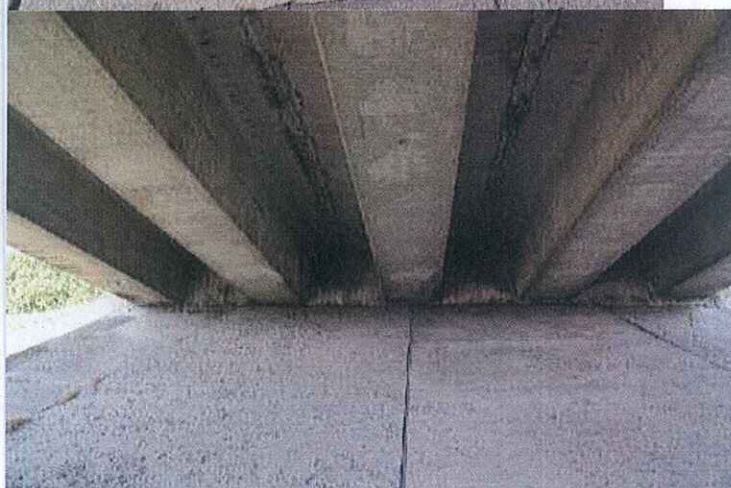
Pohled na OP1.
