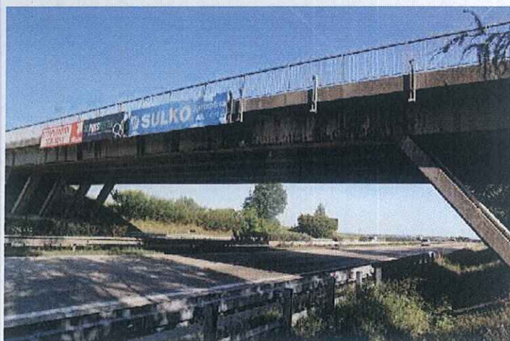
Pohled na pravou stranu mostu.
