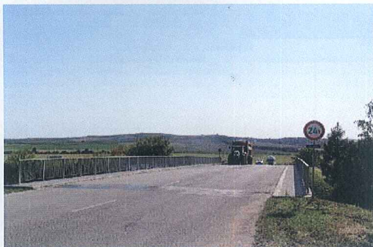
Pohled ve směru staničení.
