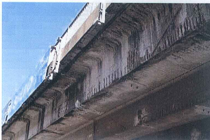
Pohled na pravý nosník NK pole 2.
