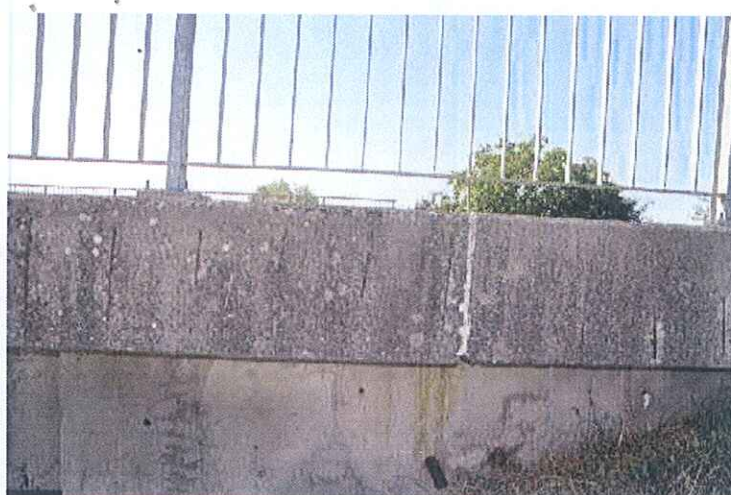
Pohled na pravou řimsu.
