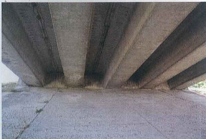
Pohled na OP4.
