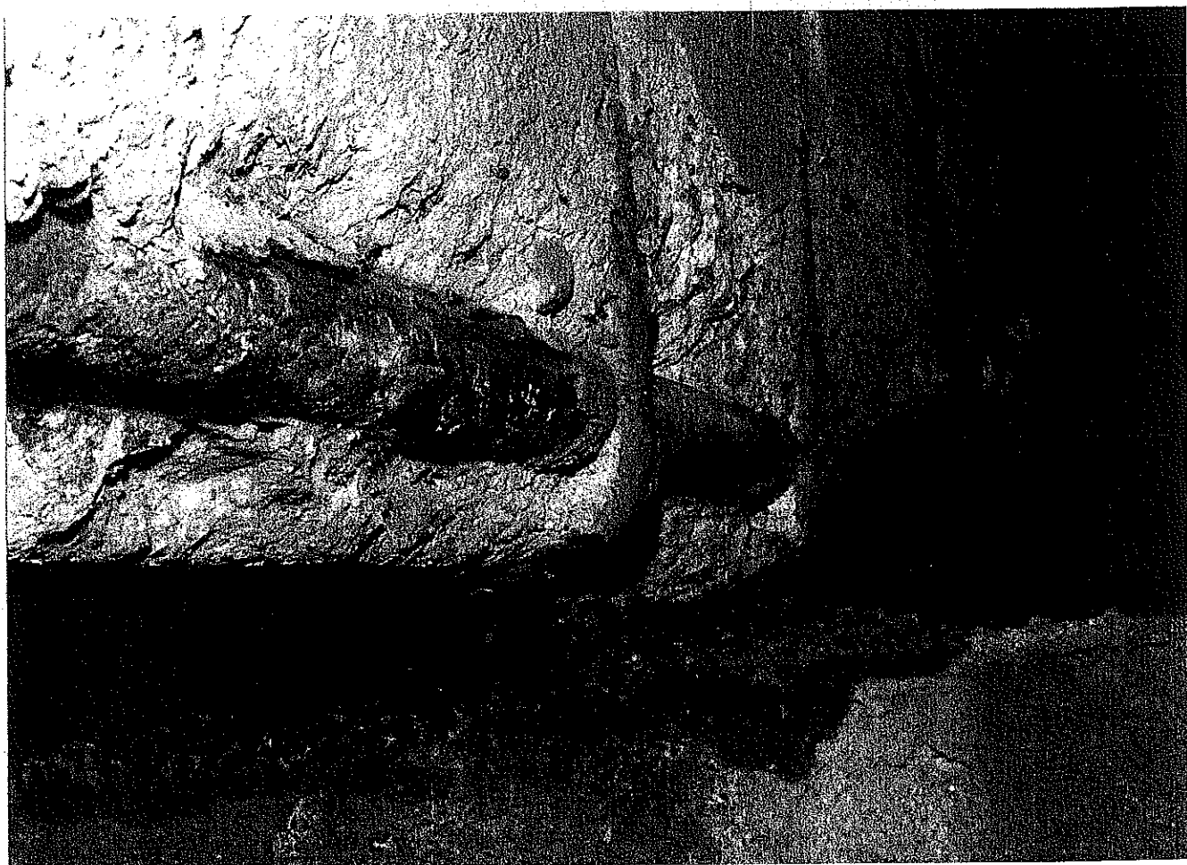
Obr. 238-8 Uložení 1. trámu (brněnského fasádního) na černovické opěře. Pohled z lešení,
