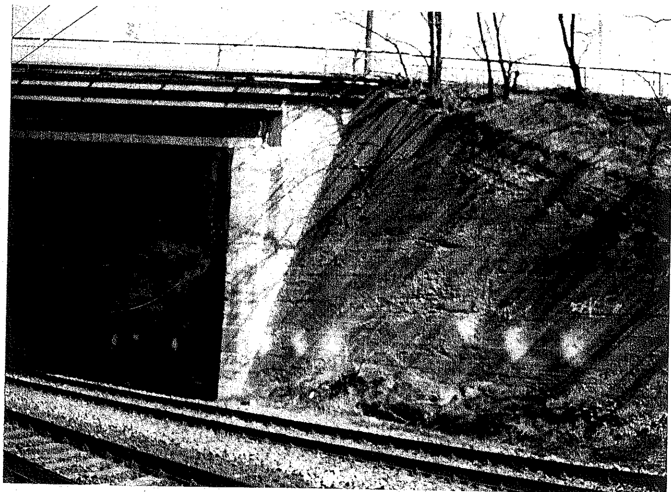
Obr. 238-16 Trenčanský konec slatinské opěry (ve stínu) a přiléhající svahové křídlo. Pohled od jihozápadu,
