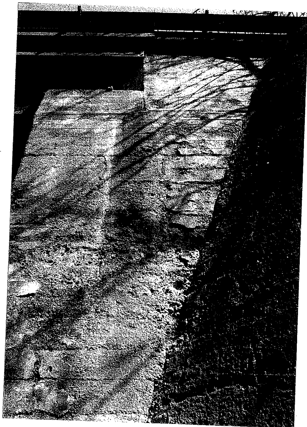
Obr. 238-17 Trenčanský konec slatinské opěry a přiléhající svahové křídlo. Detail koutu. Pohled od jihu,
