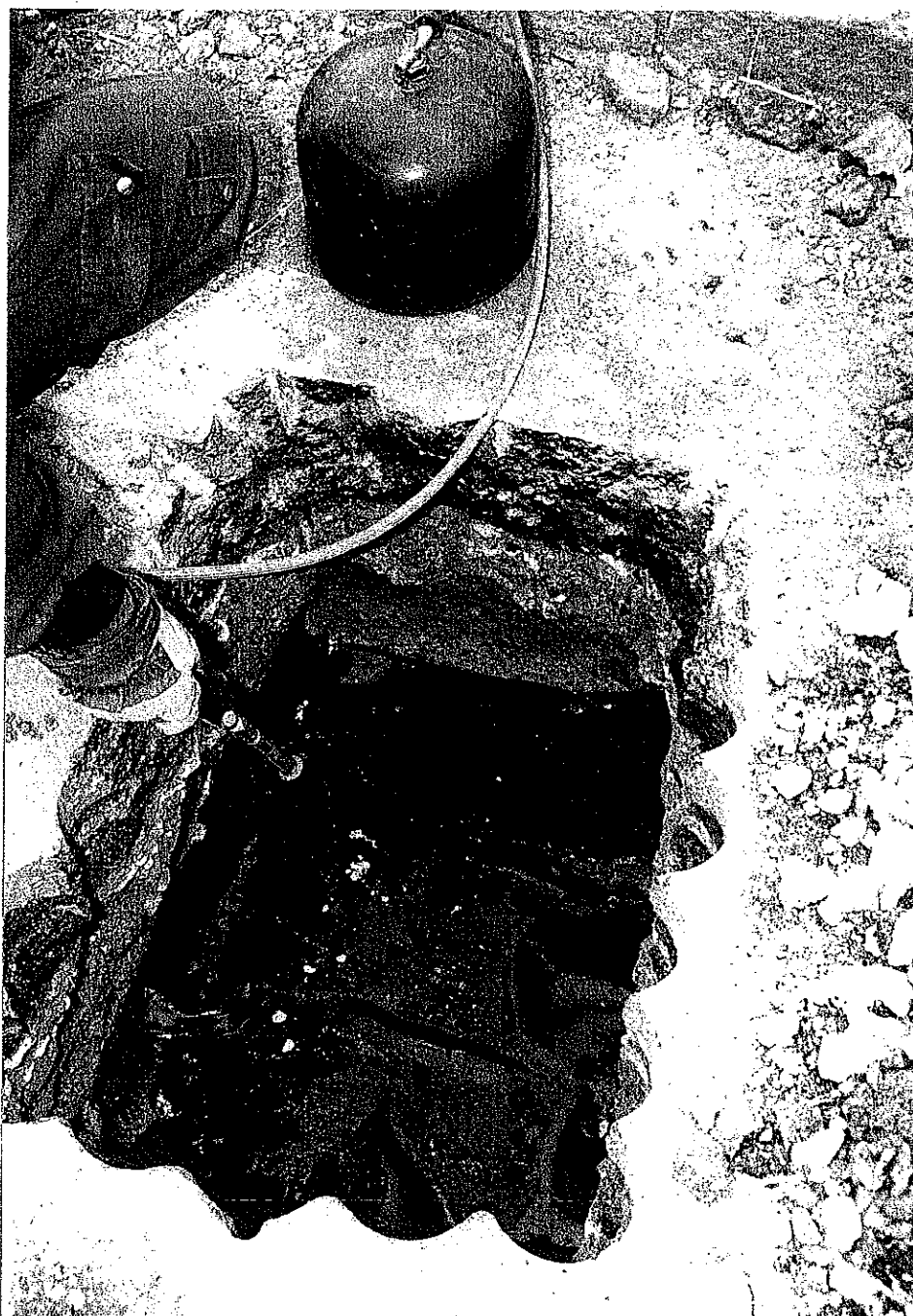
Obr. 238-1 Sonda ve vozovce nad 7. trámem provedená pro gamagrafii rozměru 500 x 800 mm. Pohled od trenčanské strany k brněnské,
