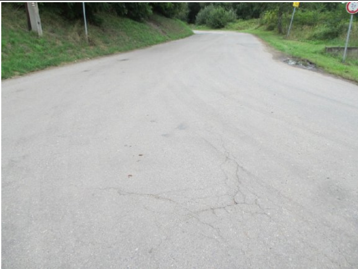
F02, km 0,010+ Mozaikové, rozvětvené až síťové trhliny
