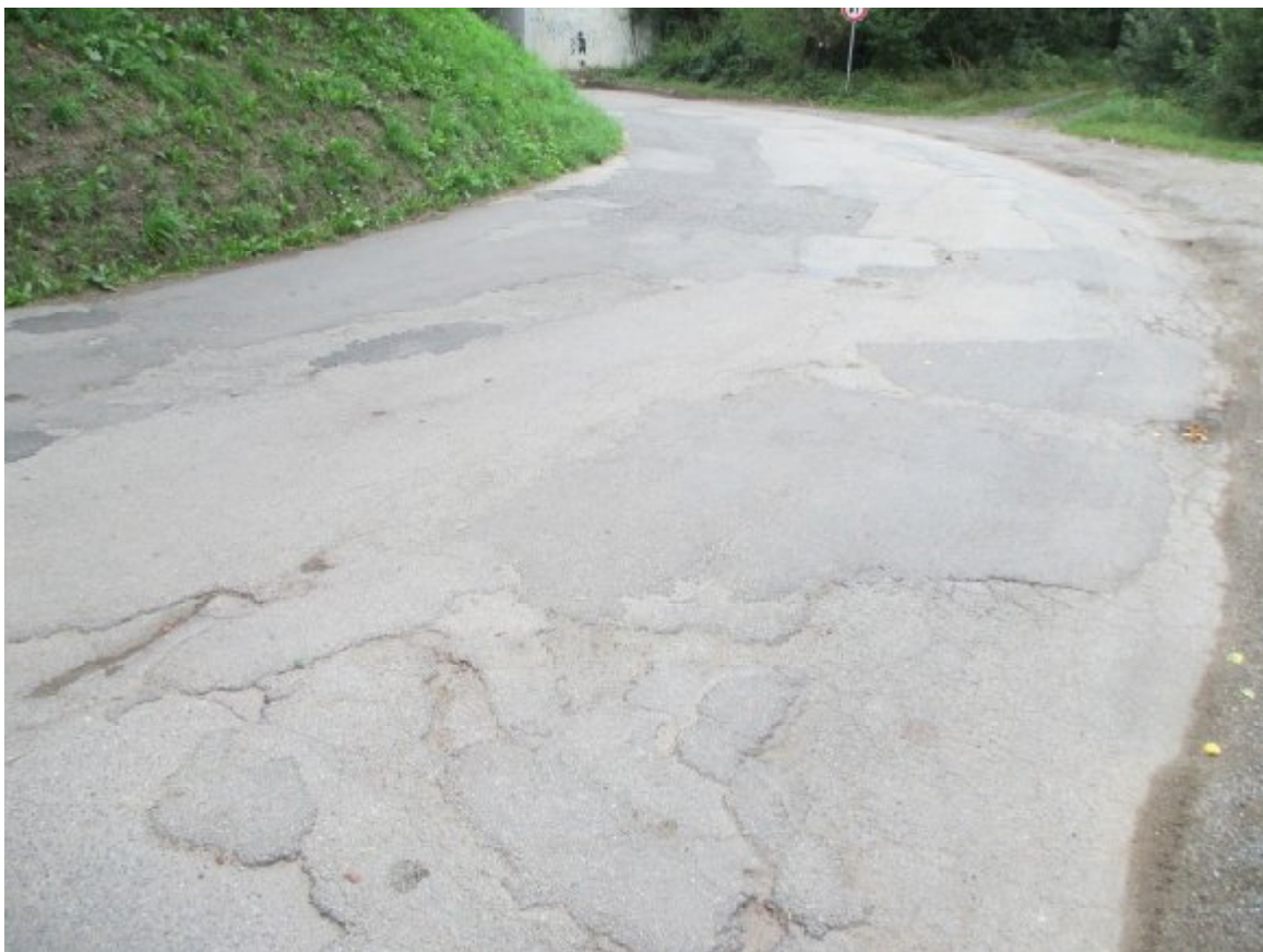
F03, km 0,050+ Síťové trhliny, plošné deformace, vysprávkky, nepravidelné hrboly
