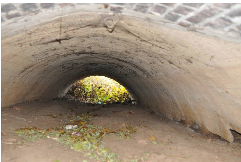
Obr.8 most 42510-4; cihelná klenba a splaveniny v mostním otvoru
