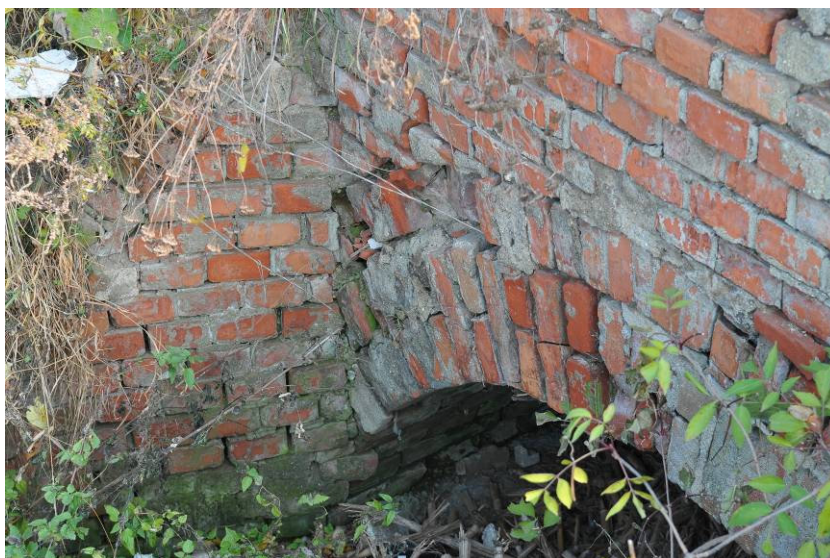
Obr.3 pravý pohled na most 42510-3 (napojení čelní zdi a opěrné zídky)
