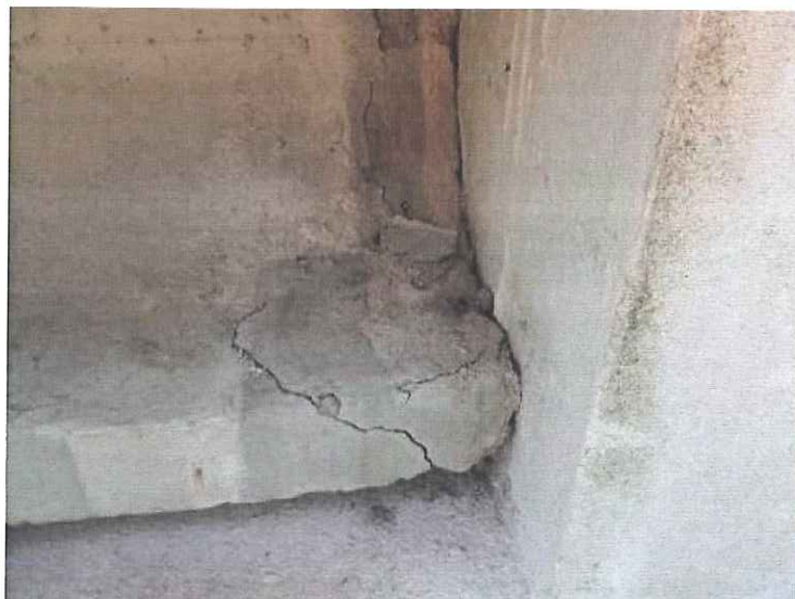
Popraskané dobetonování nosníků.
