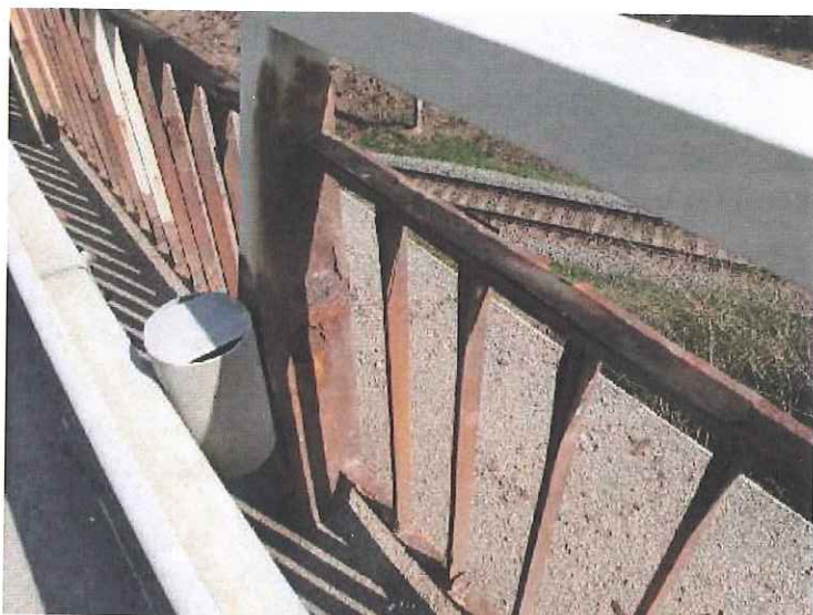
Koroze zábradlí, až šupinově. Lokálně úbytek materiálu 100 %.
