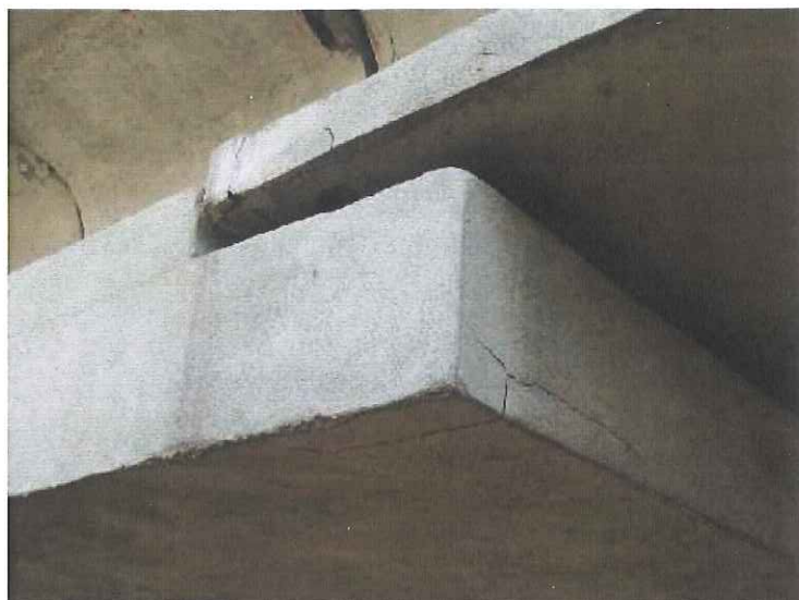
Pohled na kraj úložného prahu P3 - drobné trhlinky.
