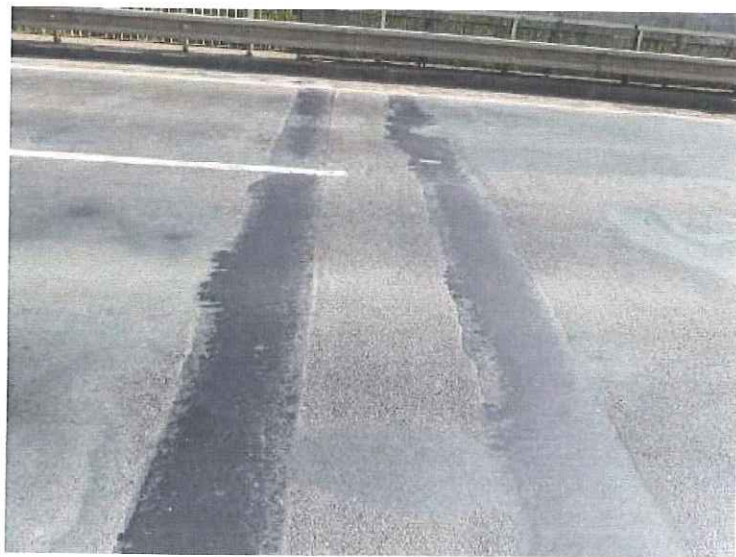
Vyježděné mostní závěry a nerovná vozovka.
