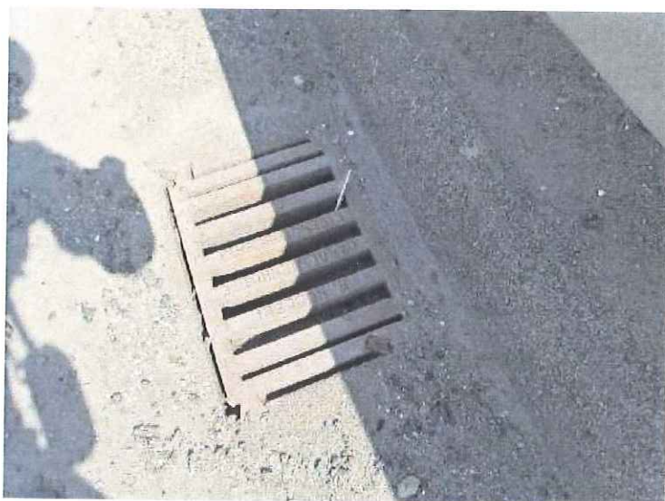
Mostní odvodňovač.
