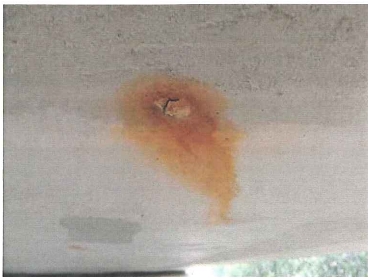
lokální zrezivělé skvrny na podhledu NK. Odražený beton.
