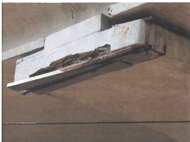
pohled na kraj úložného prahu na P2 vlevo, kaverna. Beton odpadává přímo do kolejiště. Zpevněno sponami.
