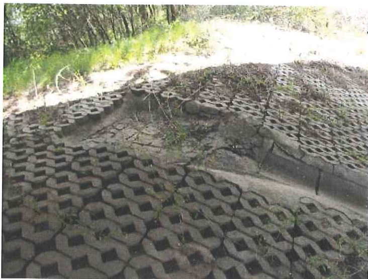
Rozbité vývařiště a skluz pod mostem.
