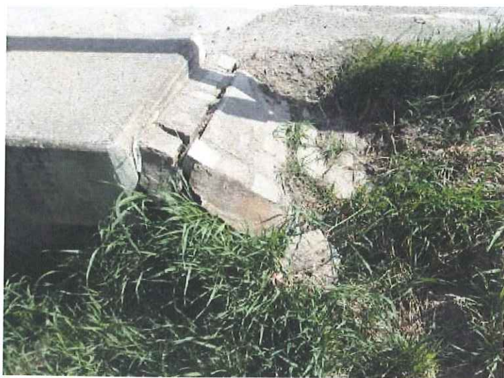
Rozpadlé rampovité ukončení římsy.
