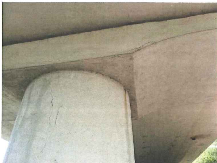
Trhlinky na P3 i v jeho úložném prahu
