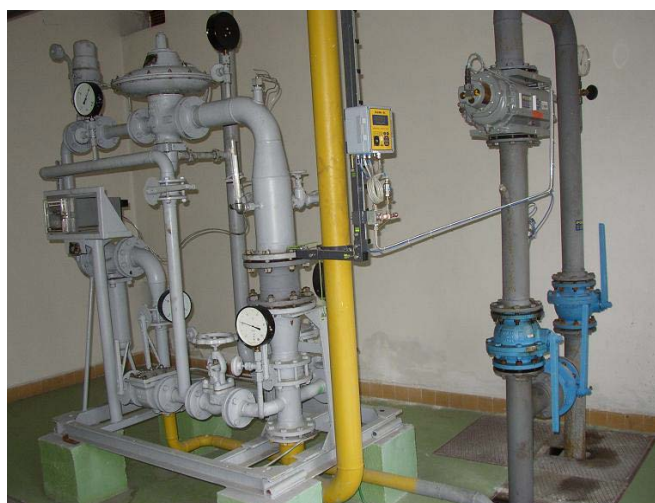
Obrázek č.19: Regulační zařízení RS 1200/2/1 s fakturačním plynoměrem
