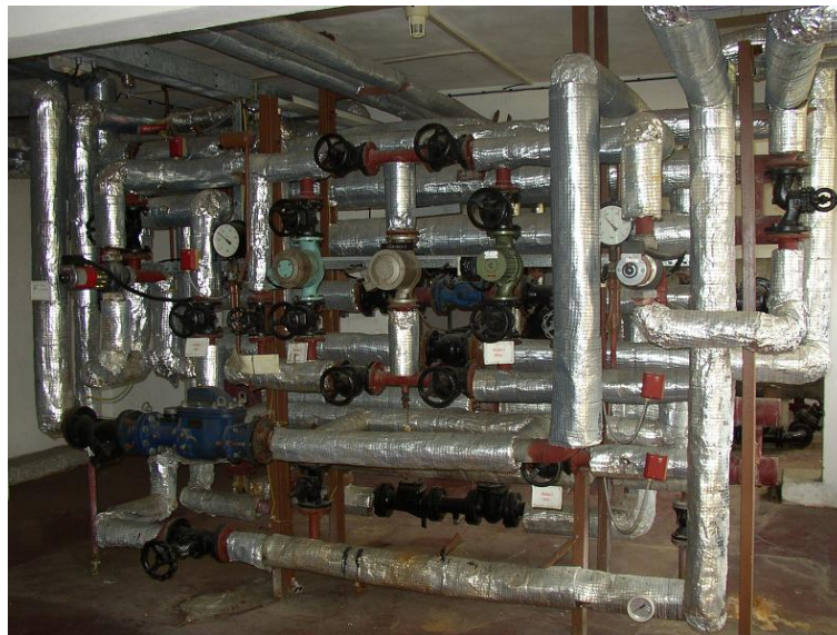
Obrázek č. 9: Trubkové ohřivače pro rychloohřev TV v objektu LO1
