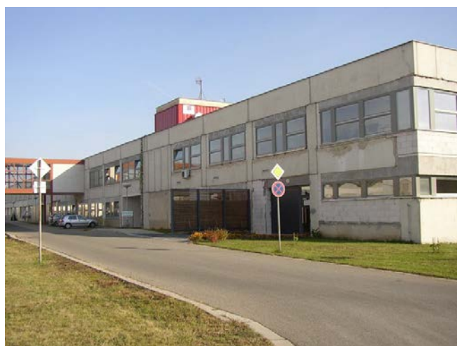
Obrázek č.28: Severní pohled na objekt Patologie
