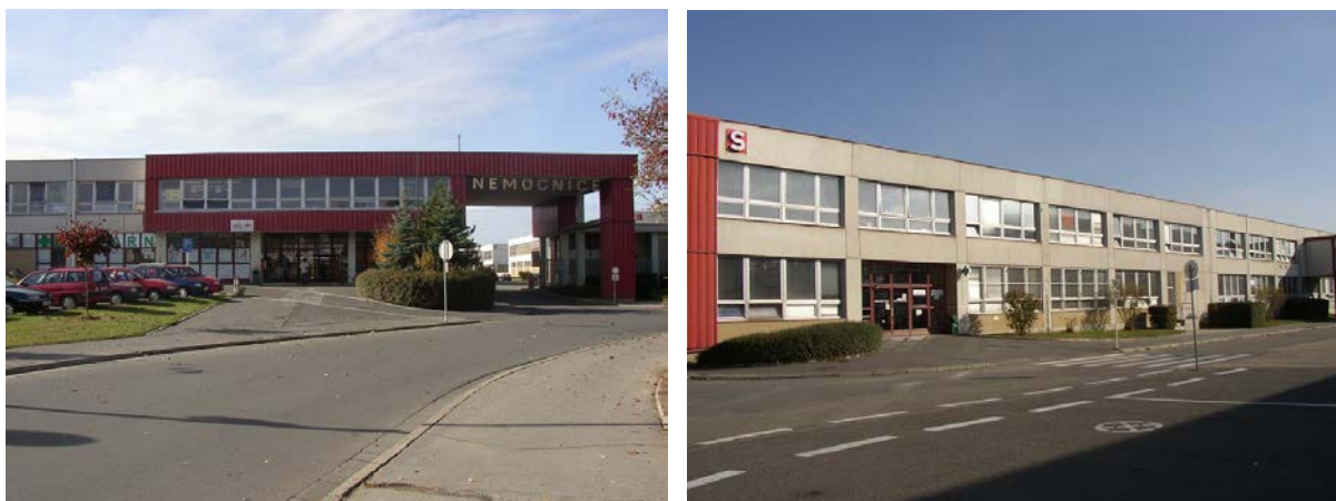
Obrázek č.22: Jihovýchodní a severozápadní pohled na Vstupní objekt
