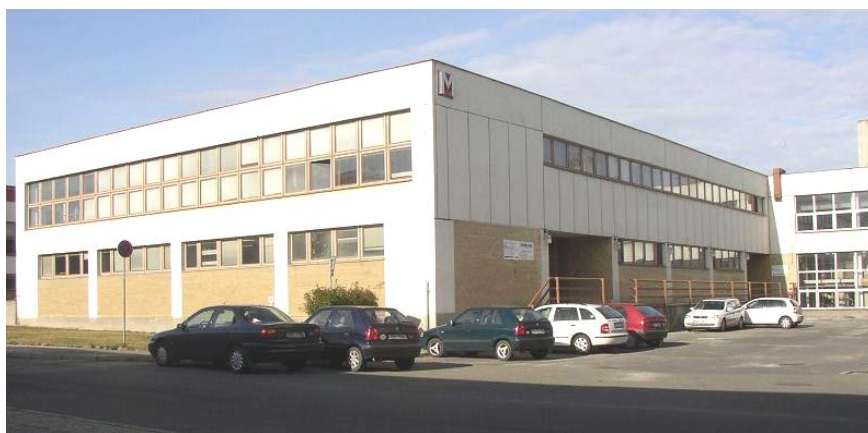
Obrázek č.31: Jihovýchodní pohled
