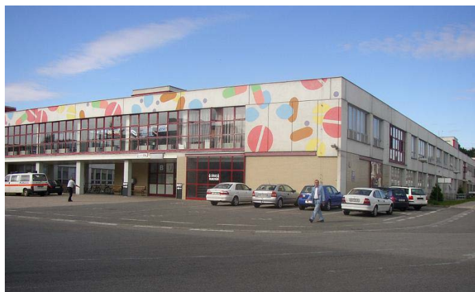
Obrázek č.25: Nárožní pohled na objekt Příjmu
