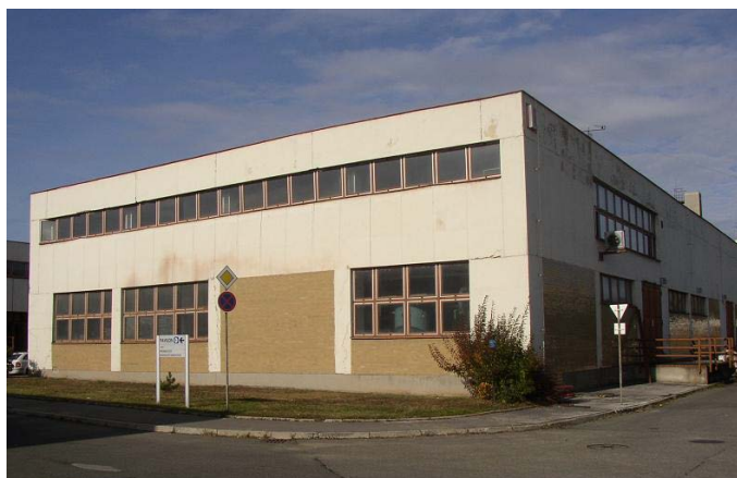
Obrázek č.32: Jihovýchodní pohled na objekt Kotelny
