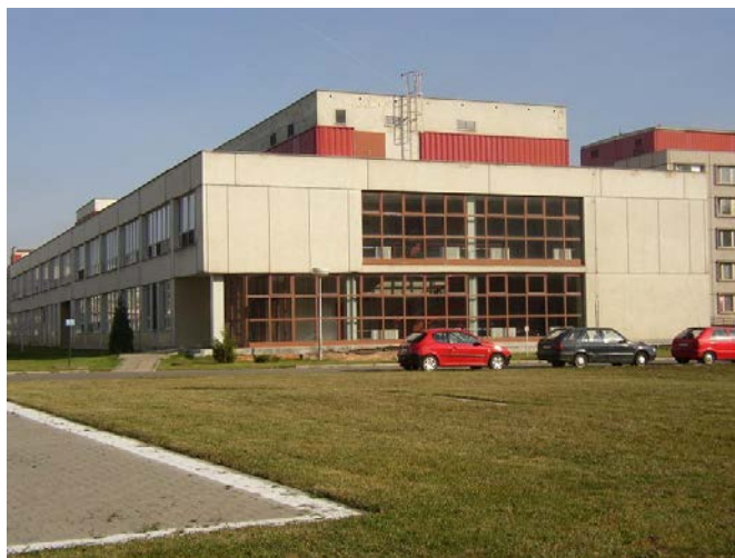
Obrázek č.27: Severozápadní pohled na objekt Operační sály
