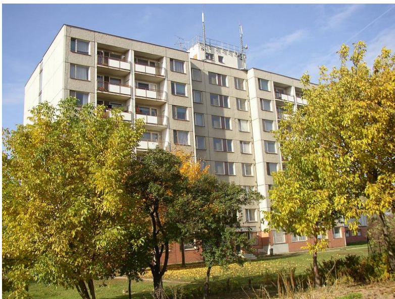
Obrázek č. 8: Východní pohled na budovu
