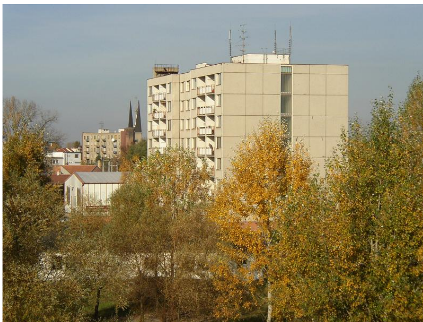
Obrázek č. 1: Jihozápadní pohled na ubytovnu
