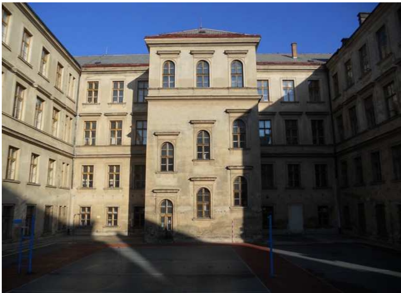
Výměna oken dvora SPŠ stavební Brno
