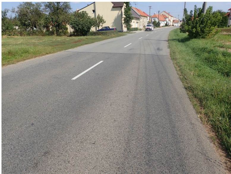
Začátek úseku (obec Svatobořice-Mistřín)
