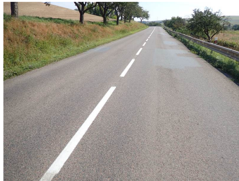
Vozovka v úseku Šardice – Hovorany
