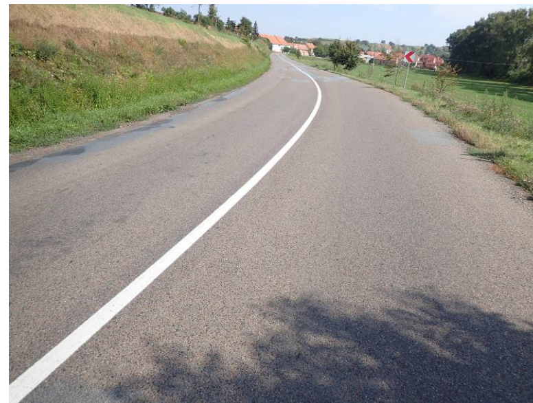
Vozovka v úseku Šardice – Hovorany
