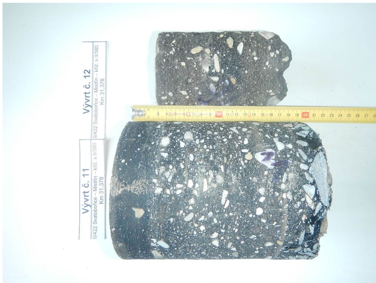
Foto č. 17 – Detail vývrtu č.11 a 12 (znázornění trvalé deformace -kolej)
