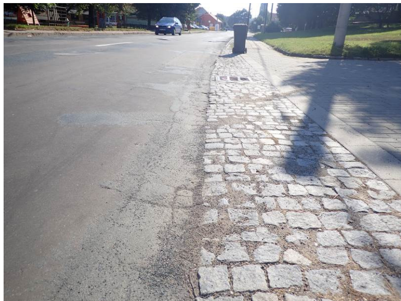
Odvodnění povrchu vozovky (obec Hovorany)
