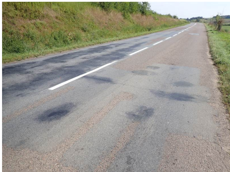
Vysprávký povrchu vozovky (úsek Šardice – Hovorany)
