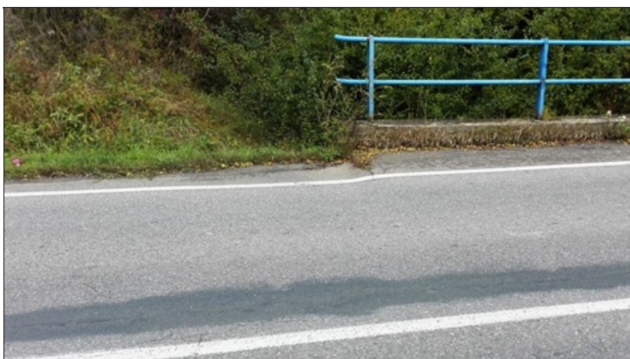
Prosedlá vozovka v předmostích, nánosy vegetace u říms.
