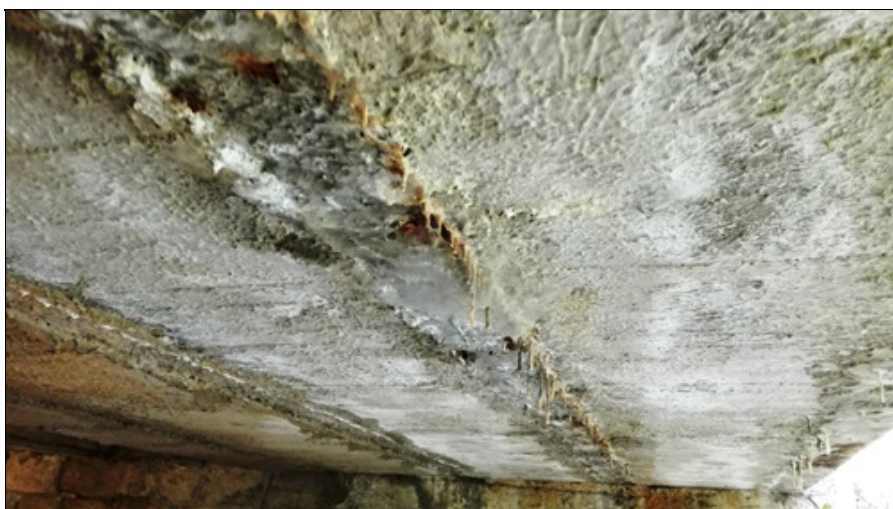
Průsaky na styku betonu s nosníky, vápenné krápníky.
