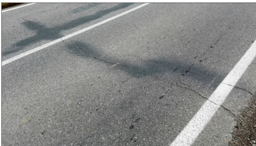
Příčné trhliny v živičném krytu vozovky v přechodových oblastech.
