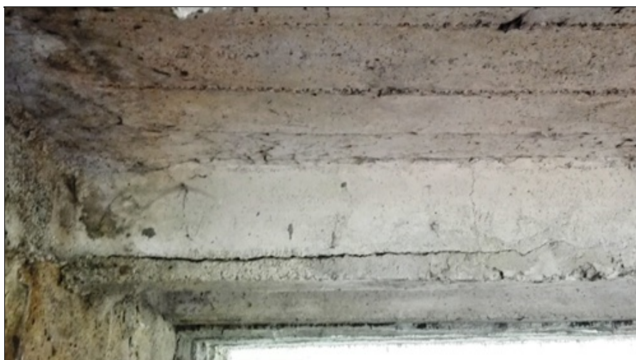
Podélná trhлина při spodní pásnici obetonovaného nosníku v trémové části nosné konstrukce.
