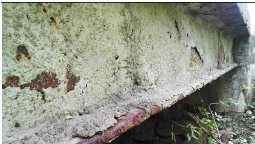
Ocelové nosníky ošetřené stříkaným beton, který se odlupuje.
