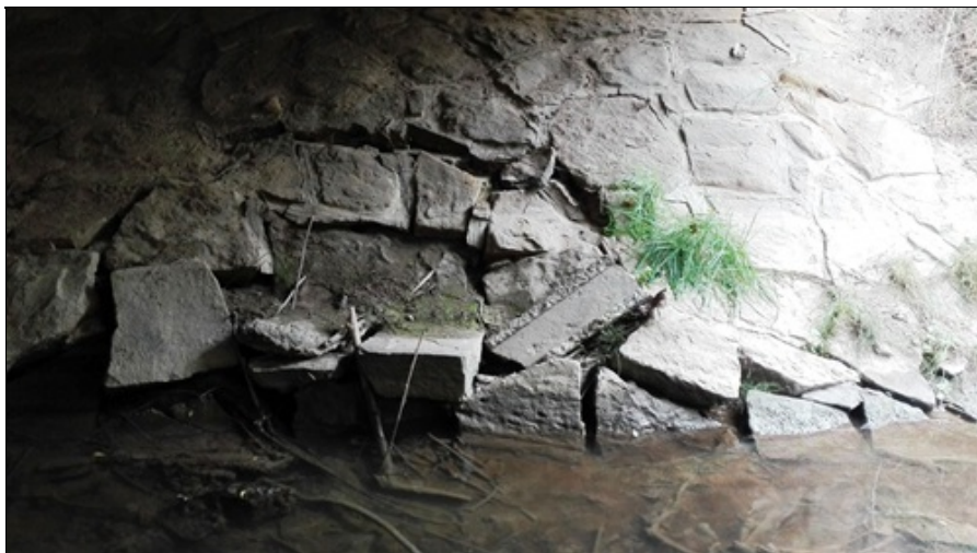
Rozpadlé zpevnění koryta vodního toku.
