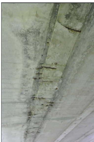
Krajní spára mezi nosníky vlevo v 1.poli
