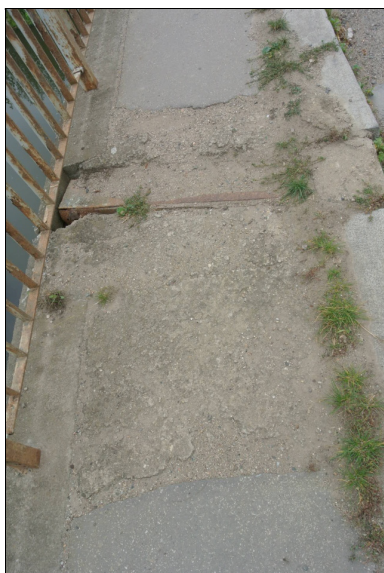
Betonový blok u povrchového ocelového závěru u podpěry 2
