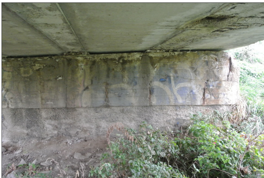
OP2 - dlouhodobé zatékání na úložný práh
