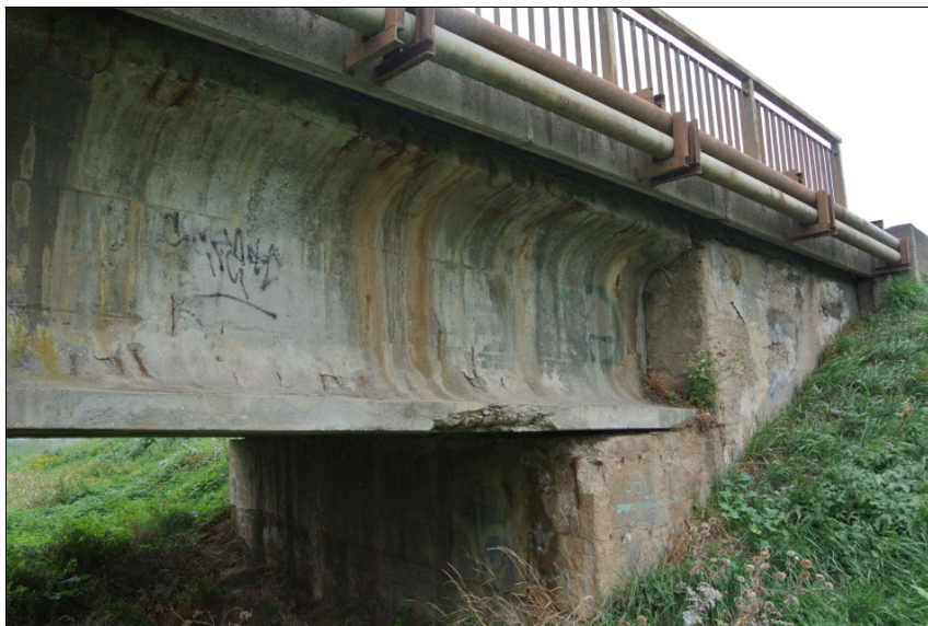
Degradace betonu krajního nosníku a úložného prahu OP 2 vpravo
