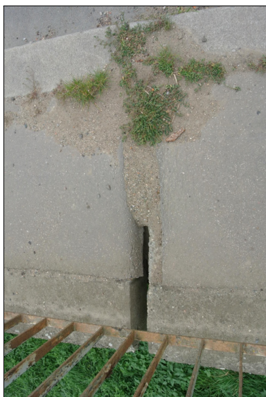
Chybějící kryt dilatace vlevo nad OP1
