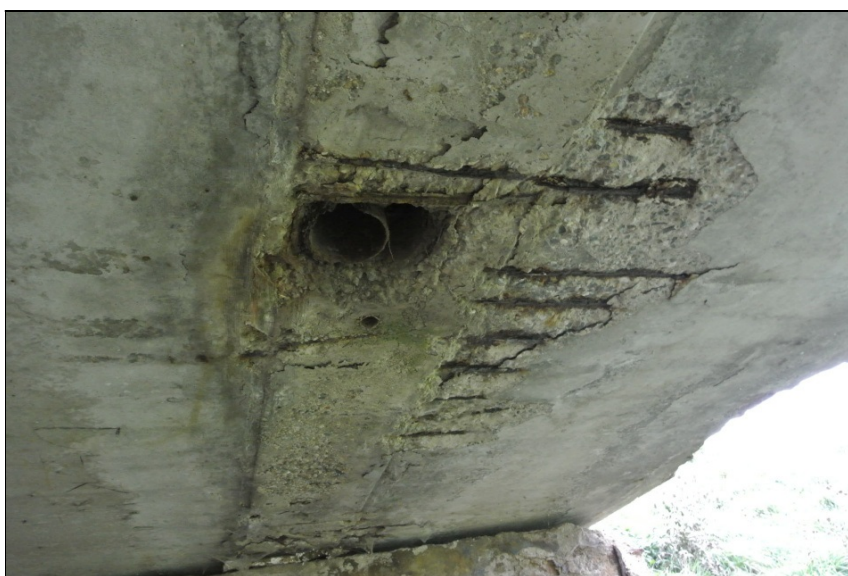
Odvodňovač ve spáře ve 3.poli u OP2 vpravo
