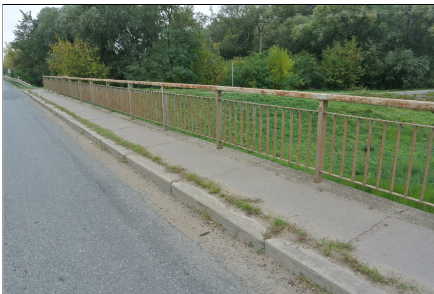
Koroze zábradlí, uchycená tráva v krajnici a spáře mezi LA a obrubou
