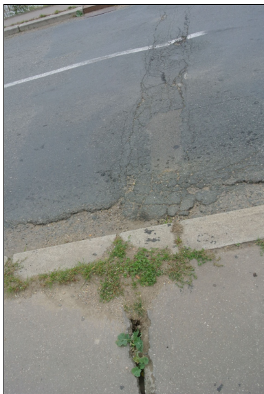
Popraskaná a nerovná vozovka v oblasti dilatace nad OP2, chybí kryt v chodníku
