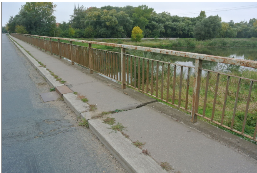
Koroze zábradlí, tráva ve sparách, chybějící kryt dilatace v chodníku vlevo nad 3.polem u OP2
