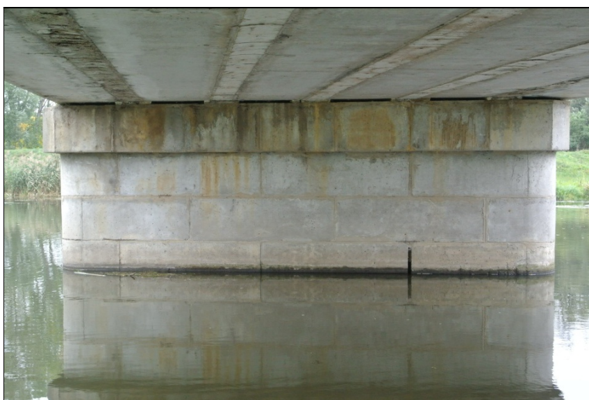
Průsaky s výluhy na úložný práh podpěry 3
