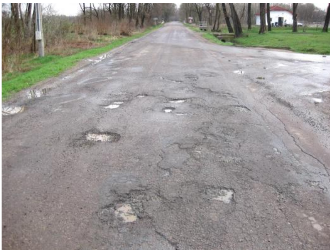
F01: km 1,880–; výtluky v krytu a deformace
