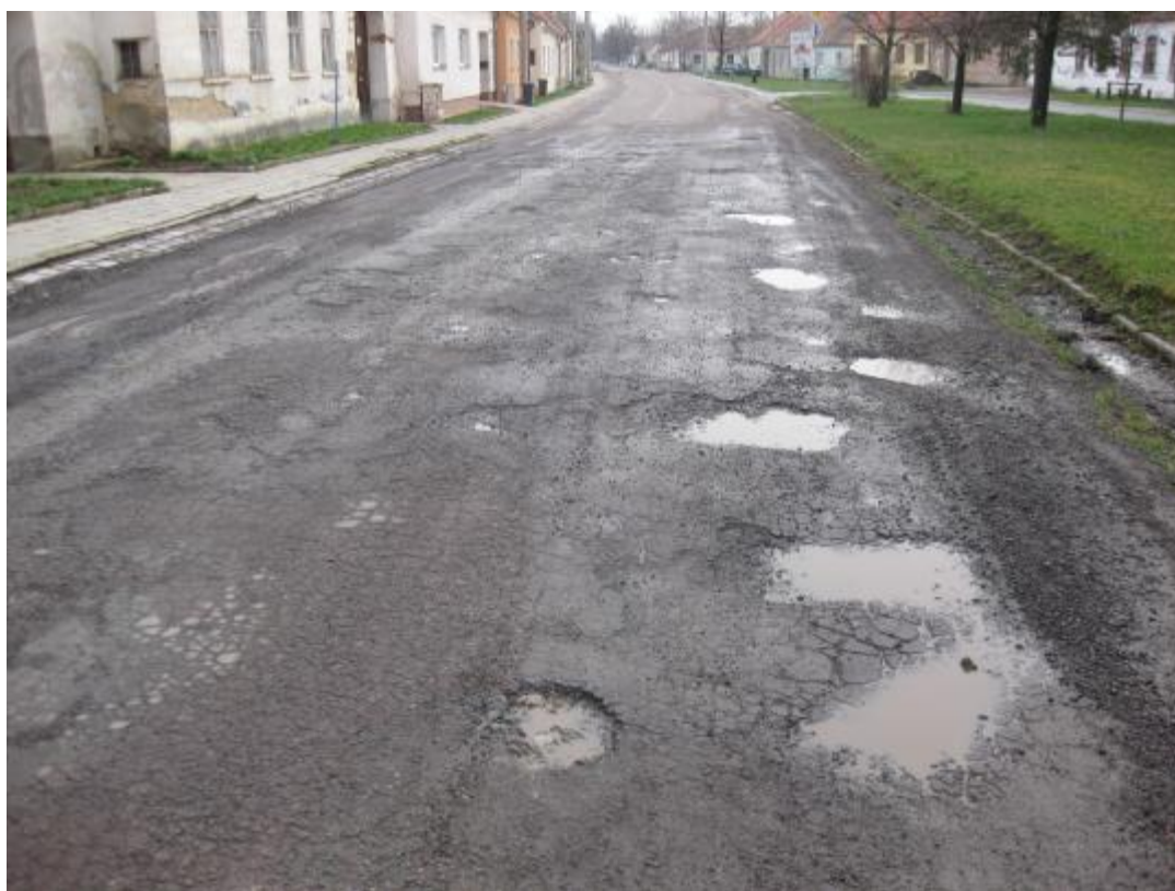
F04: km 2,325– ; trhliny, výtluky, deformace, rozpad krytu
