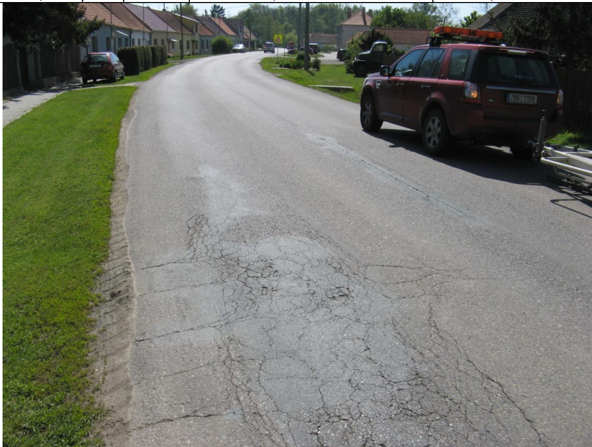
F11, km 0,250+ Síťové trhliny, podélná trhlina uprostřed.
