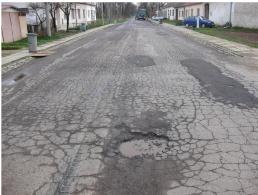
F02: km 2,000– ; celoplošné sít'ové trhliny, výtluky, vysprávkky
