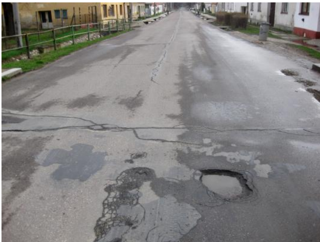
F03: km 2,150– ; trhliny, výtluk
