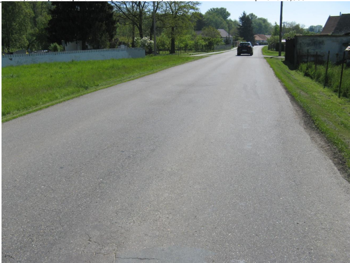
F03, km 0,060+ Vyjeté koleje, plošné deformace uprostřed vozovky.
