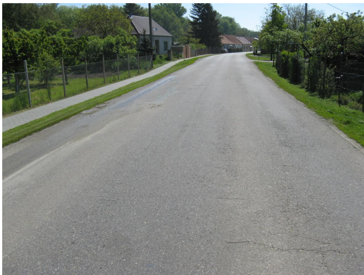
F07, km 0,160+ Mozaikové trhliny a ztráta asfaltového tmelu.
