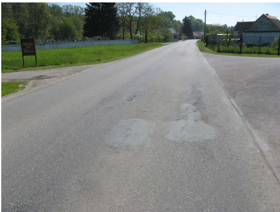
F02, km 0,045+ Lokální mozaikové trhliny.
