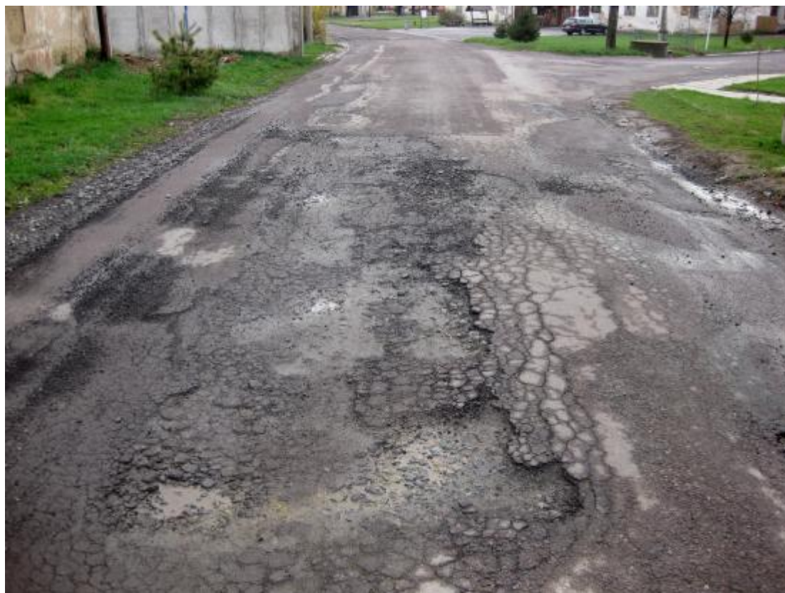
F05: km 2,560– ; výtluky v krytu, rozpad vozovky
