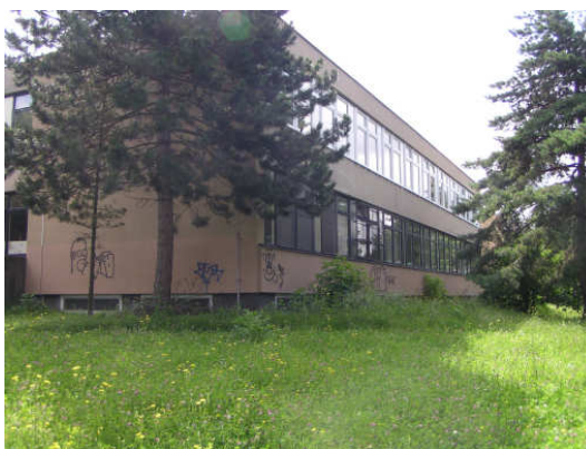
Pavilon stravování a internát
