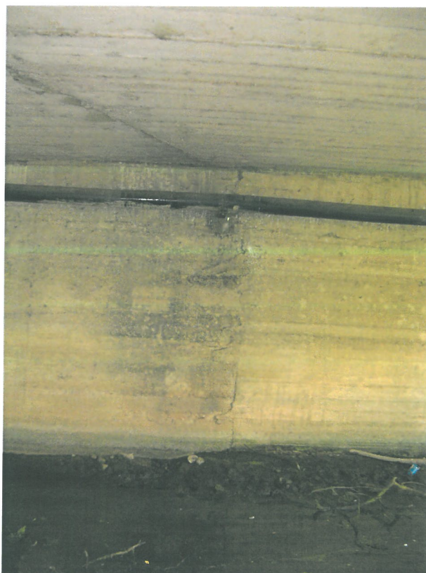
4. Svislá pracovní spára v opěře a pracovní spára v nosné konstrukci – bez průsaků
