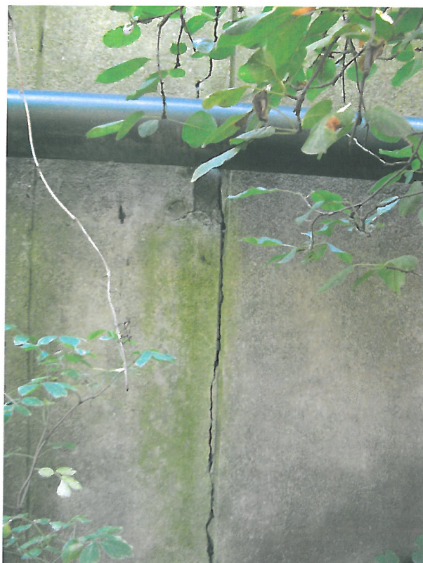
9. Povodní křídlo levobřežní opěry, posunutí 10-15 mm, trhлина šířky 6-10 mm v omítce v místě dilatační spáry
