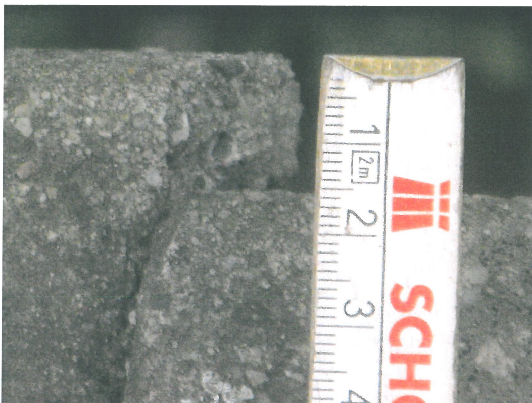
7. Posunutí římsy nad návodním křídlem pravobřežní opěry
