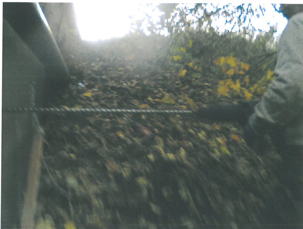
15. Provádění ověřovacích vrtů – povodní křídlo levobřežní opěry
