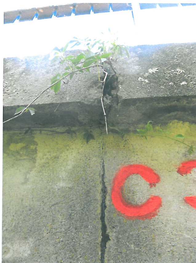
11. Dilatace v římse na konci nosné konstrukce
