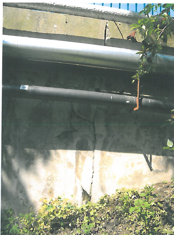
5. Návodní křídlo pravobřežní opěry - trhlina šířky 5-15 mm v omítce v místě dilatační spáry
