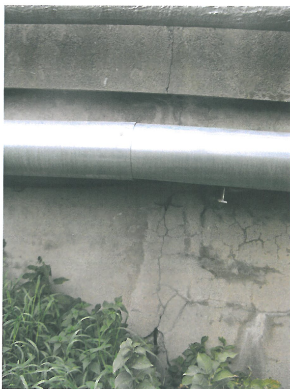
8. Návodní křídlo levobřežní opěry – trhlina šířky 1-2 mm v omítce v místě dilatační spáry; křídlo bez posunutí
