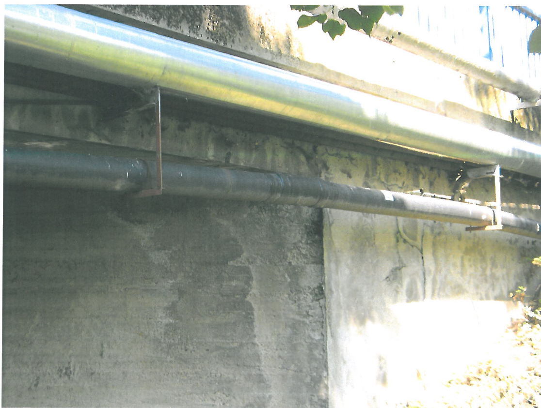
12. Podtékání říms, průsaky v mostní konstrukci
