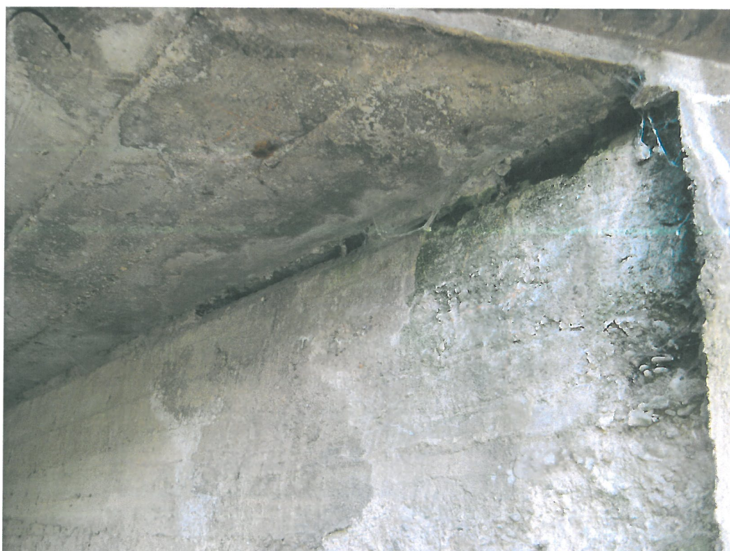
14. Degradace betonu na návodní straně pravobřežní opěry, odpadlý fabion, vrubový kloub bez výplně s protékající vodou
