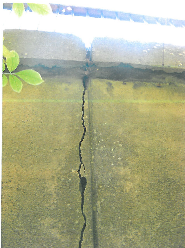
10. Povodní křídlo pravobřežní opěry, posunutí 2-3 mm, trhлина šířky 3-12 mm v omítce v místě dilatační spáry
