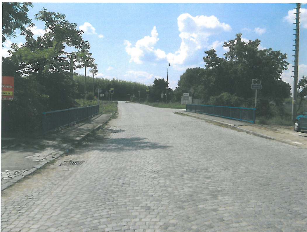
1. Pohled na most od centra – poklesy povrchu vozovky
