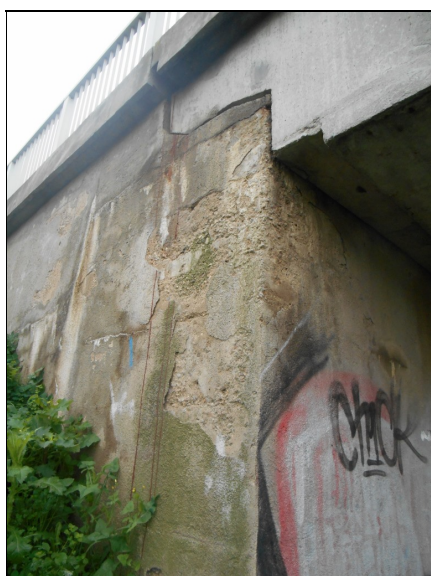
OP4, levá strana. Patrné zatékání mostní závěrou, degradace betonu
