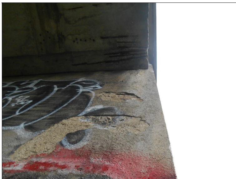
OP4, levá strana. Patrné zatékání mostní závěrou, degradace betonu
