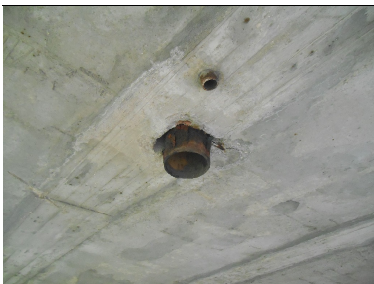
Koroze trubiček odvodnění povrchu vozovky
