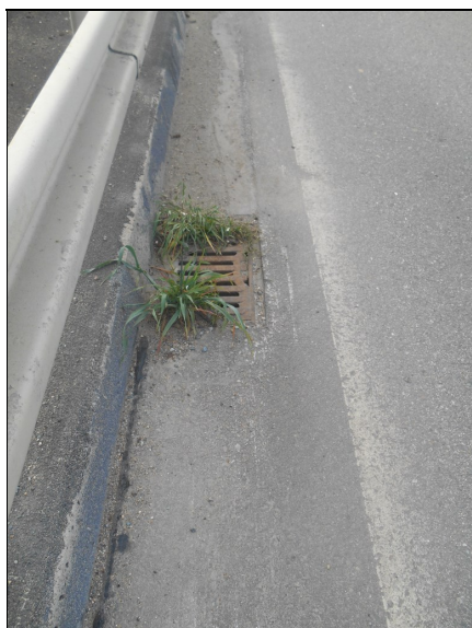
V odvodňovacích vpustích roste vegetace
