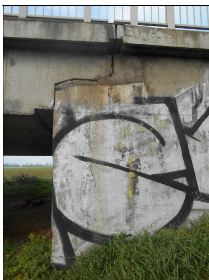
OP1, stopy po zatékání přes mostní závěru. Povrchové úpravy křídla odpadávají
