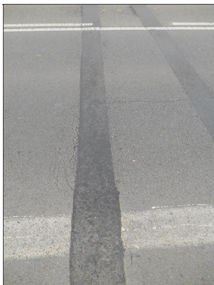
Patrné trhliny ve vozovce u spár nad OP3
