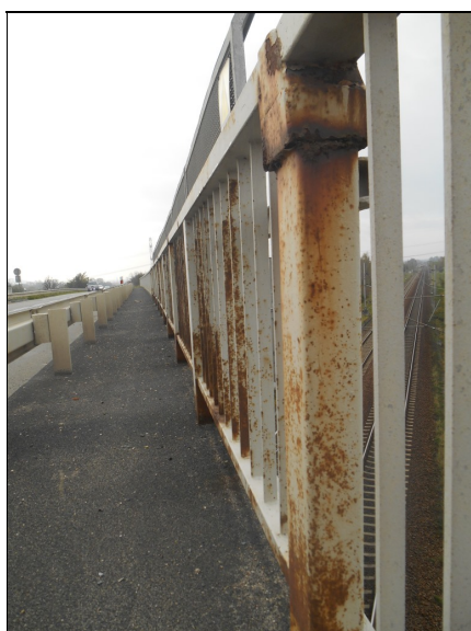
Koroze sloupku zábradlí na obou stranách. Více koroze u protidotykových zábran
