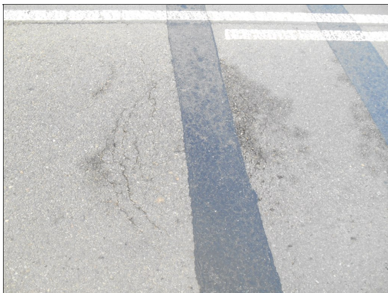
Patrný mírný propad vozovky v oblasti spáry nad OP3 na levé straně
