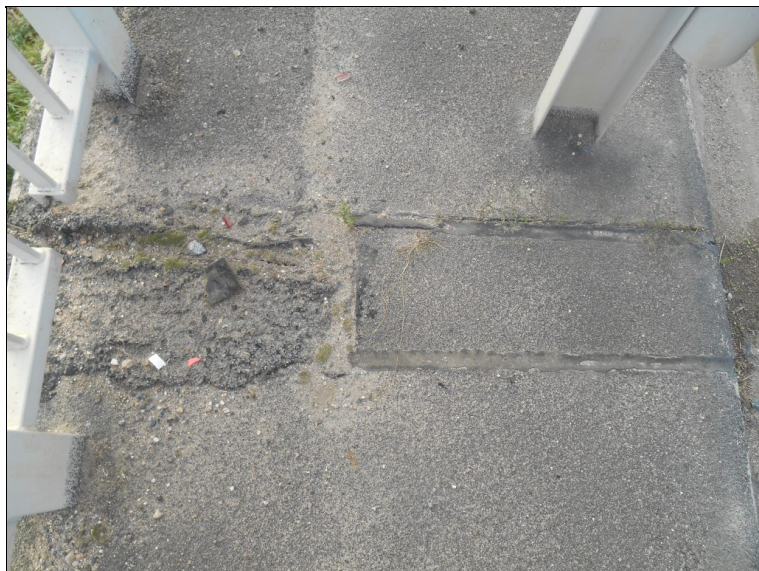
V odvodňovacích vpustích roste vegetace
