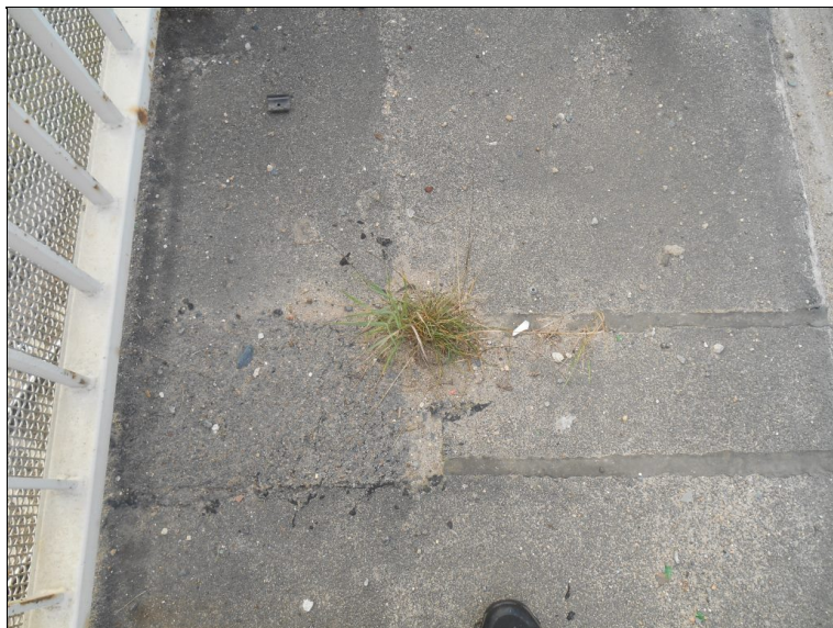
Vegetace uchycená ve spáře nad OP2 vlevo na chodníku
