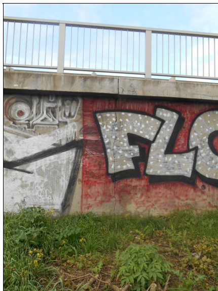
OP1, levá část -svislá trhлина
