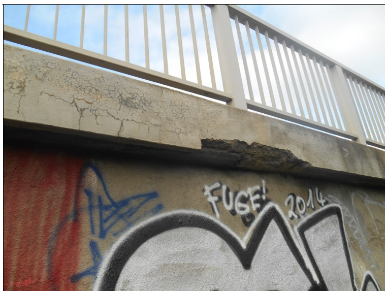
OP1, stopy po zatékání přes mostní závěru. Povrchové úpravy křídla odpadávají
