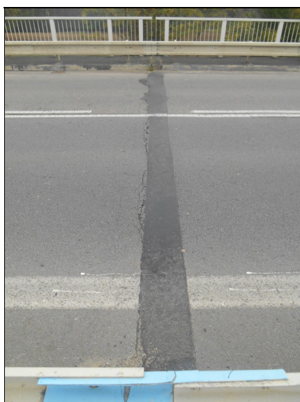
Příčná trhlina nad mostním závěrem u OP4
