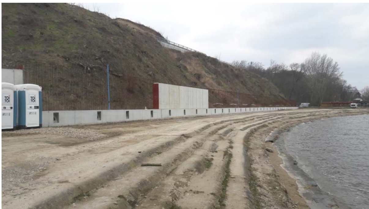
Obr. č.2 - Betonové stupně na břehu nádrže – budou vyfrézovány do tvaru koryta
