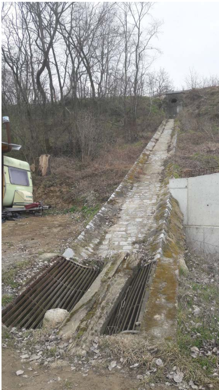
Obr. č.2 - Celkový pohled na skluz, vývařiště a navazující opěrnou zeď (SO 201.3)
