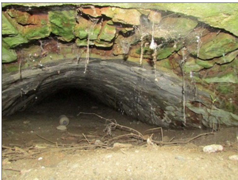
Prostor pod mostem, vypadávání cihel ze zdiva v pravé části klenby
