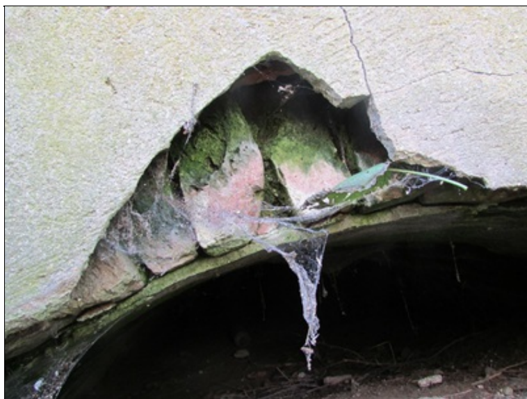
Rozpad omítky a cihelného zdiva na pravém kraji klenby
