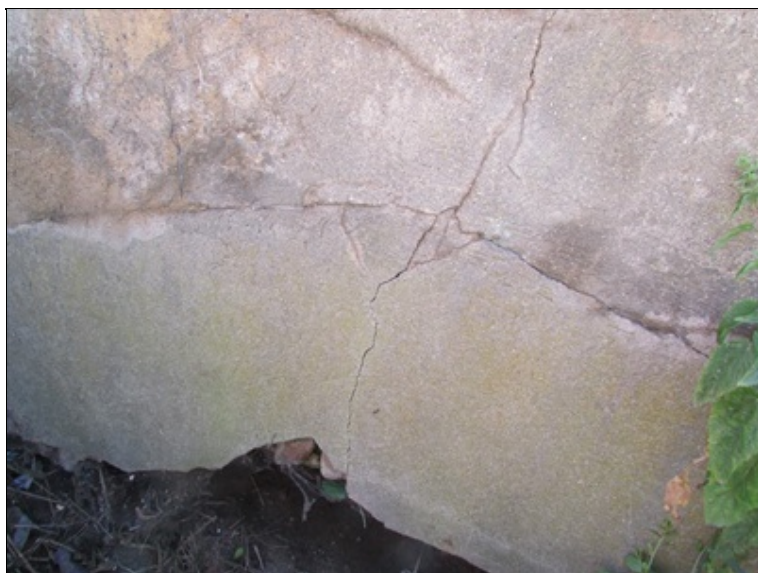
Svislá trhlina v pravé čelní zdi
