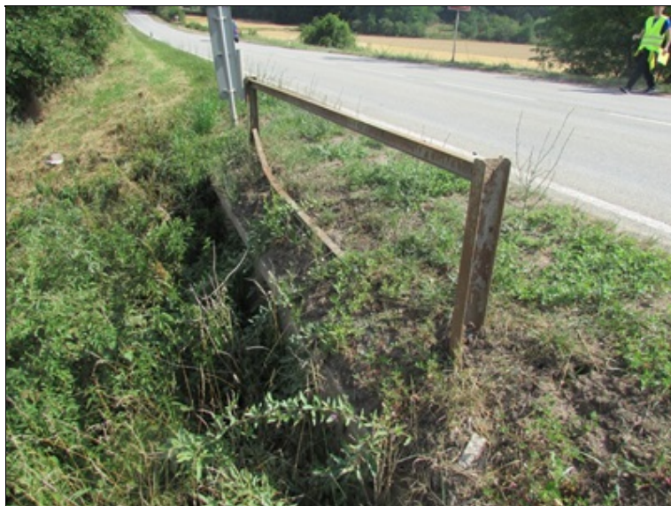
Koroze pravého zábradlí, uvolněné dolní madlo, silná vrstva zeminy a vegetace na římse
