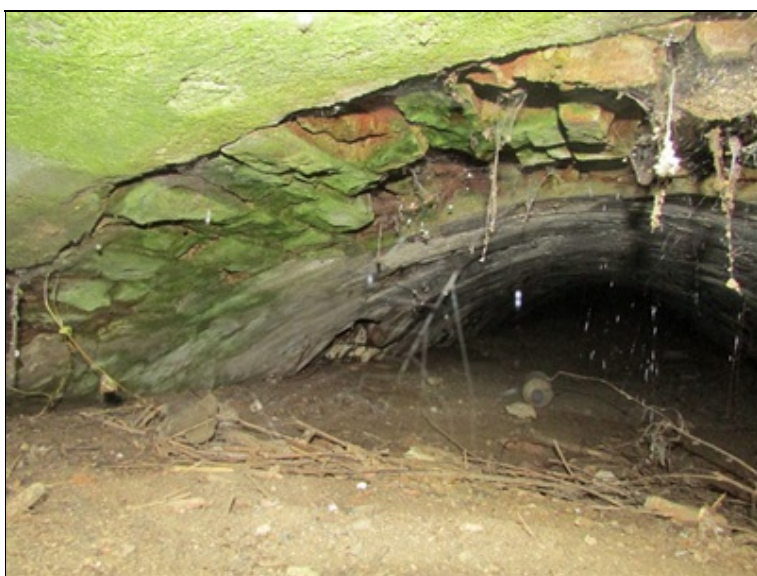
Vypadávání cihel ze zdiva v pravé části klenby
