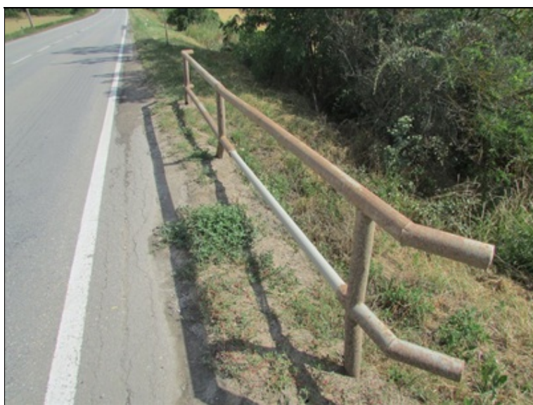
Koroze levého zábradlí, deformace prostředního sloupku
