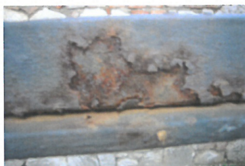
Napadeno silnou korozí, hlavně ve spojích
