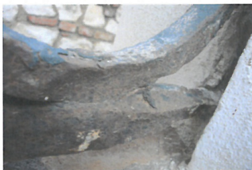
Silná koroze rámu i výplně
