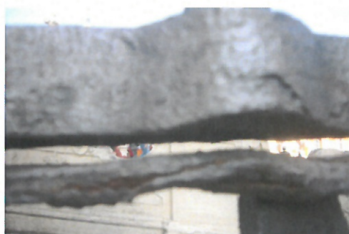
Koroze ve spojích
