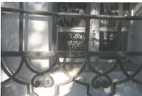
Spodní část mříže nenavazuje na horní část
