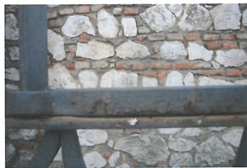
Napadeno silnou korozí, hlavně ve spojích
