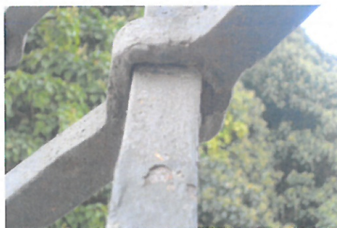
Začínající celková koroze (i na nově vyrobené části mříže)
