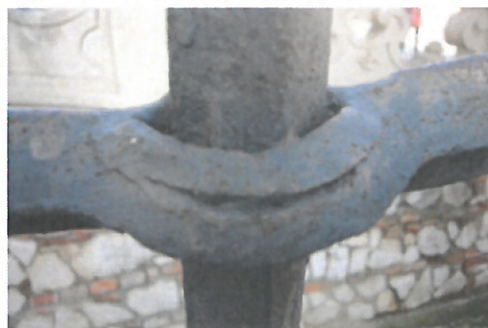
Narušení průbojů hloubkovou korozí
