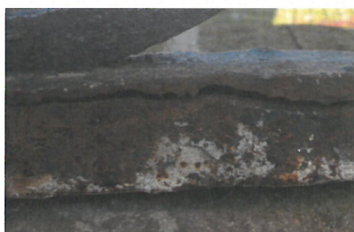
Narušený materiál rámu silnou hloubkovou korozí
