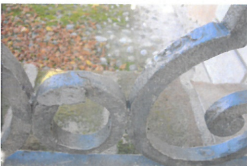
Materiál na mnoha místech narušen hloubkovou korozí
