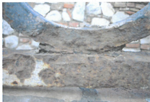
Silná koroze rámu i výplně
