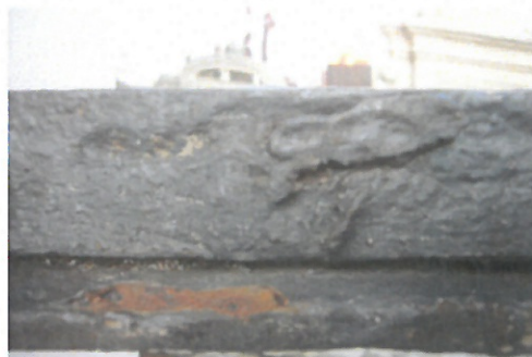
Narušený rám hloubkovou korozí
