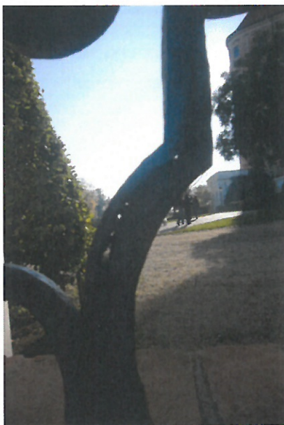
Narušený materiál silnou hloubkovou korozí
