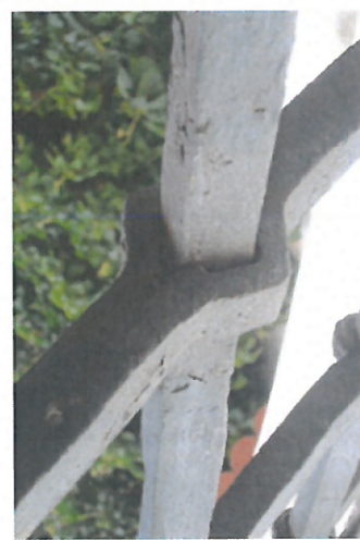
Začínající celková koroze (i na nově vyrobené části mříže)
