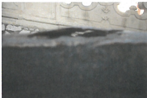
Narušený rám hloubkovou korozí
