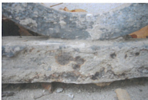
Silná koroze ve spodní části rámu mříže
