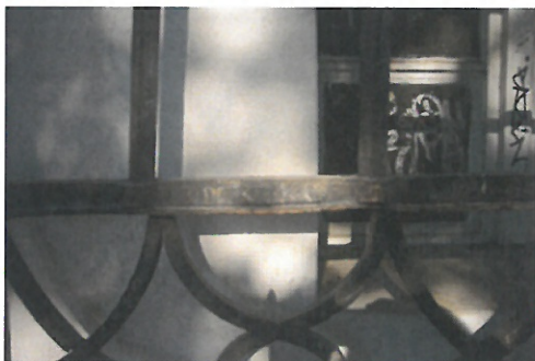
Spodní část mříže nenavazuje na horní část
