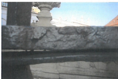
Narušený materiál rámu silnou hloubkovou korozí
