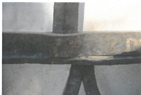
Spodní část mříže nenavazuje na horní část
