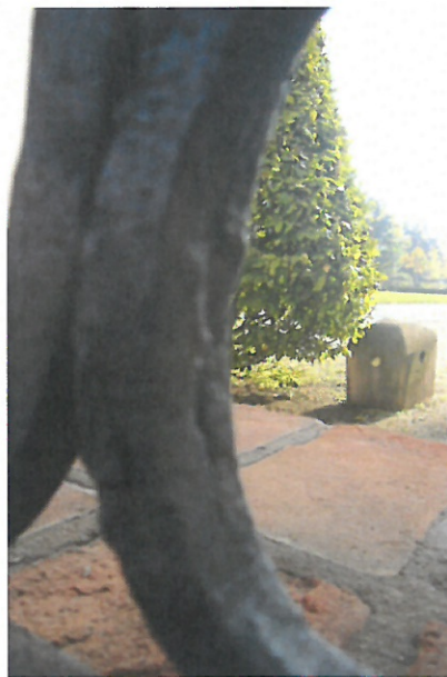
Narušený materiál silnou hloubkovou korozí
