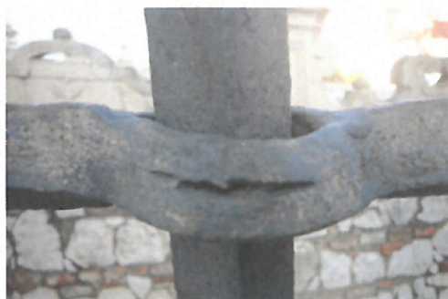
Narušení průbojů hloubkovou korozí
