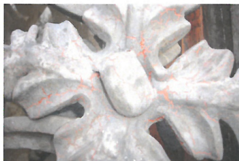
Rozpraskání povrchového nátěru nevhodnou skladbou barev
