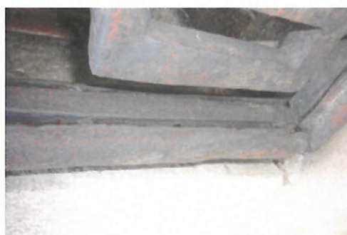
Hlubková koroze s prasklinami na kovových výplních a koroze rámu ve spojích
