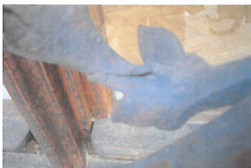
Hlubková koroze s prasklinami na kovových výplních
