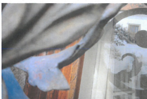
Hlubková koroze s prasklinami na kovových výplních a koroze rámu ve spojích
