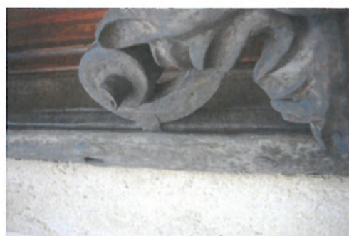
Hlubková koroze rámu ve všech spojích
