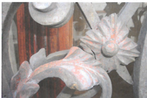
Rozpraskání povrchového nátěru nevhodnou skladbou barev
