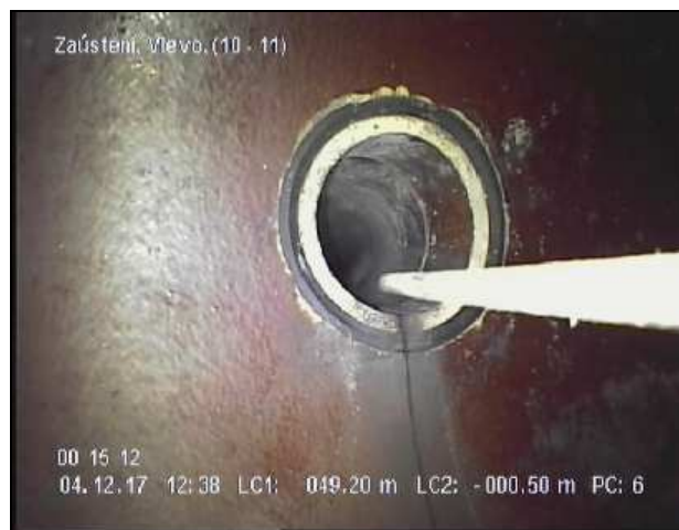
Foto 006 Videopáska: 1 Stav S--L 49,20 m 10 - 11 hod. Zaústění, Vlevo
