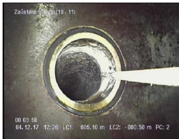
Foto 002 Videopáska: 1 Stav S--L 5,10 m 10 - 11 hod. Zaústění, Vlevo
