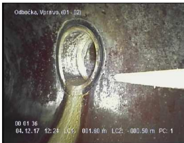
Foto 001 Videopáska: 1 Stav S--R 1,60 m 1 - 2 hod. Zaústění, Vpravo
