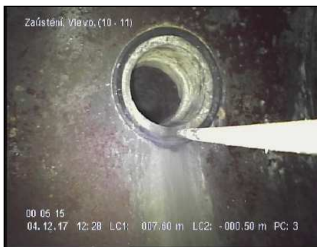
Foto 003 Videopáska: 1 Stav S--L 7,60 m 10 - 11 hod. Zaústění, Vlevo
