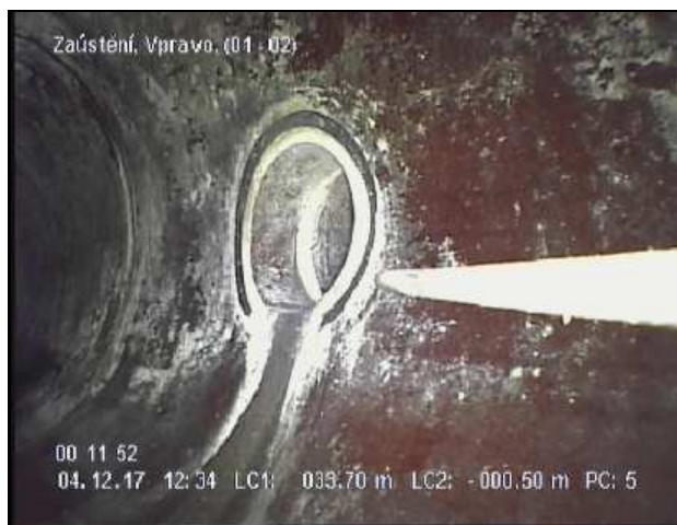
Foto 005 Videopáska: 1 Stav S--R 33,70 m 1 - 2 hod. Zaústění, Vpravo
