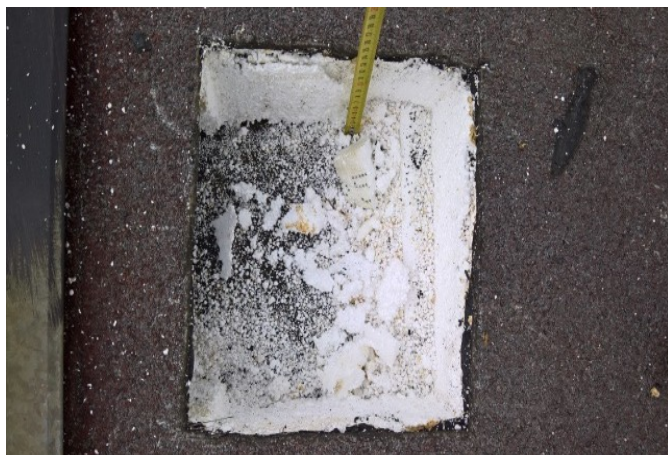
foto/8/ Pohled na provedenou sondu S1
