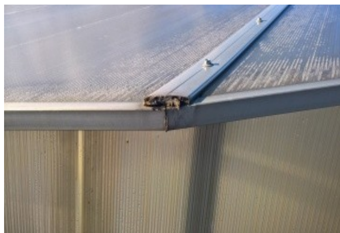
foto/67/ Pohled na detail krycí lišty
