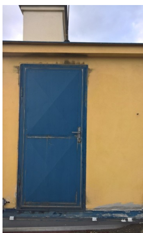
foto/58/ Pohled na vstup na střechu
