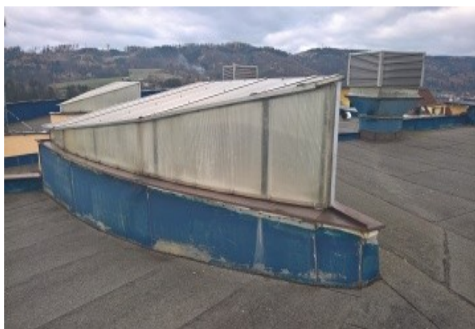
foto/63/ Pohled na střešní světlík
