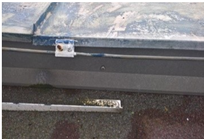
foto/16/ Pohled na napojení oplechování na atiku
