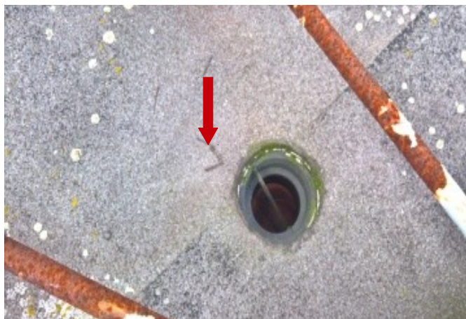
foto/41/ Pohled na předměty v ploše střechy
