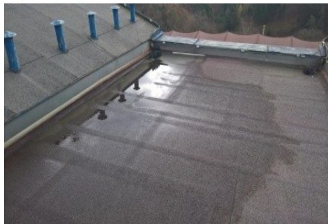
foto/17/ Pohled na atiku
