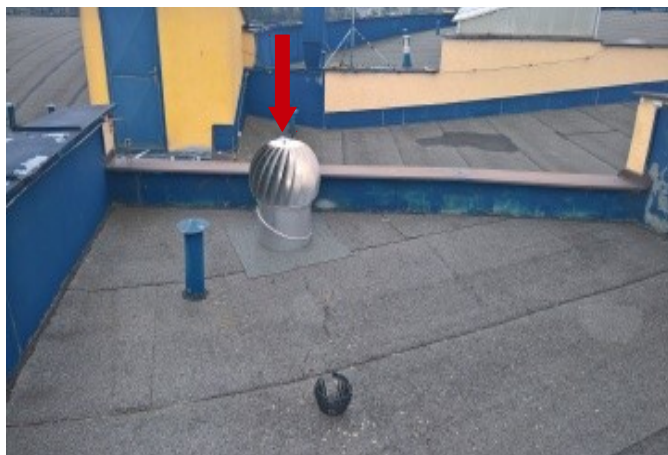
foto/44/ Pohled na nový větrací komínek
