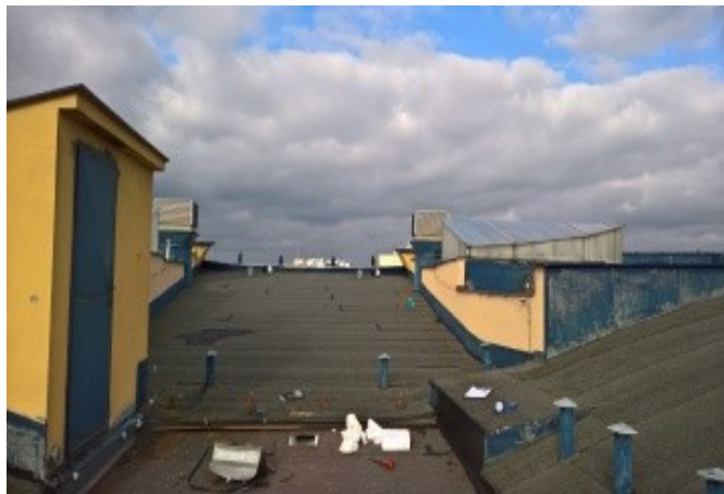
foto/23/ Pohled na předmětnou střechu s horním pláštěm z železobetonové stropní desky
