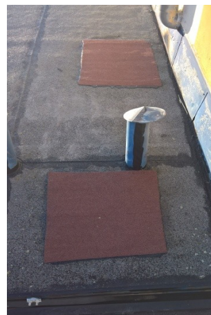
foto/31/ Pohled na zapravenou sondu S3 a S4
