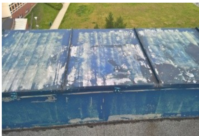
foto/70/ Pohled na oplechování atiky
