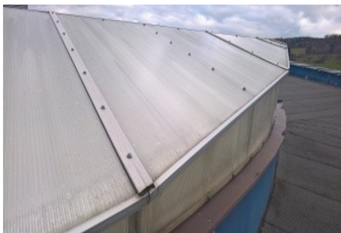
foto/66/ Pohled na napojení polykarbonátových tabulí
