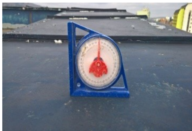
foto/71/ Pohled na sklon oplechování atiky
