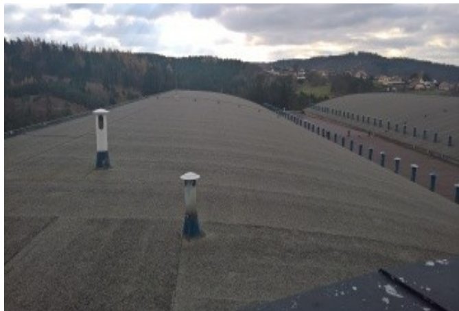
foto/22/ Pohled na předmětné střechy s horním pláštěm z dřevěného prkenného bednění
