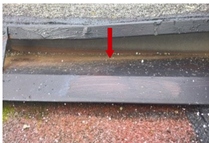
foto/15/ Pohled na výškový zlom napojení střešních rovin
