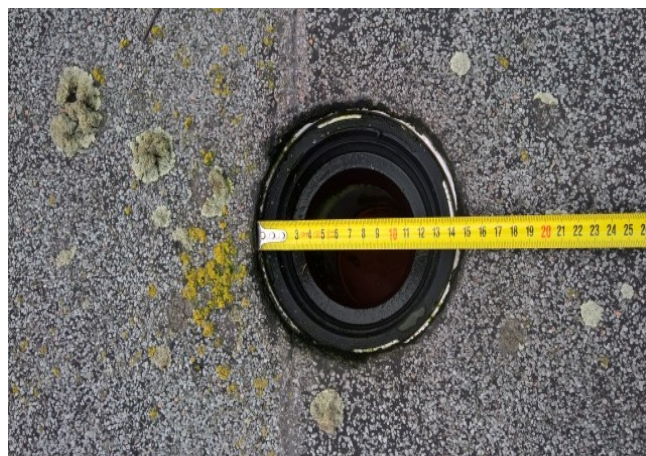
foto/19/ Pohled na střešní vtok
