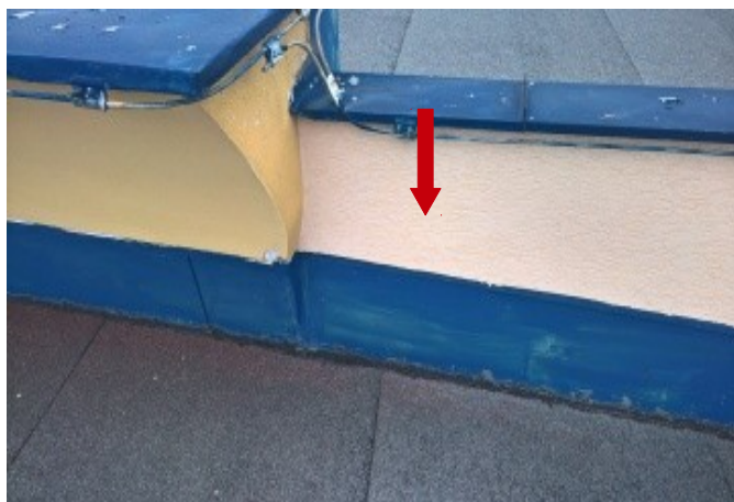
foto/46/ Pohled na ukončení hydroizolace u stěny
