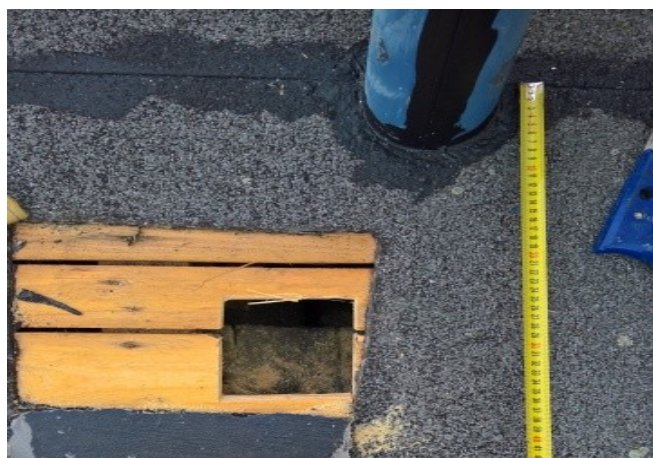
foto/28/ Pohled na provedenou sondu S3
