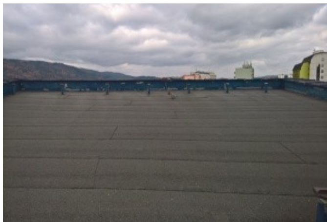
foto/34/ Pohled na předmětné střechy
