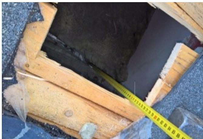
foto/30/ Pohled na provedenou sondu S4
