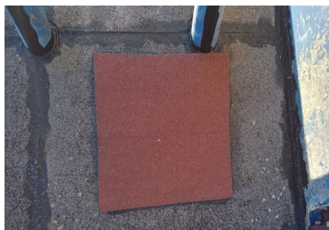
foto/29/ Pohled na zapravenou sondu S3
