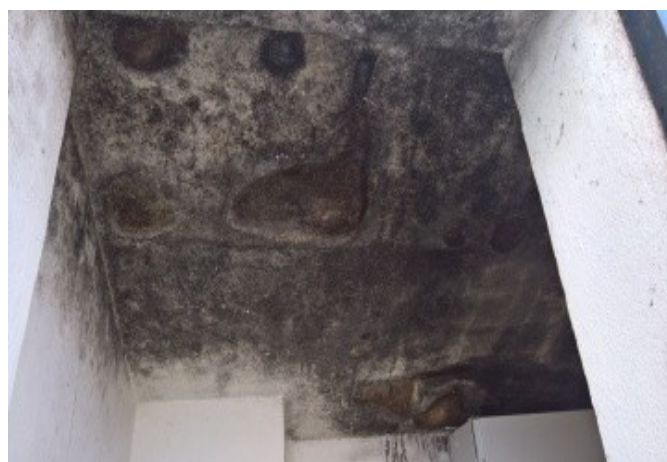
foto/59/ Pohled na strop vstupu
