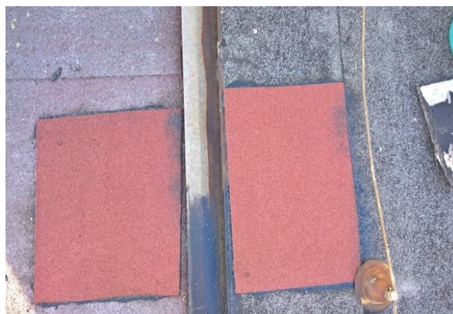
foto/27/ Pohled na zapravenou sondu S2
