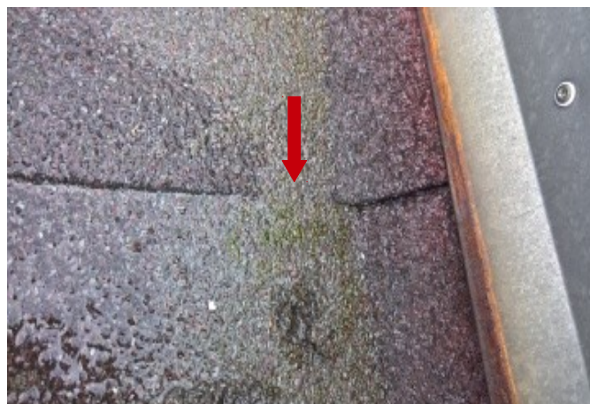
foto/11/ Pohled na naplavený břídlíčný posyp
