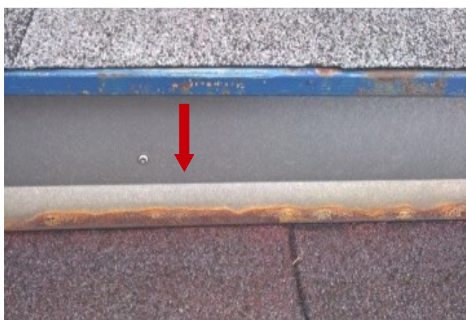
foto/14/ Pohled na výškový zlom napojení střešních rovin
