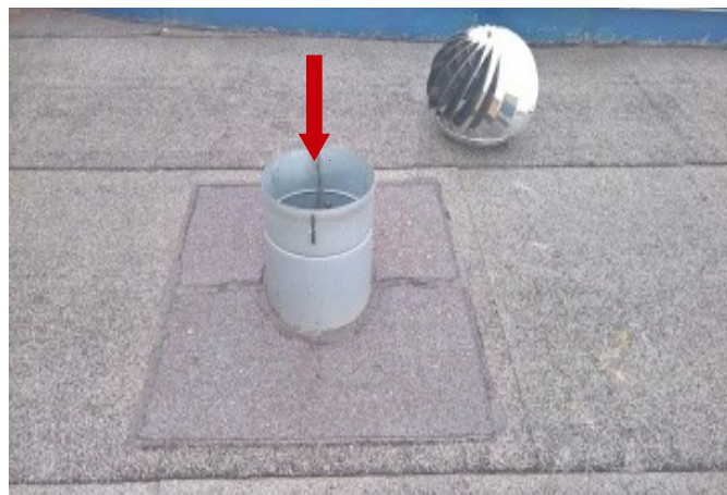
foto/45/ Pohled na nový větrací komínek
