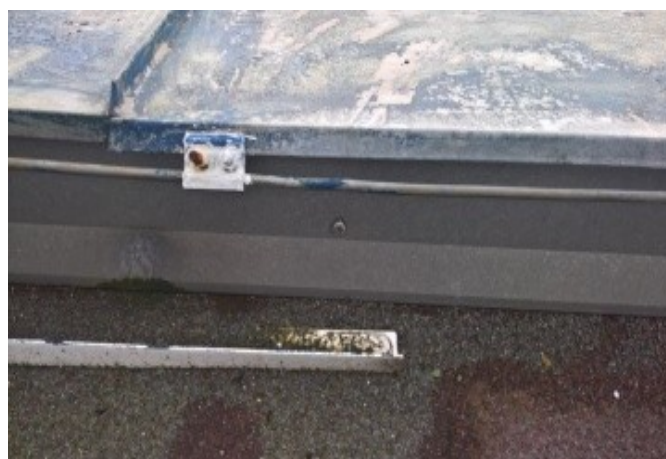
foto/21/ Pohled na oplechování atiky
