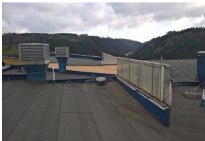
foto/25/ Pohled na části střechy s horním pláštěm z železobetonové stropní desky a se střešními světlíky
