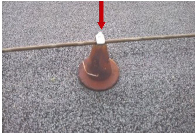
foto/73/ Pohled na uložení kovových podkladů sloužících k uchycení ocelového lana hromosvodu
