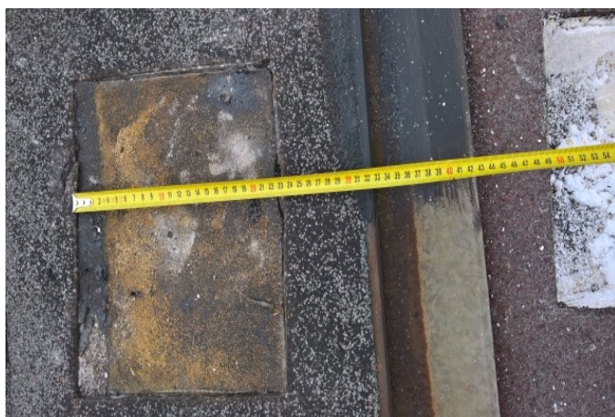
foto/26/ Pohled na provedenou sondu S2
