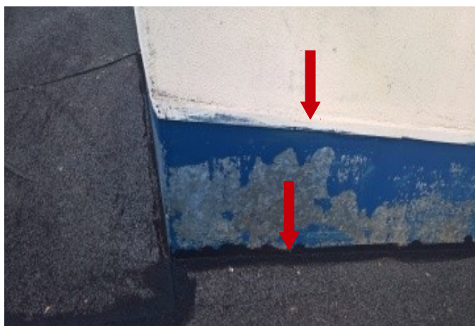
foto/50/ Pohled na ukončená hydroizolace u vyvýšené části
