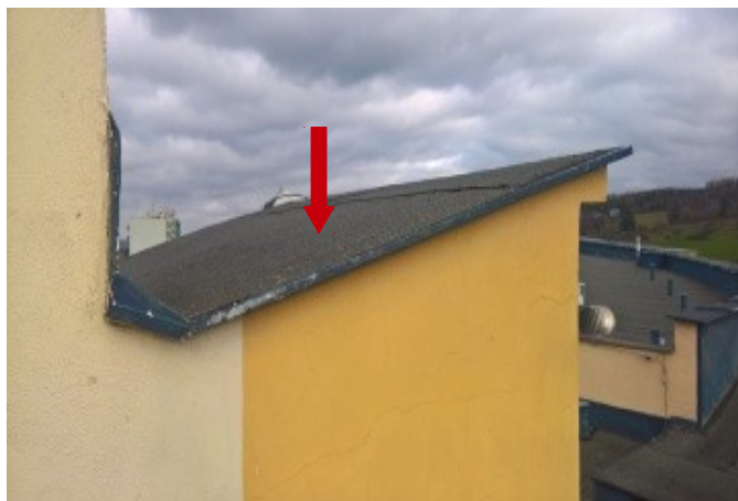
foto/56/ Pohled na střechu vyvýšené části
