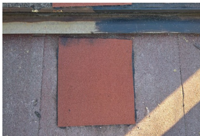
foto/9/ Pohled na zapravenou sondu S1
