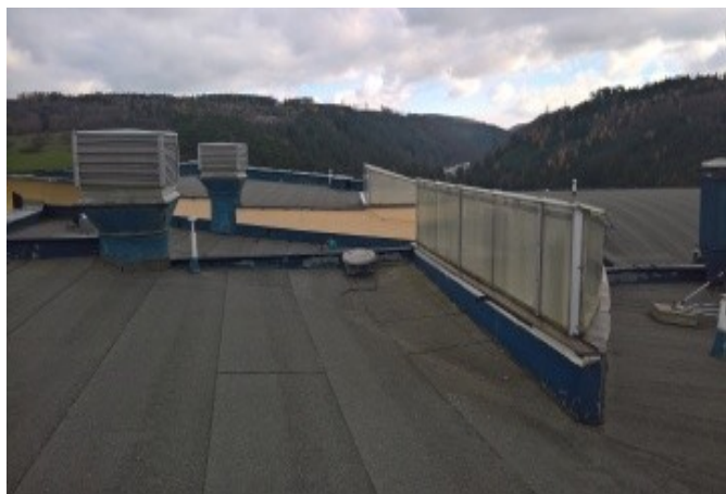
foto/35/ Pohled na předmětné střechy
