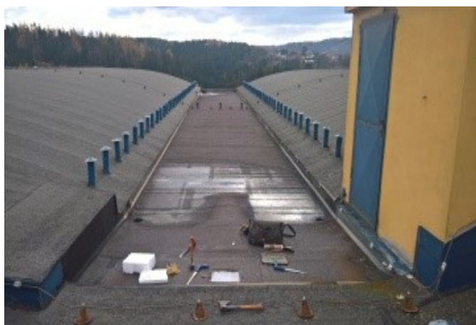
foto/4/ Pohled na jednoplášťovou střeču
