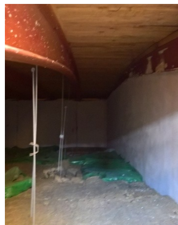
foto/33/ Pohled do provedené sondy S3 , S4
