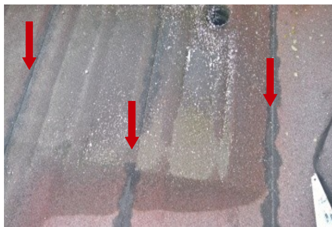
foto/13/ Pohled na opravy spojů pomocí stěrky
