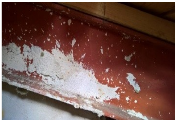
foto/32/ Pohled do provedené sondy S3
