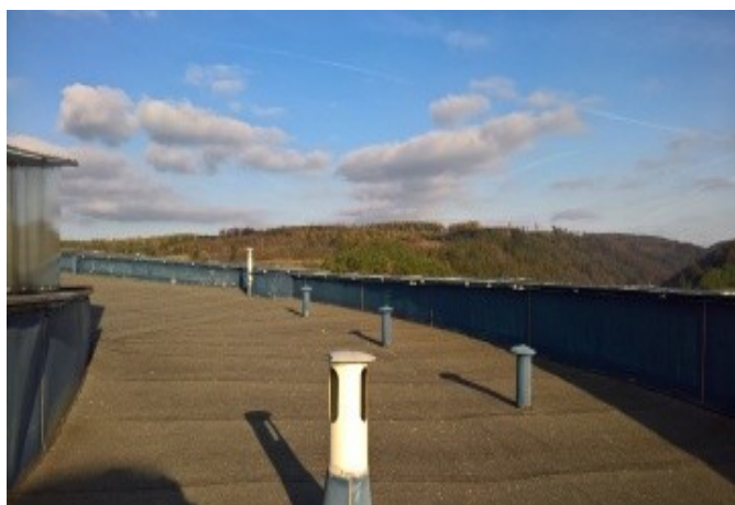
foto/37/ Pohled na předmětné střechy
