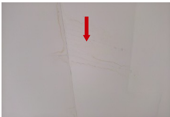
foto/2/ Pohled na vlhkostní mapy uvnitř posuzovaného objektu
