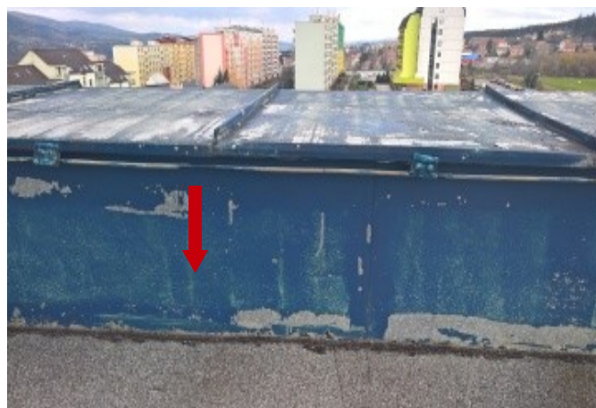
foto/47/ Pohled na ukončení hydroizolace u atiky
