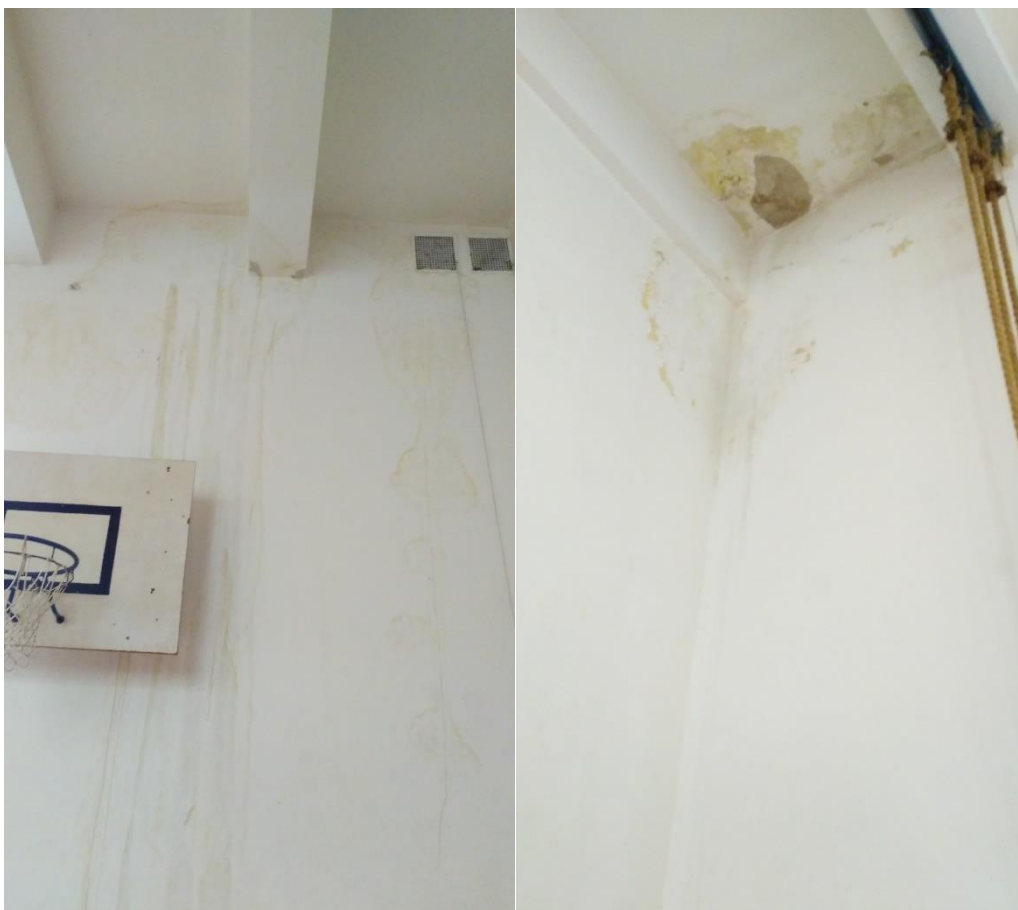
Obr. 15 a 16: Defekty v důsledku porušení vodotěsnící vrstvy střešního pláště tělocvičny, zdroj: Univers projekt
