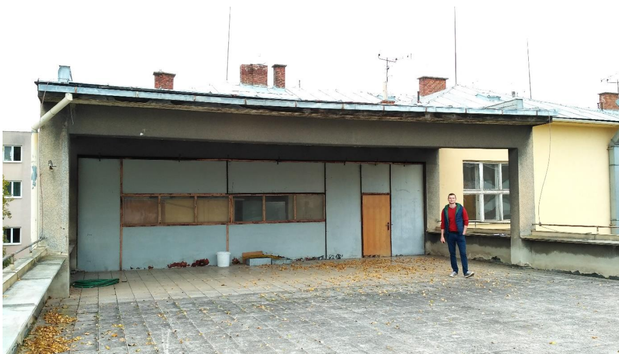
Obr. 11: Výplň v ŽB rámu, které bude nahrazena novou vyzdívkou, zdroj: Univers projekt
