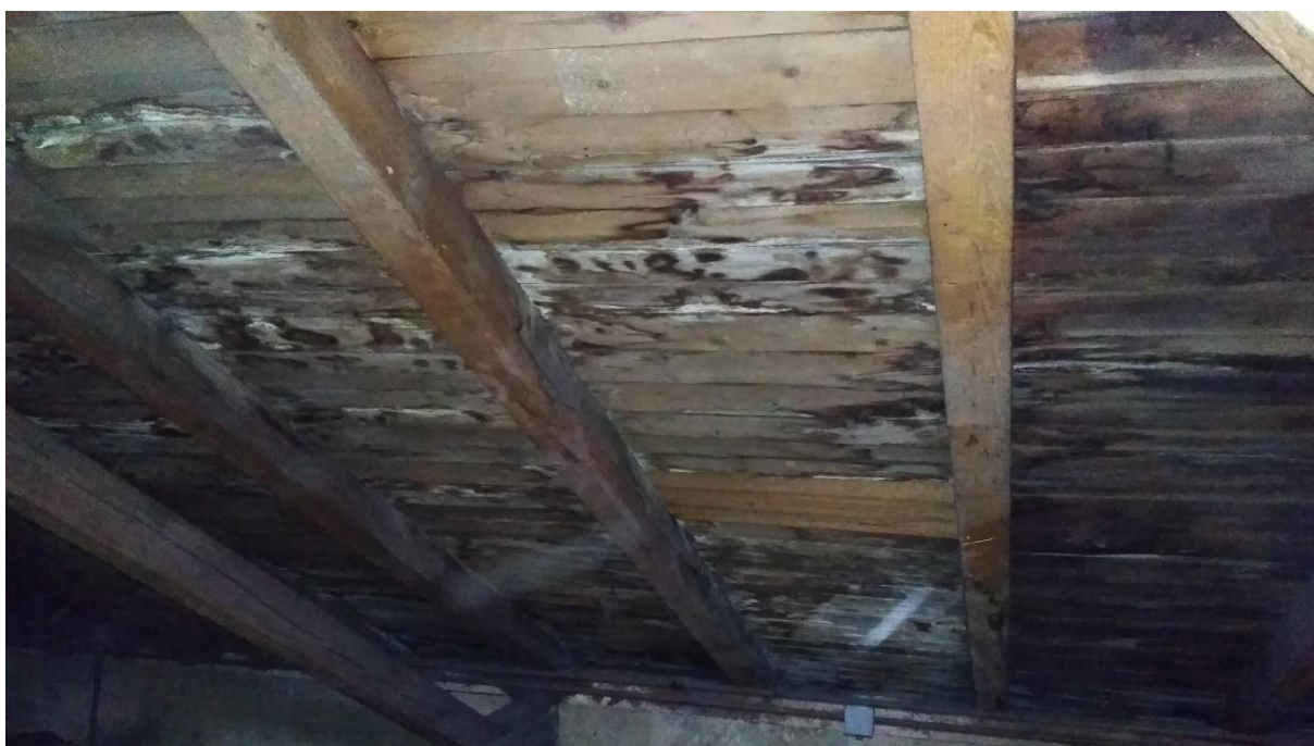
Obr. 13: Napadený záklop střešního pláště, zdroj: Univers projekt
