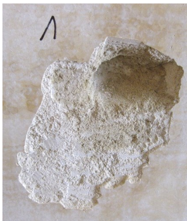
Obr. 6 Sonda č. 1 – přední stěna
