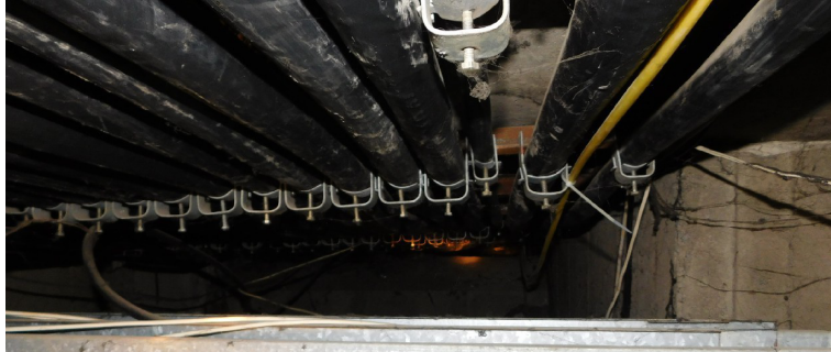
FOTO "4" - vývod z trafostanice TS1
