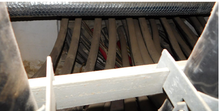
FOTO "9" - Výstup kabel. trasy do tvárnicové trasy (Spiroly)
