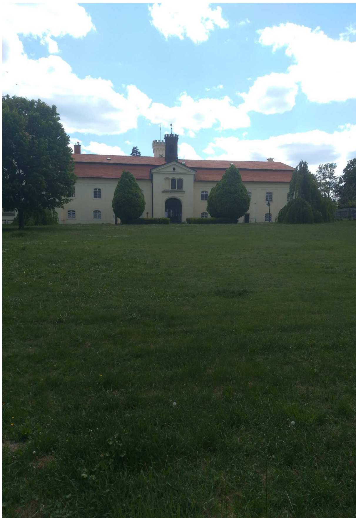
Foto č.5: Zámecký park – pohled ze severní strany.
