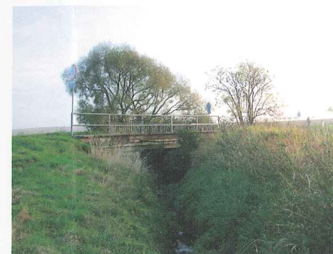
STÁVAJÍCÍ STAV MOSTU NA SILNICI II/431 PŘES ŽLEBOVÝ POTOK
