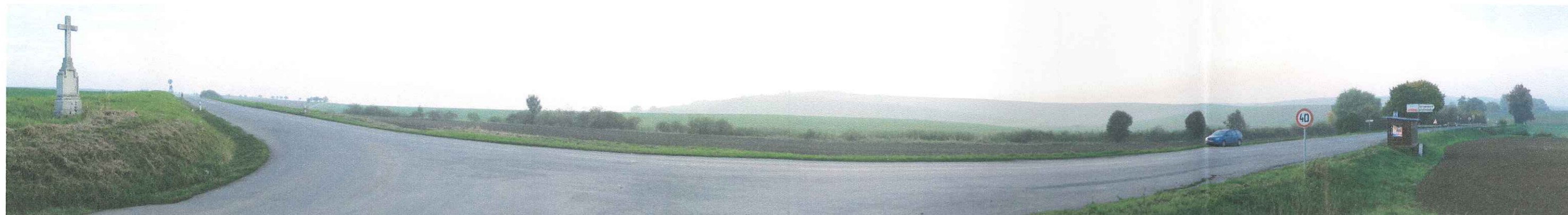
POHLED OD VÝCHODU NA KŘIŽOVATKU SILNIC II/431 A II/4317. VPRAVO STÁVAJÍCÍ MOST PŘES ŽLEBOVÝ POTOK.
