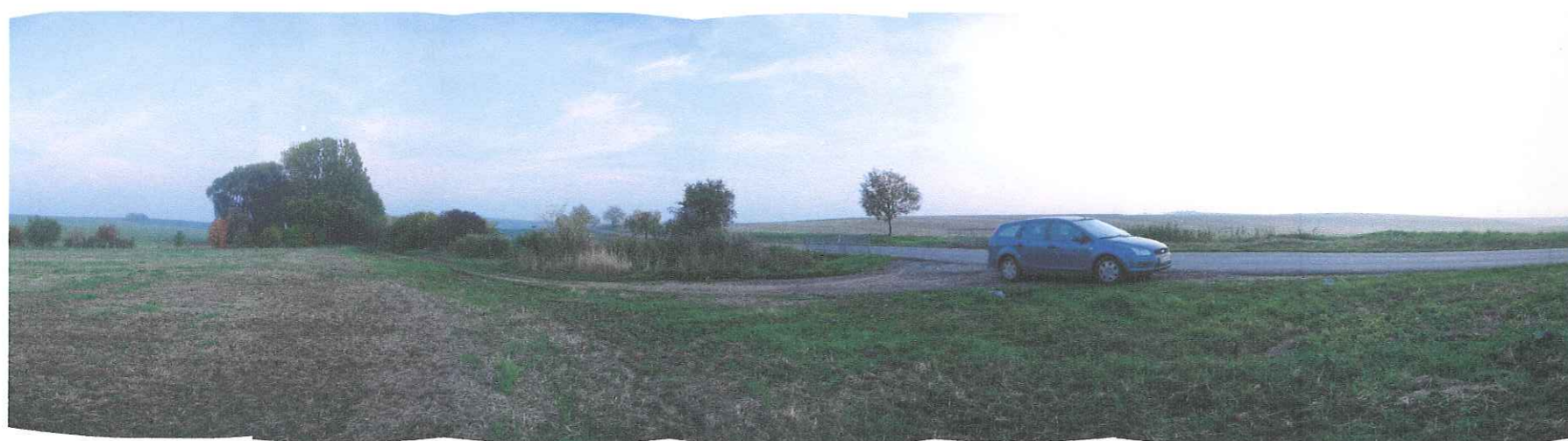
POHLED OD JIHOVÝCHODU NA STÁVAJÍCÍ MOST NA SILNICI II/431 PŘES ČERNČÍNSKÝ POTOK
