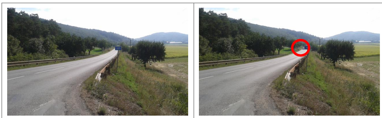
Obrázek 3: SDZ zakrývající vozidlo přijíždějící zprava. Na fotce vlevo v kroužku označen osobní automobil, který je na fotografii vlevo zakryt SDZ.
