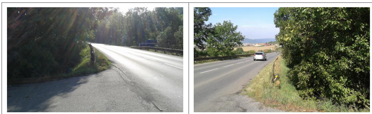
Obrázek 4: Vzrostlá zeleň brání v rozhledu na vozidla jedoucí po hlavní PK – pohled vlevo a vpravo.
