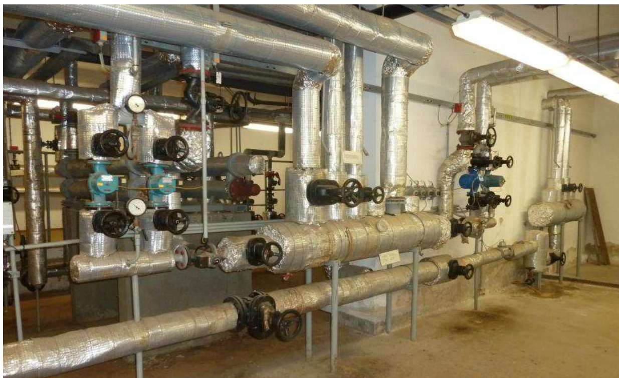
Obrázek 6: Předávací stanice pavilon E – rozdělovač síťové vody
