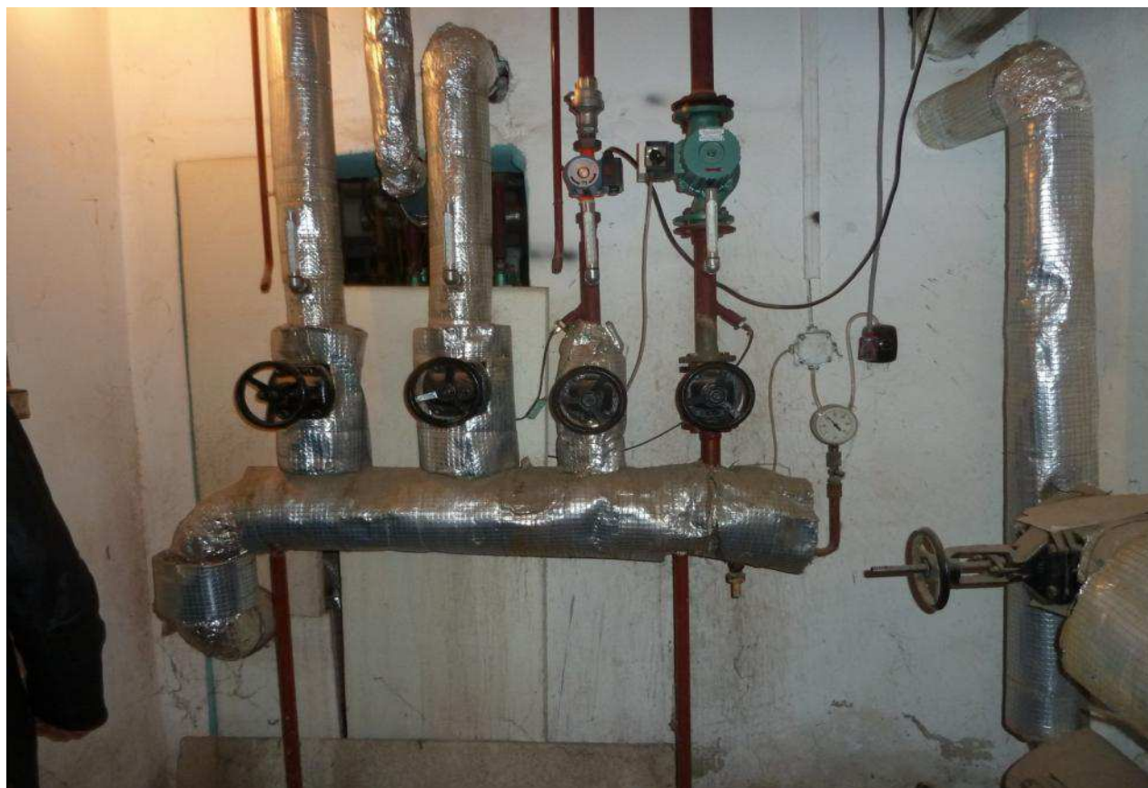
Obrázek 10: Ubytovna – rozdělovač a TUV
