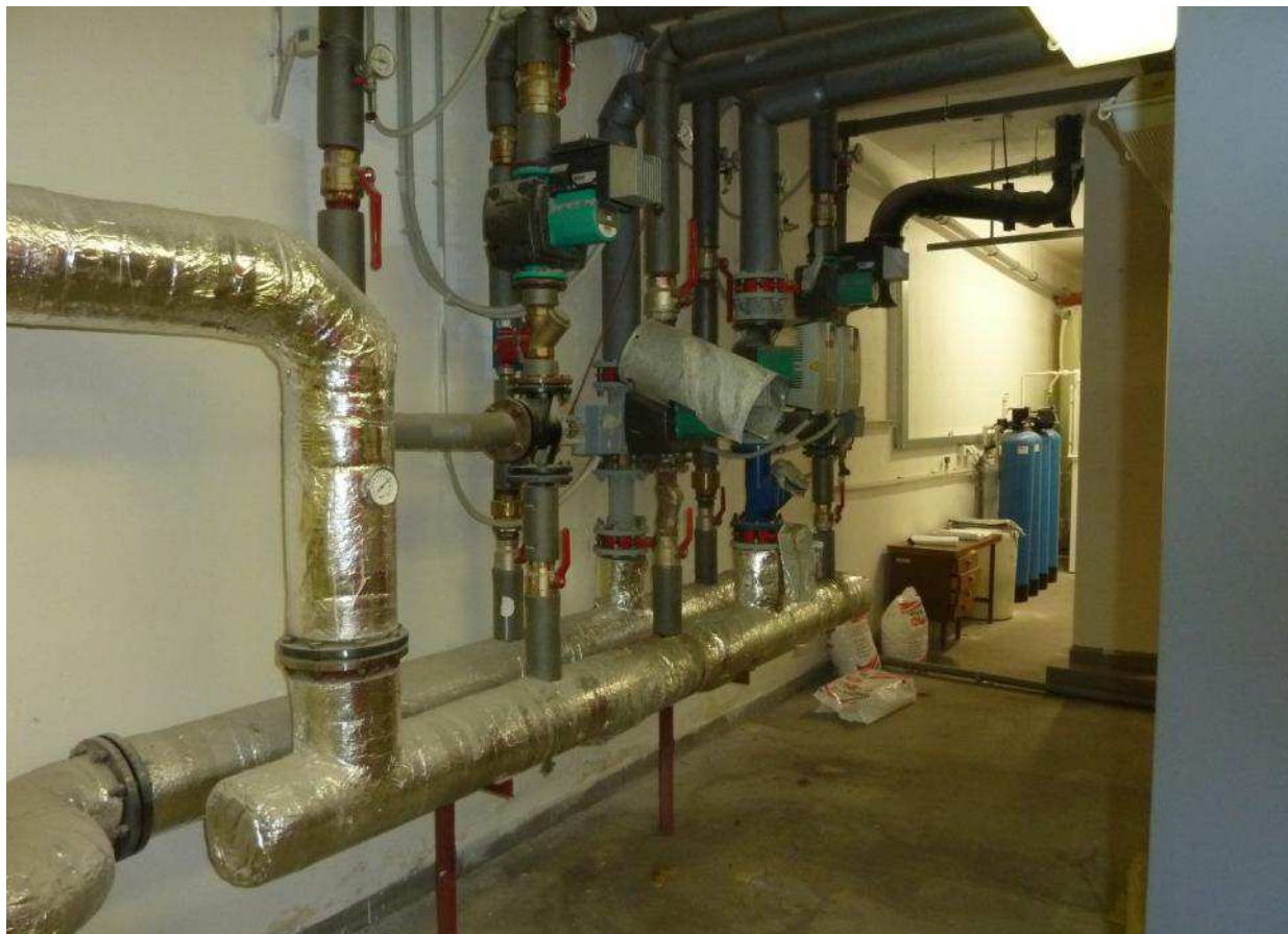
Obrázek 5: Předávací stanice pavilon F – rozdělovač síťové vody
