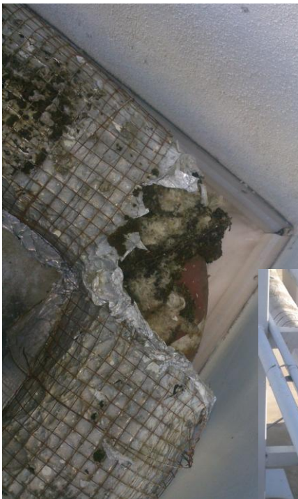
Foto č.2 Rozvody chladu – poškození tepelné izolace
