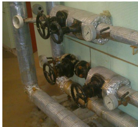
Foto č.3 Rozvody chladu – VZT jednotky, poškození popř. zcela bez tepelné izolace
