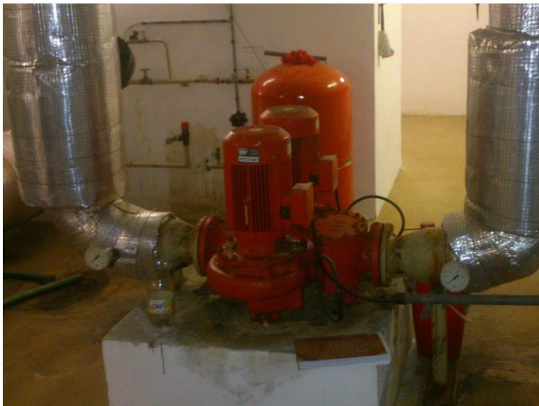
Foto č.2 Oběhová čerpadla chladu
