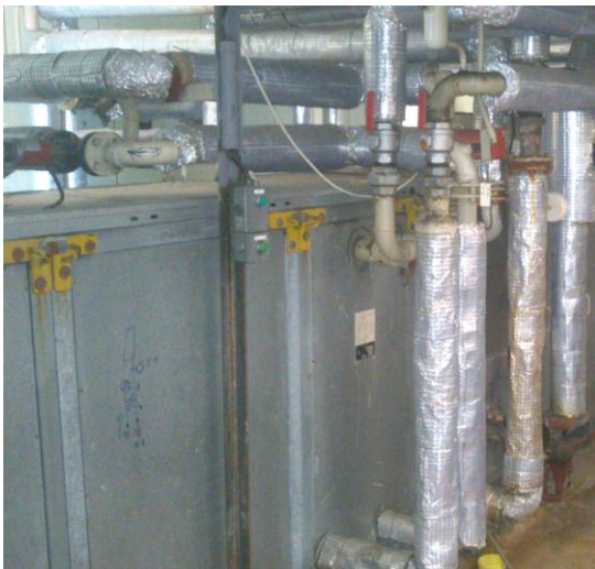
Foto č.3 Rozvody chladu – VZT jednotky, poškození popř. zcela bez tepelné izolace
