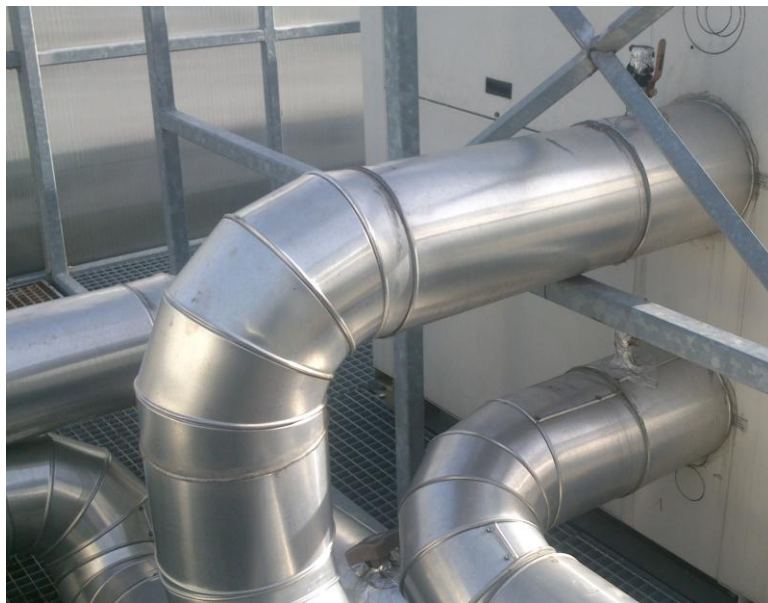
Foto č.2 Venkovní rozvody chladu s vyhovující tepelnou izolací
