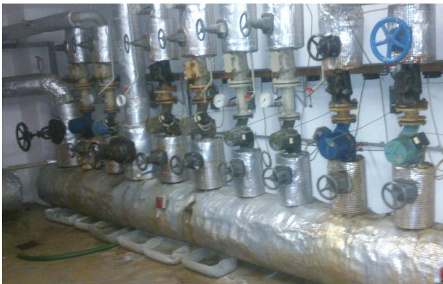
Foto č.6 Kombinovaný rozdělovač chladu
