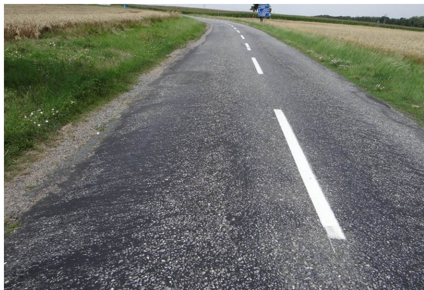
Ztráta makro a mikrotextury, zarostlý příkop, poškozený okraj vozovky
