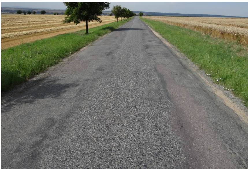
Vysprávky, ztráta makro i mikrotextury
