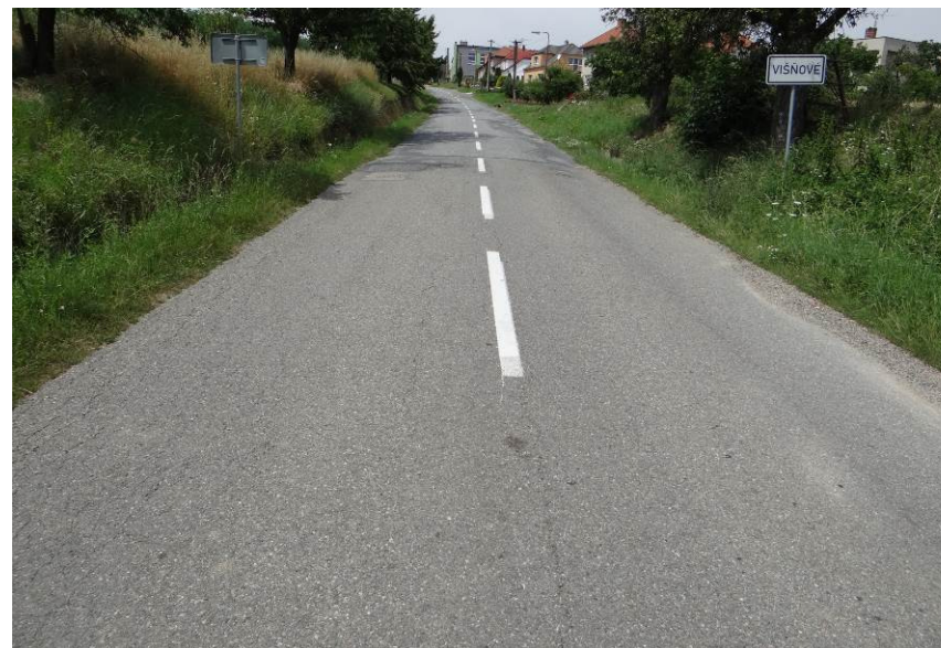
Podélná rozvětvená trhlina, trhliny na okraji vozovky, konec úseku
