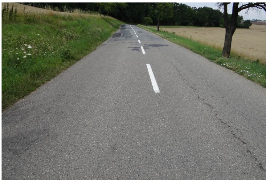
Zarostlé příkopy, trhliny na okraji vozovky, změna povrchu vozovky
