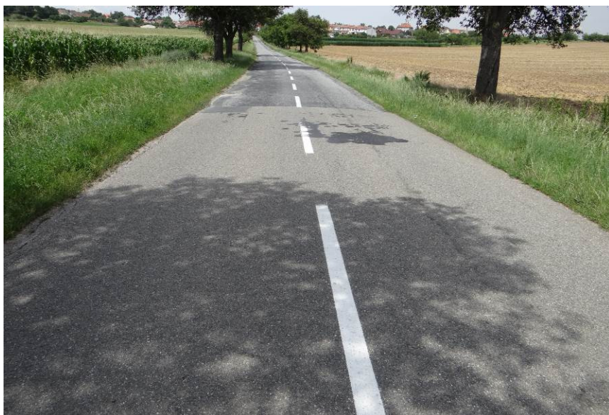
Poškozený okraj vozovky, zarostlý příkop, změna povrchu vozovky
