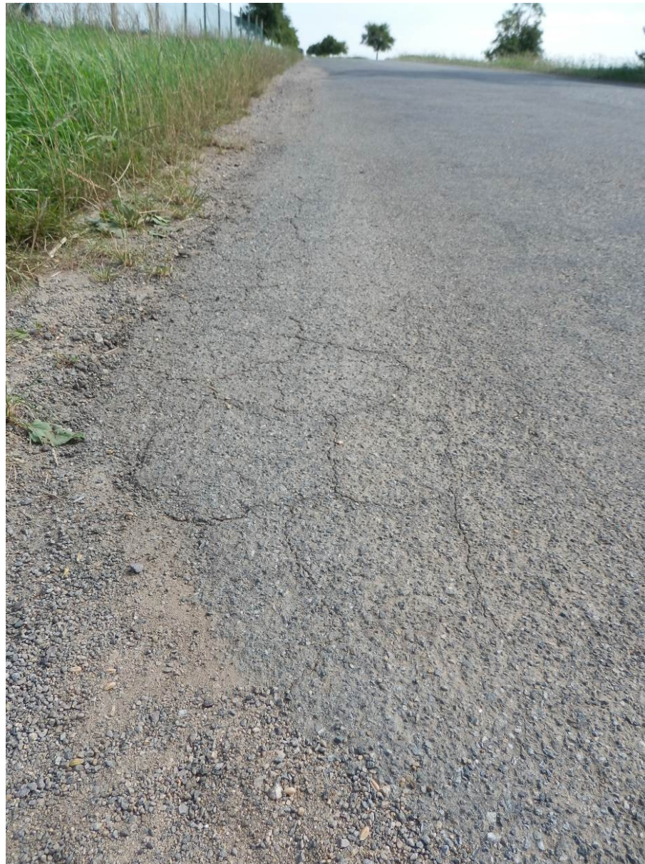
Poškozený okraj vozovky, trhliny
