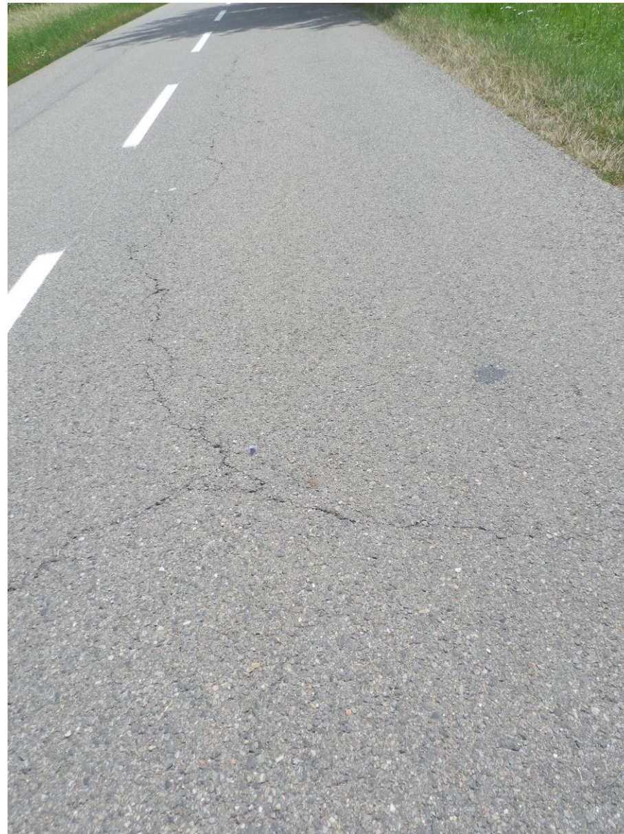
Rozvětvená trhlina v podélném i příčném směru
