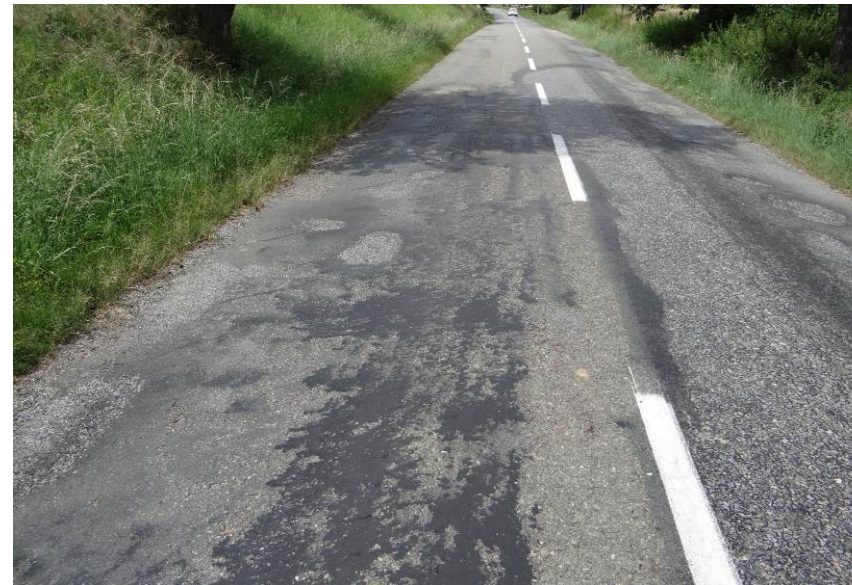
Ztráta makro a mikrotextury, poškozený okraj vozovky, vysprávk
