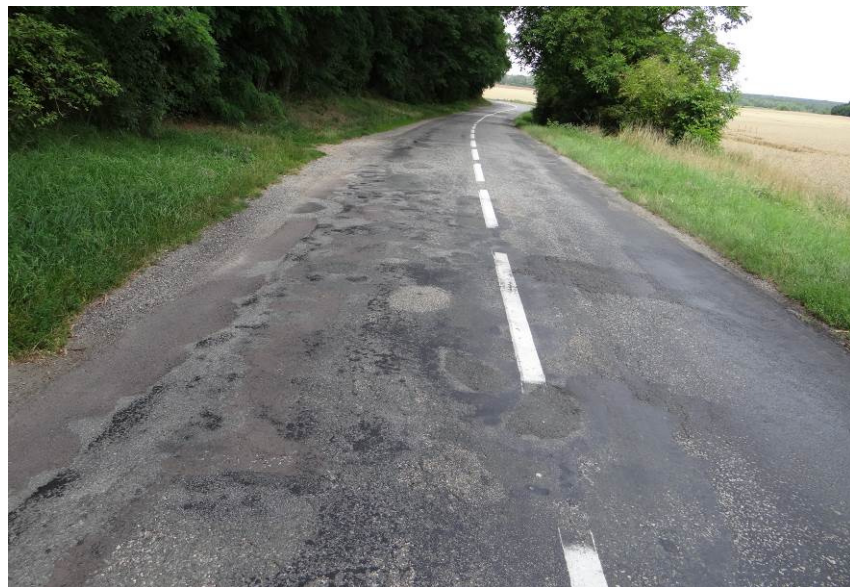
Vysprávk, ztráta makro a mikrotextury
