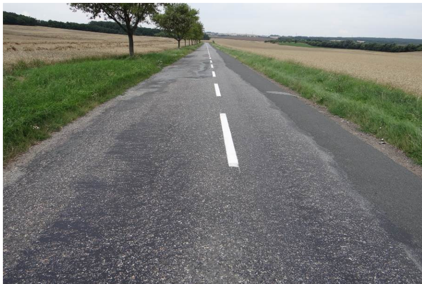
Zarostlé příkopy, ztráta makro i mikrotextury, vysprávk
