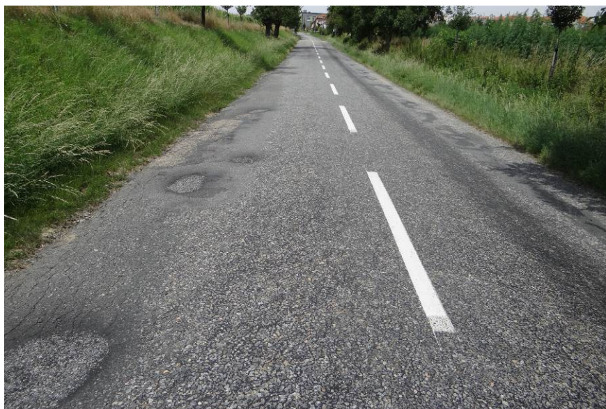
Ztráta makro a mikrotextury, příkopy, poškozený okraj vozovky, vysprávk
