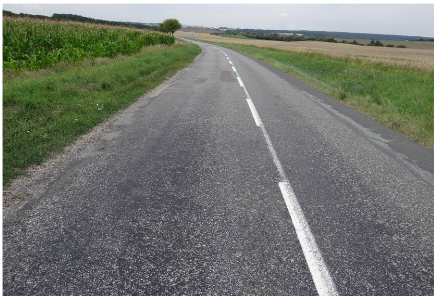
Zarostlé příkopy, ztráta makro i mikrotextury, vysprávk
