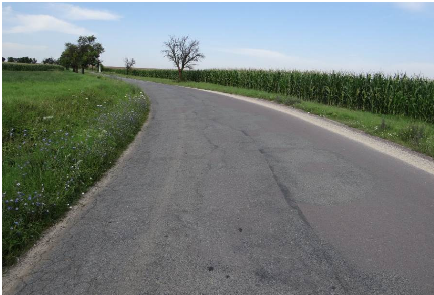
Vysprávky, mozaikové trhliny, poškozený okraj vozovky
