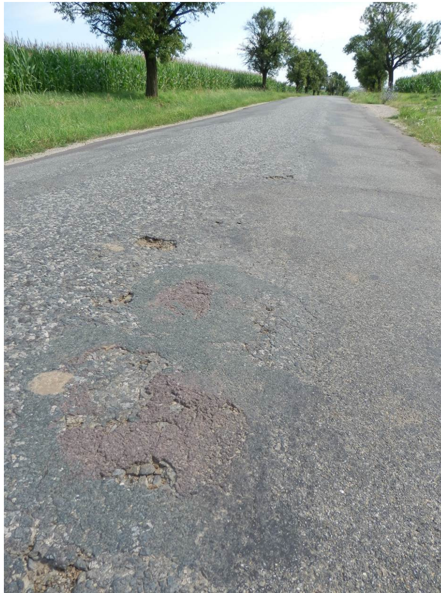
Výtluky, mozaikové trhliny, vysprávky, ztráta makro i mikrotextury
