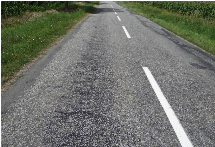
Ztráta makro a mikrotextury, zarostlý příkop, vysprávký
