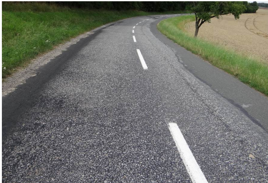
Zarostlé příkopy, poškozené okraje vozovky, vysprávk
