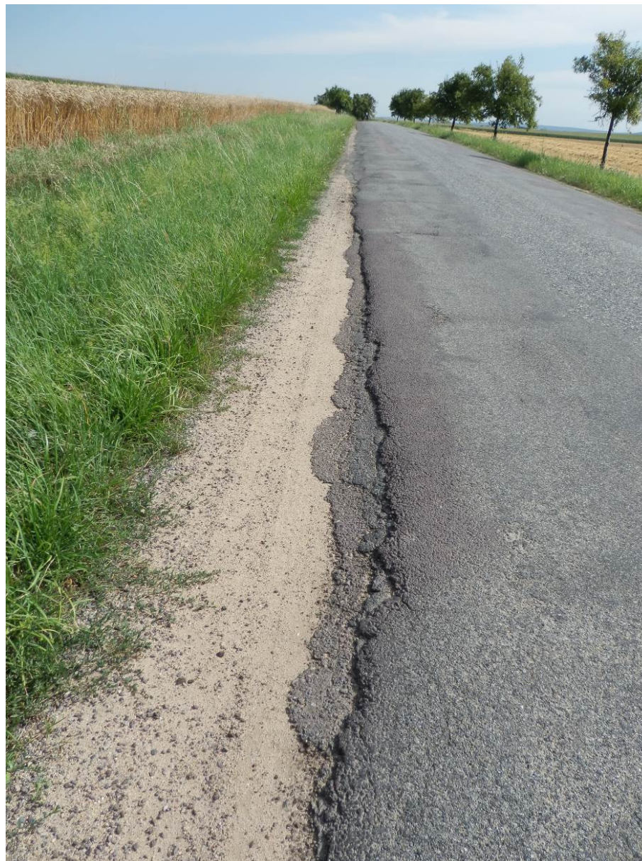
Poškozený okraj vozovky
