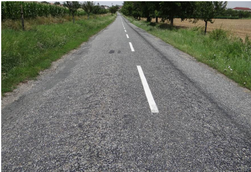
Ztráta makro a mikrotextury, poškozený okraj vozovky
