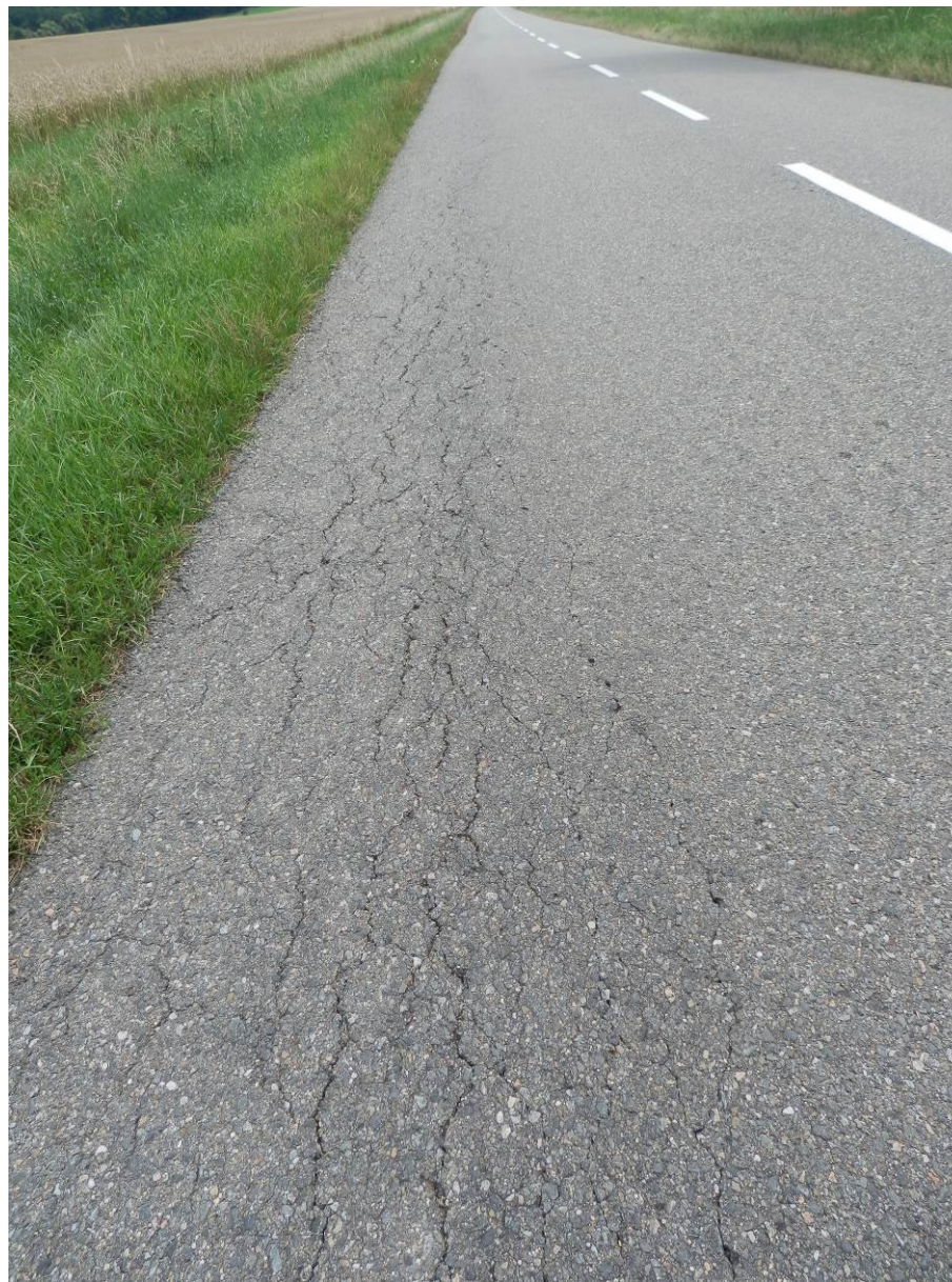
Trhliny na okraji vozovky
