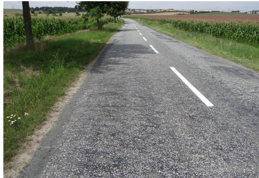
Ztráta makro a mikrotextury, poškozený okraj vozovky
