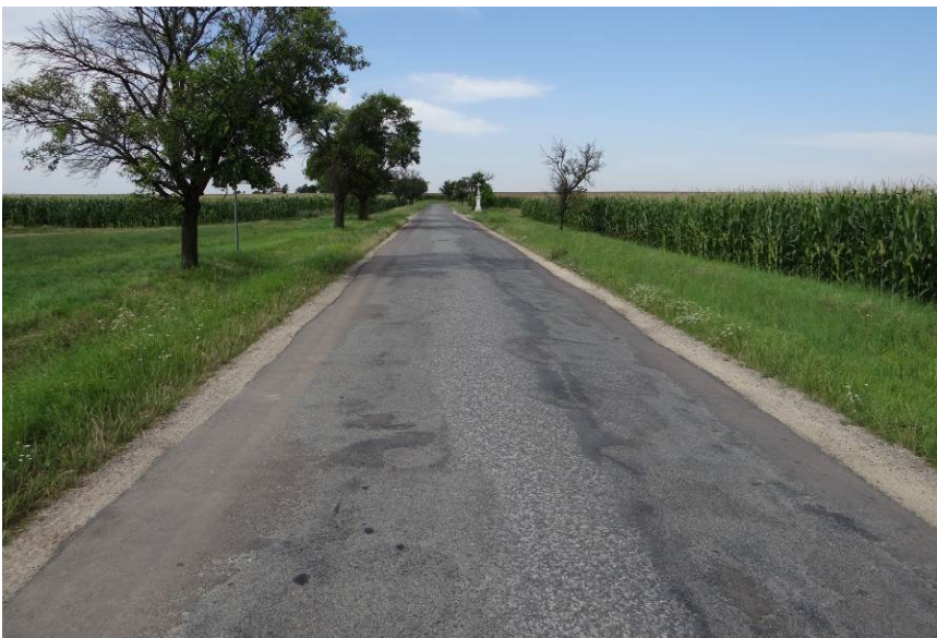
Vysprávky, ztráta makro i mikrotextury
