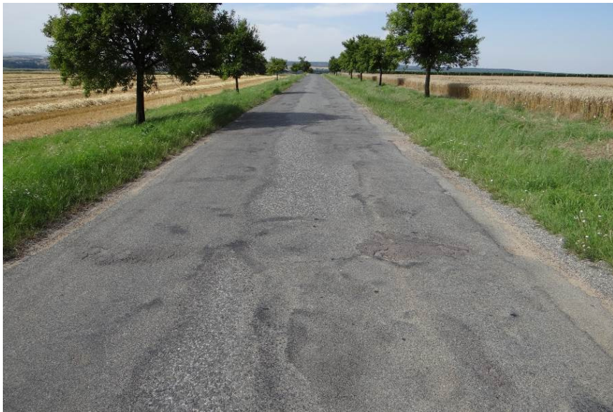
Výtluky, mozaikové trhliny, vysprávkky, ztráta makro i mikrotextury
