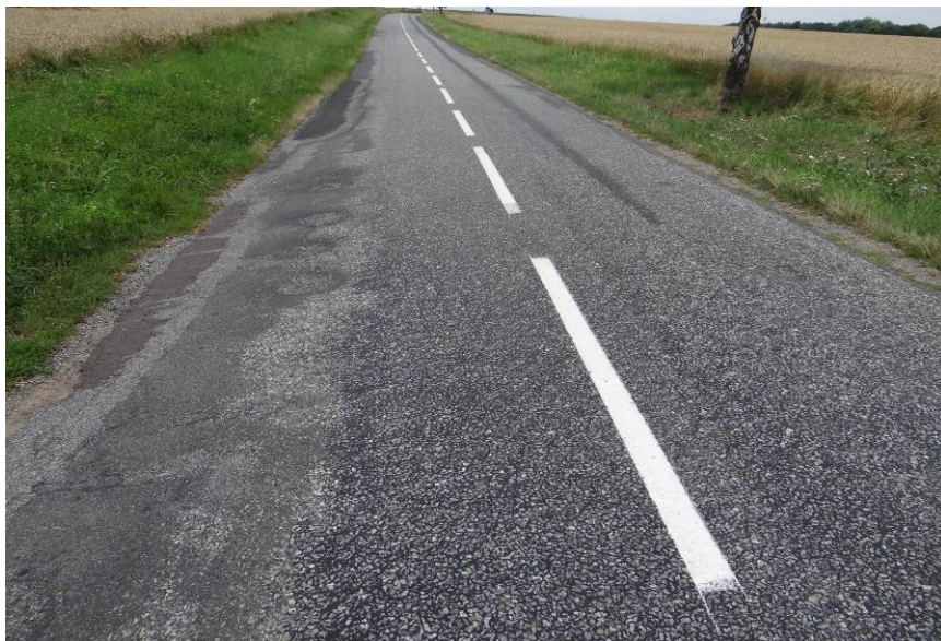
Ztráta makro a mikrotextury, zarostlý příkop, vysprávkky
