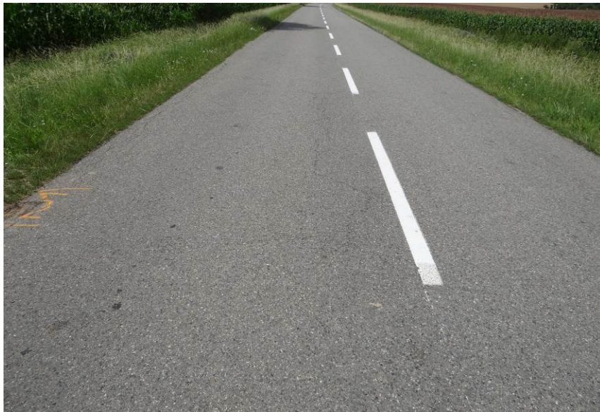
Podélná rozvětvená trhlina
