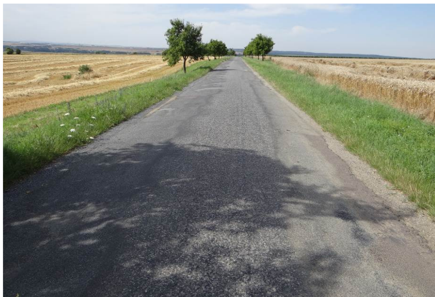
Poškozený okraj vozovky, vysprávky, ztráta makro i mikrotextury
