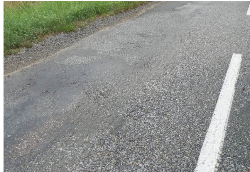
Vysprávk, síťové trhliny, ztráta makro a mikrotextury
