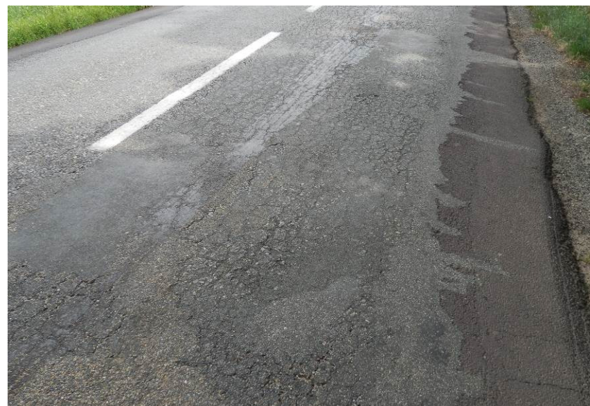
Síťové trhliny, vysprávk, ztráta makro a mikrotextury
