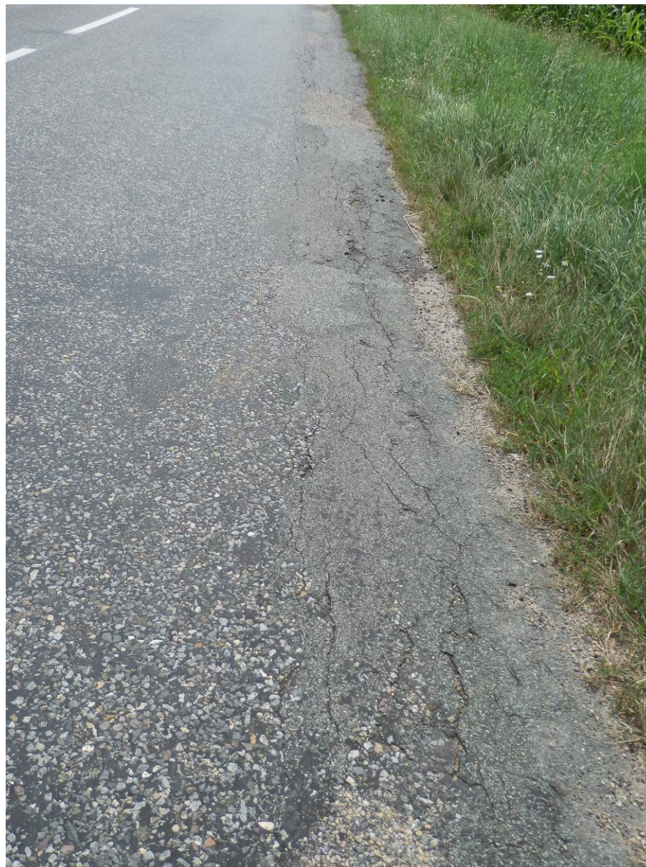
Poškozený okraj vozovky
