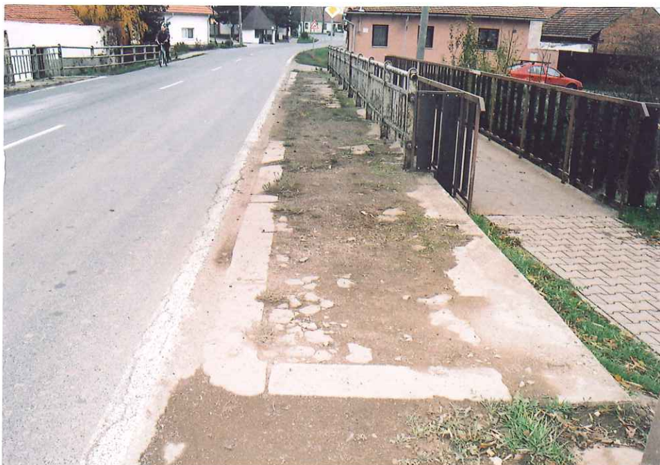
Obr.886-25 Pravostranný, povodní chodník a přilehlá vozovka.
