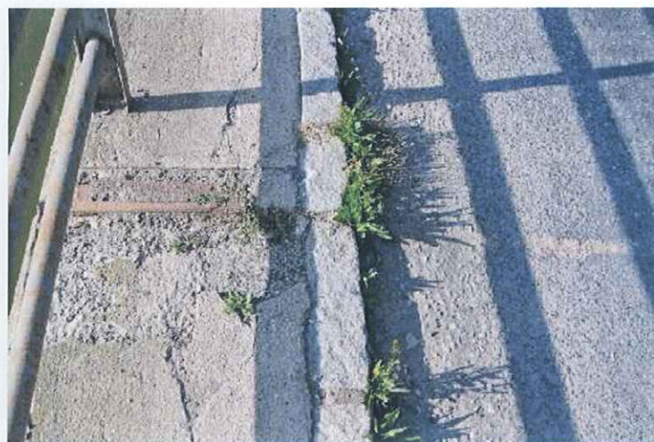
popraskaný beton odrazného proužku vpravo, tráva v krajnici
