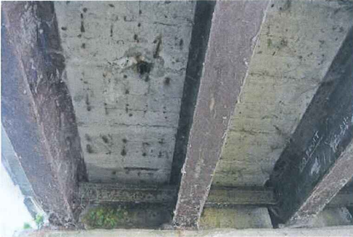
podhled žb mostovky v 6. poli u opěry II
