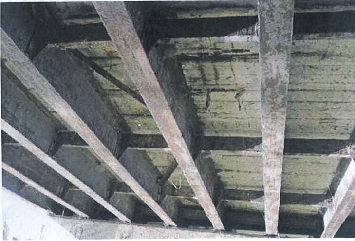
podhled NK 6. pole
