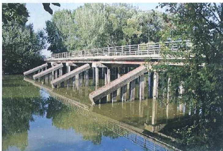
zprava od opěry II
