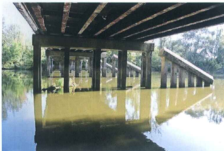
podpěra III + 2. pole
