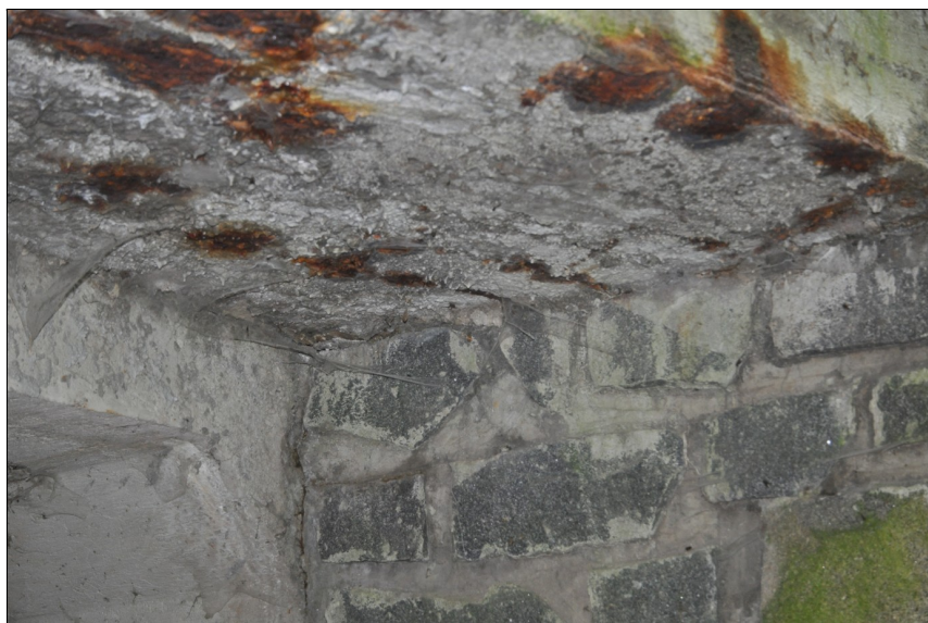
Dobetonávka nosné konstrukce vpravo.
