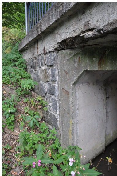
Křídlo u opěry 2 vlevo a uražená hrana monolitické dobetonávky nosné konstrukce.
