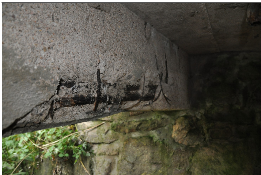
Oslabený krajní trám vlevo - s opěrou 2.
