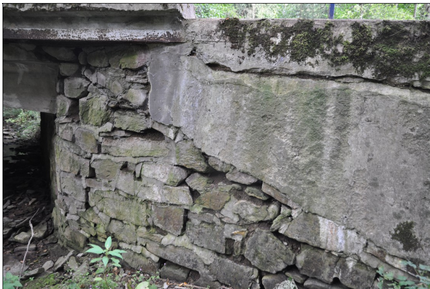
Opěra 1 s křídlem vlevo je nebezpečně rozvolněná.
