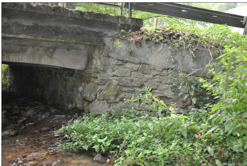
Křídlo u opěry 2 vpravo.
