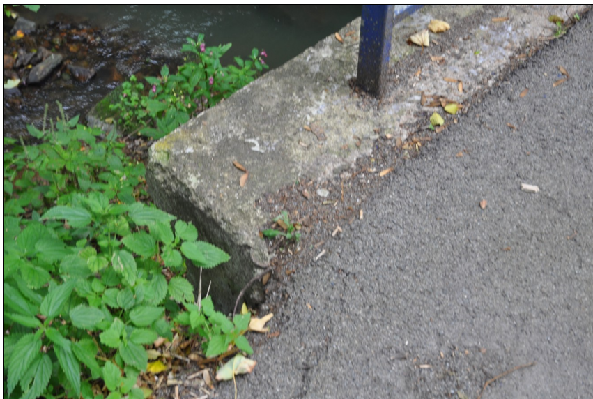
Voda stékající za křídlem vymílá zeminu silničního tělesa.
