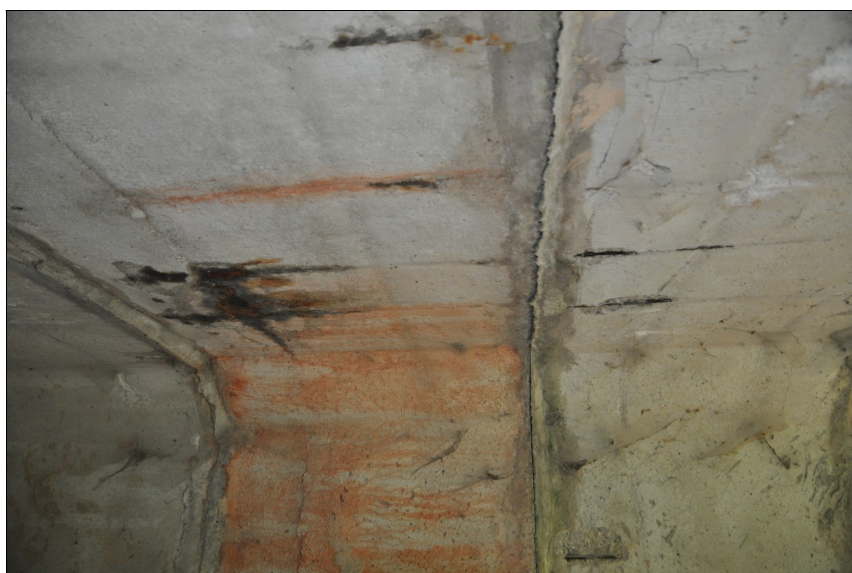
Korodující a oslabená výztuž na horní příčli rámu vlevo.
