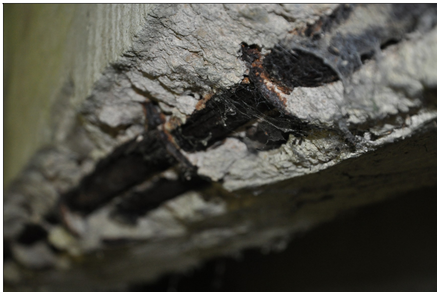
Oslabený průřez výztuže v krajním trámu vpravo.
