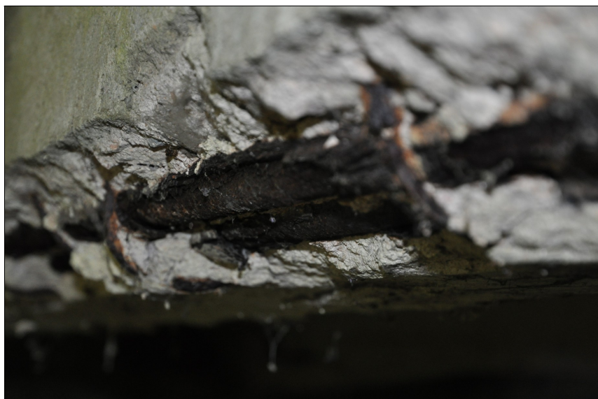
Detail z předchozí fotky, průřez výztuže je silně oslaben.
