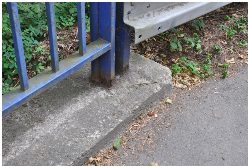
Koroze zábradlí vpravo.
