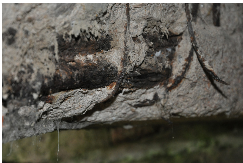
Oslabený průřez z předchozí fotky.
