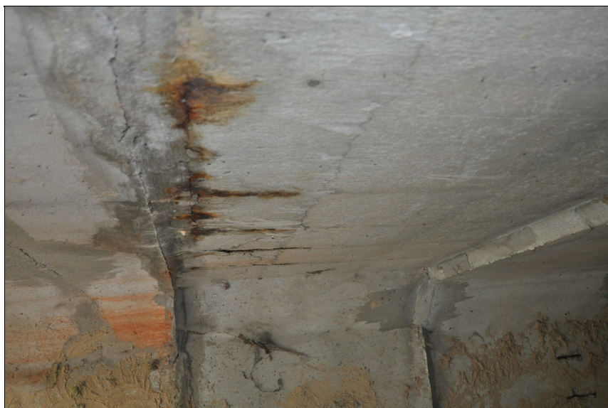
Korodující výztuž horní příčle.
