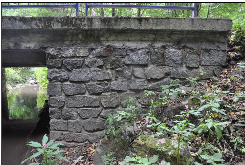
Vyklánějící se část opěry 1 vlevo.
