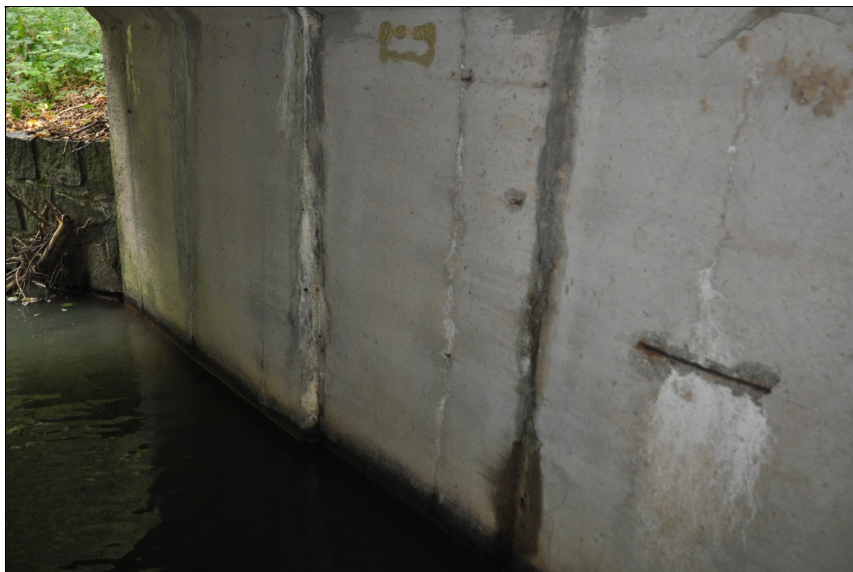
Poškozená opěra 1 vpravo.
