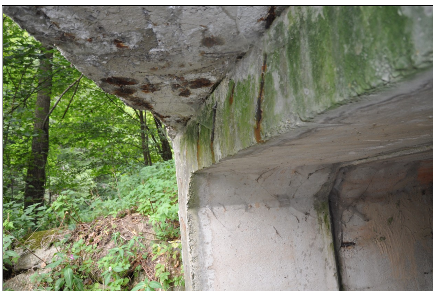
Dobetonávka nosné konstrukce vlevo.
