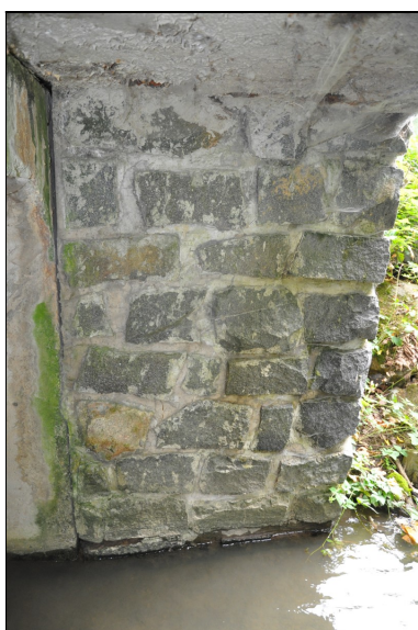
Vyklánějící se část opěry 1 vlevo.
