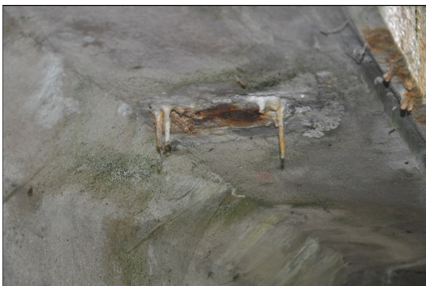
Zvodnělá nosná konstrukce uprostřed rozpětí vlevo.
