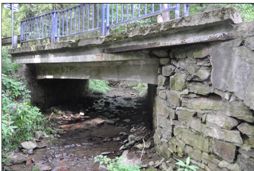
Opěra 1 s křídlem vlevo je nebezpečně rozvolněná.
