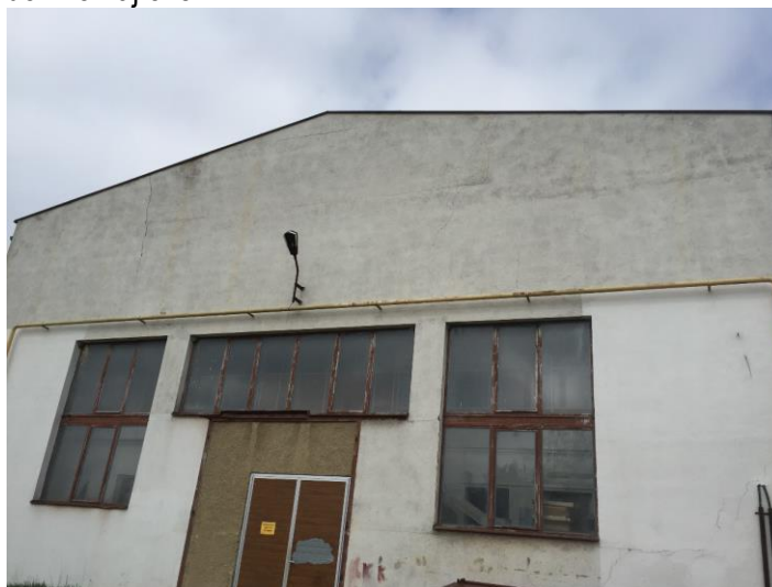
Trhliny v zadním průčelí.
