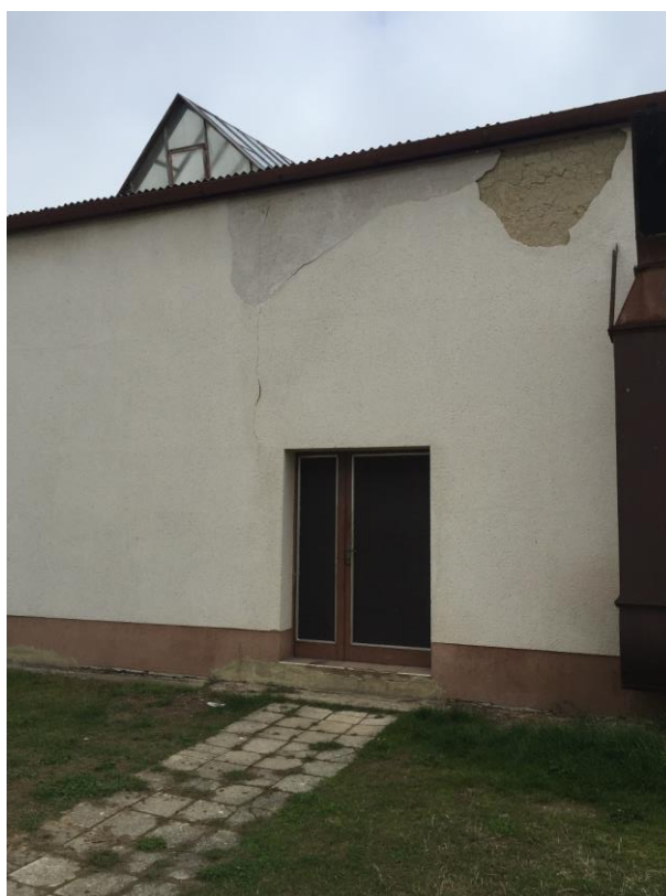
Typické trhliny v boční obvodové stěně
