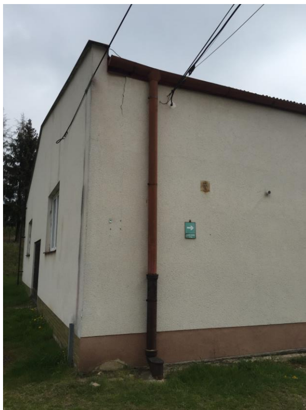
Trhliny v obvodové stěně na spoji průčelí a boční stěny
