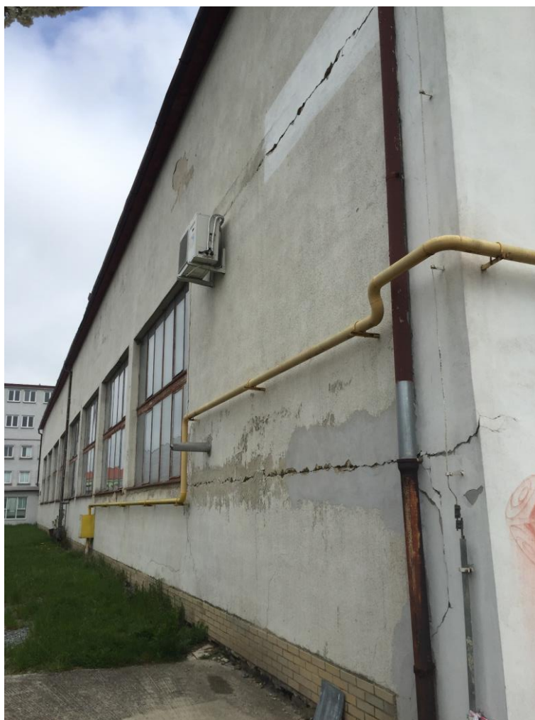
Vodorovné trhliny a šikmé trhliny v obvodové stěně.
