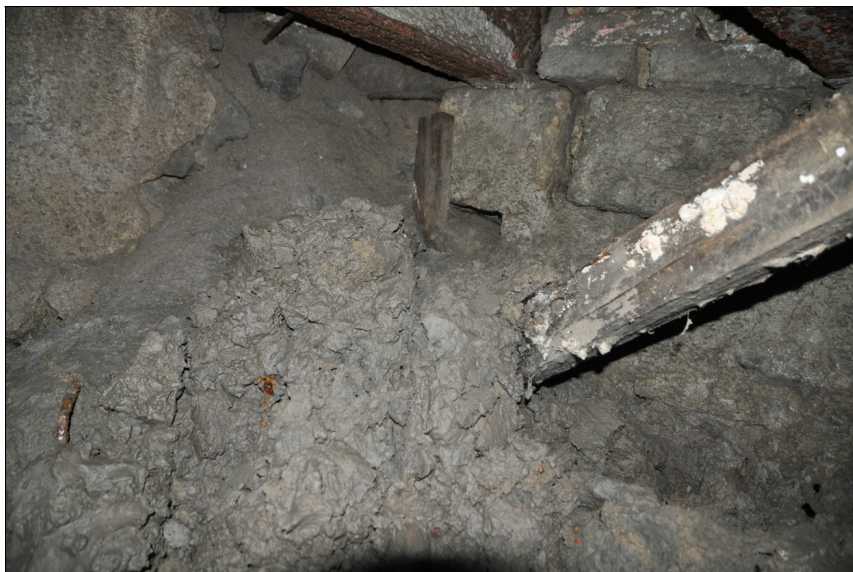
Opěra 2 vlevo těsně u přítoku. Je ukončena jakýmsi slepencem pro dozvěnění díry.
