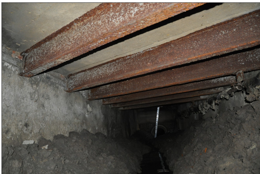
Prostor pod mostem je plný bahna, které je obtížné zlikvidovat.
