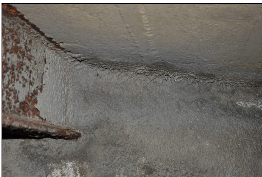
Celý prostor byl nastříkán jemným cementovým torkretem.
