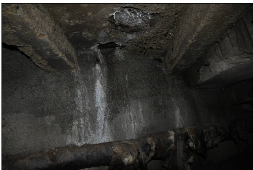
Potečený přesypaný strop pod chodníkem.
