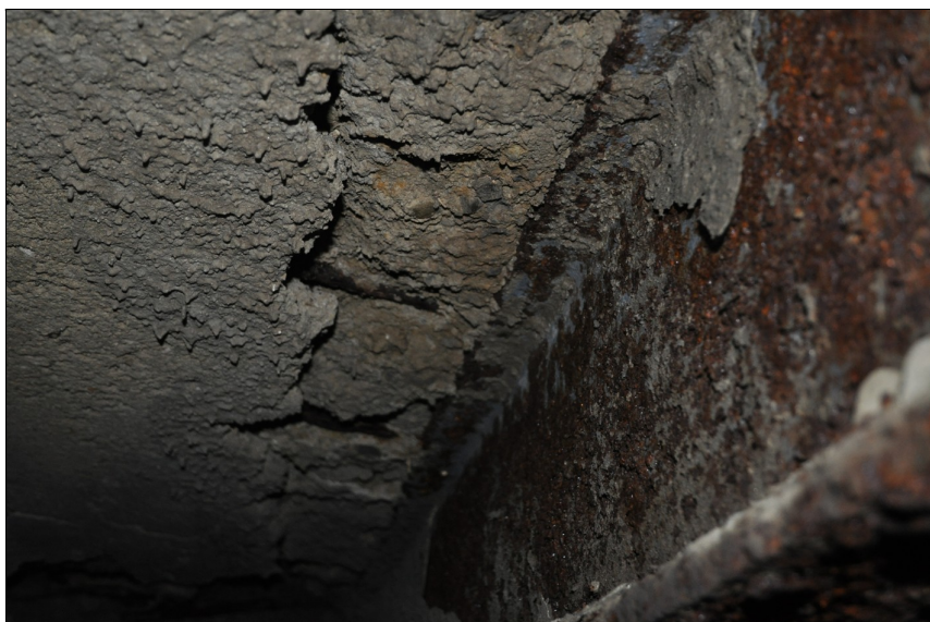
Rozpadající se beton desky v místě pod vozovkou sil. II/431.
