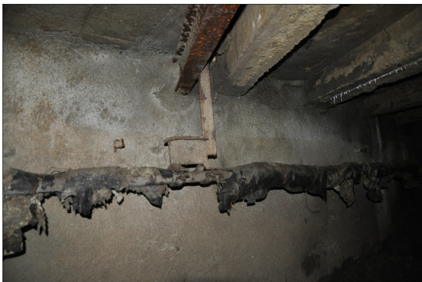
Kombinace stropních konstrukcí je nepřehledná, ale je jasné, že betonové žebro má promáčenou trhlinu.
