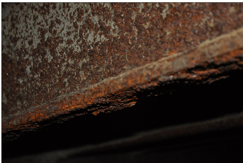
Koroze nosníků pásnic.
