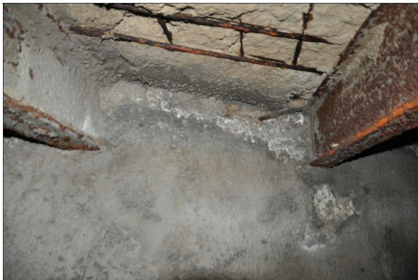
Obnažená výztuž u opěry 2. Beton je zdegradovaný. Rozpadající se beton desky v místě pod vozovkou sil. II/431.
