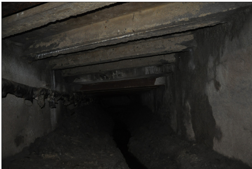
Ocelové profily s betonovou deskou nad nimi.
