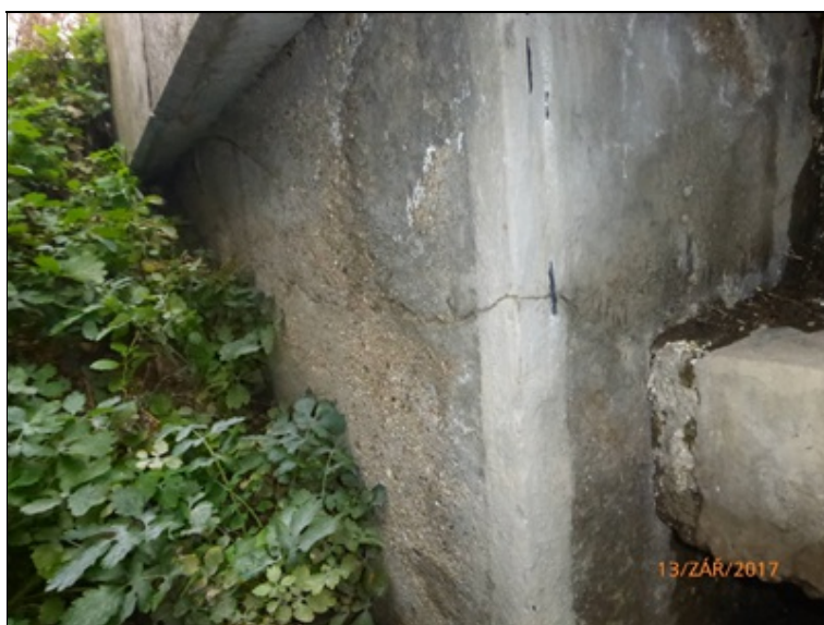
OP1 pravé křídlo - vodorovná trhlina
