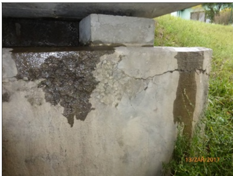
OP1 levé křídlo - zatékání na práh, trhlina, degradace betonu
