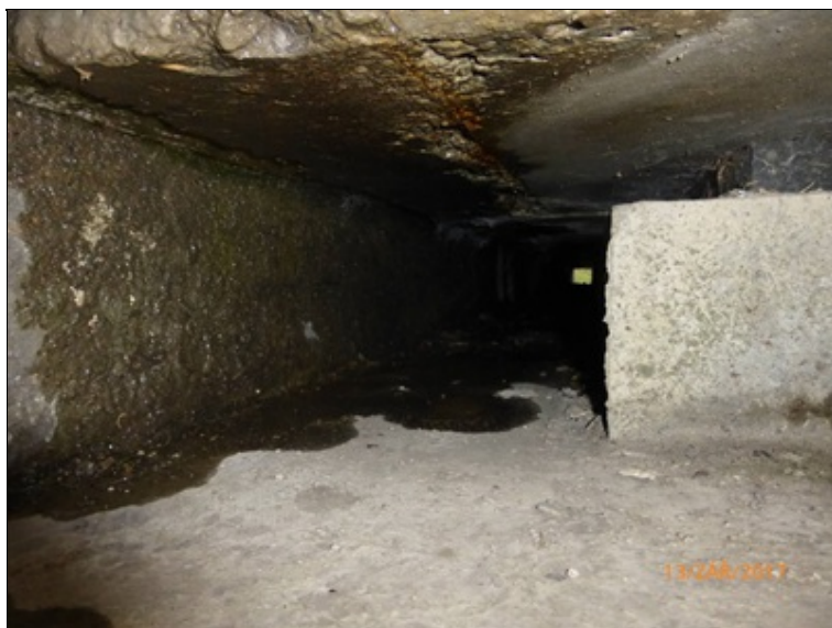
OP1 - zatékání na práh
