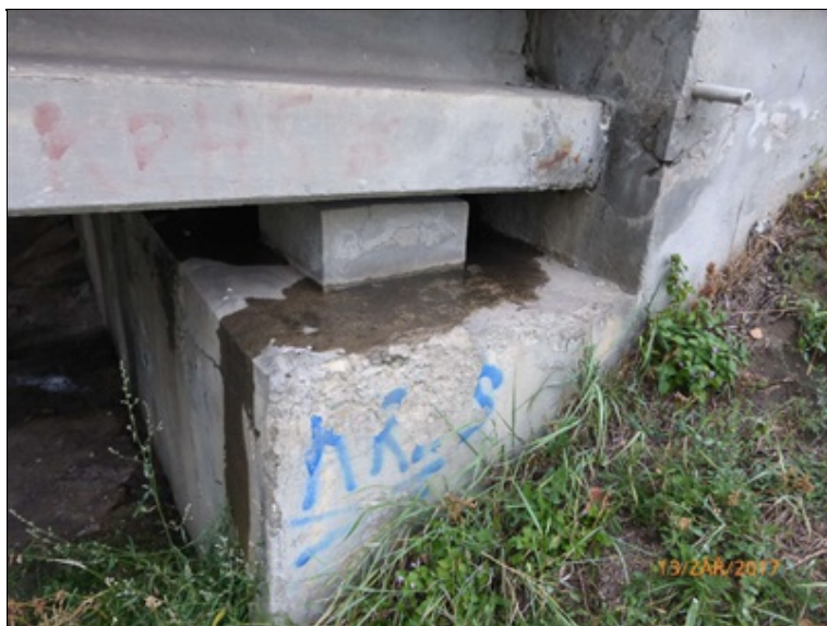
OP1 levé křídlo - zatékání na práh
